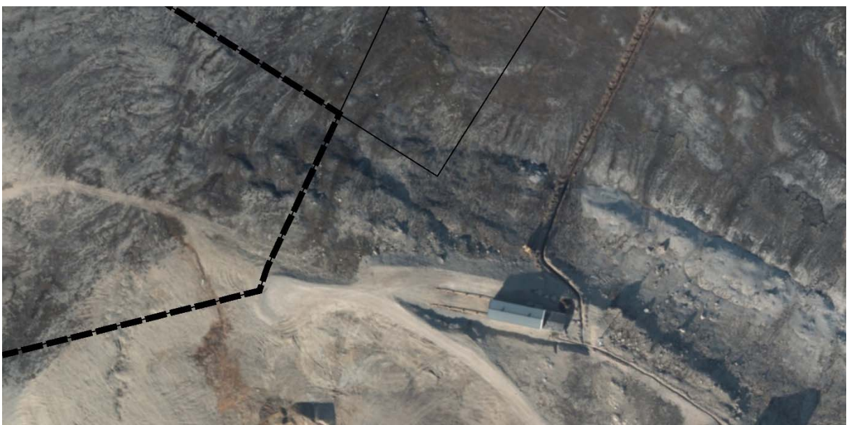
Oversikt over tiltaksområdet. Merk at den nye vegen ikke framgår på flybildet.
