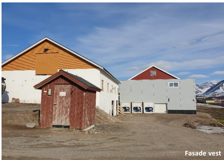
Figur 2. Kongsfjordhallen med tilbygg – eksisterende situasjon (foto: Kings Bay, juni 2022)
