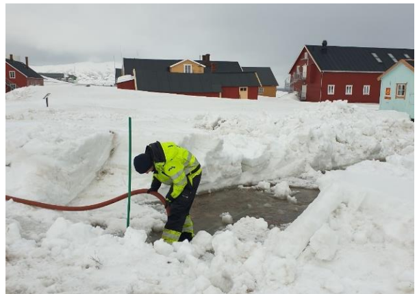
Figur 13. Tette stikkrenner, mars 2022
