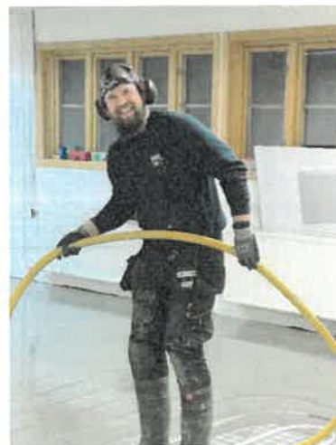
Etterarbeid etter refundamentering: Støpning av gulv i Butikken. Foto: Bodil Haugvik.
