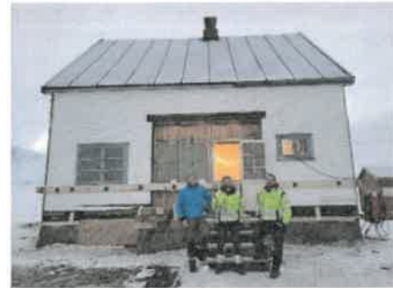
Refundamenteringen og rehabiliteringen av Hvitt Hus startet i 2023. Foto: Sunniva Berge Mo.
