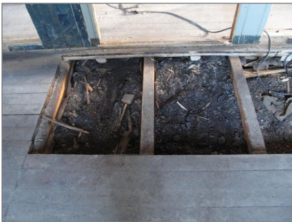
Nr. 14 Amundsenvillaen. Opprinnelig gulv med kullsubb i stubbloftet. Denne ble bevart og supplert med tilleggisolasjon. Under arbeid 2010.
