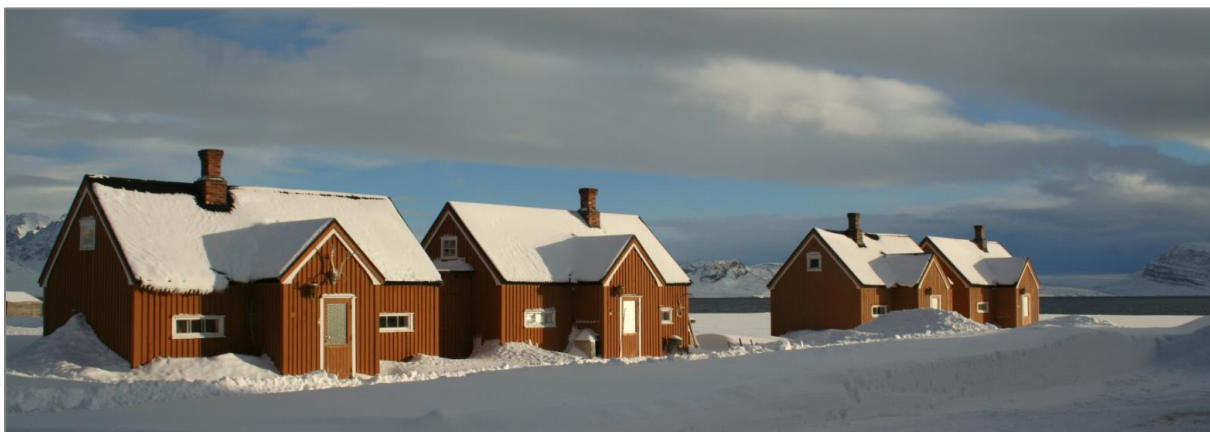
De fire London-husene i 2007. Tidligere var husene malt i ulike farger. Foto: Linda Bakken, Kings Bay AS
