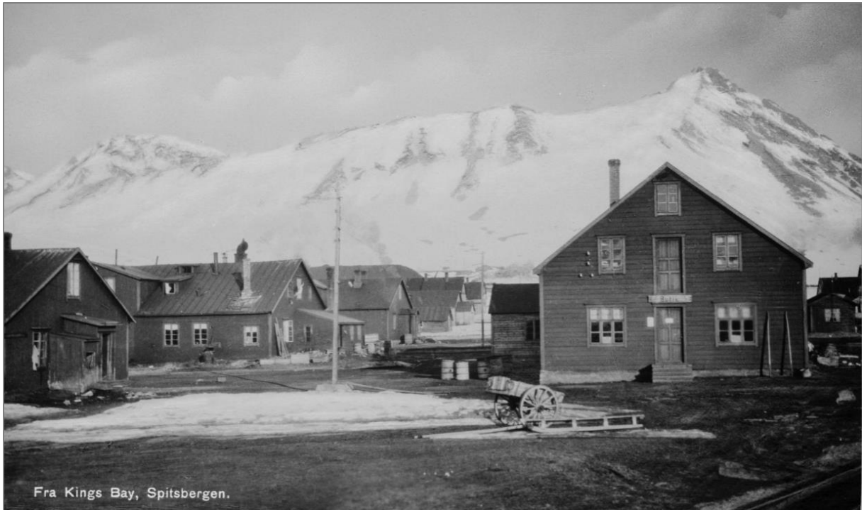
Postkort Mittet & Co. 1925. Til venstre ligger tre brakker/messe fra 1917–18, til høyre Lager nr. 3, der det ble innredet butikk med ny inngangsdør mot nord (nå nr. 32 Museet). Alle disse bygningene har nå fått murte piper i stedet for de enkle røykrørene. Kilde: Nasjonalbiblioteket (nb.no)
