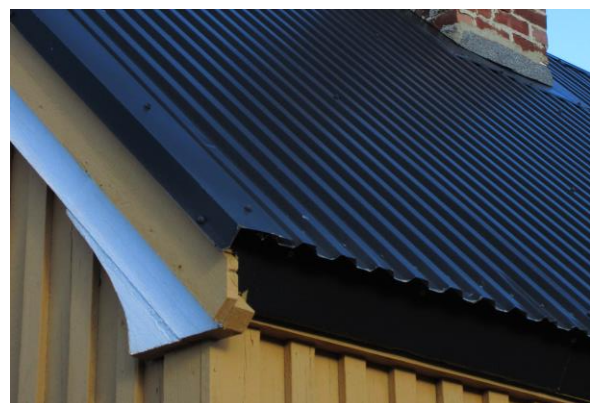
Typisk London-hus med korrugerte stålplater og opplettet tak, med dertil økt høyde og ekstra vindski i gavl. Løsningen bryter med tradisjonen.
