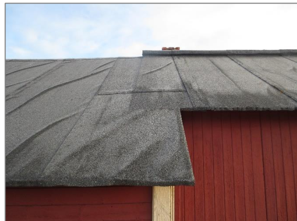
Nr. 3 Green Harbour. Tradisjonell papptekking med stiftet søm i skjøtene. Bevart mønekam på den ene delen av bygningen, som opprinnelig.
