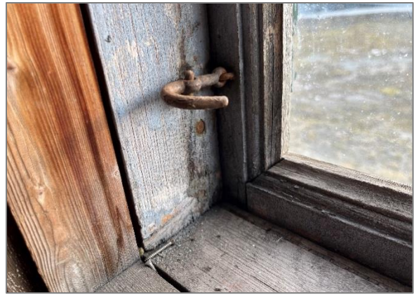
Nr. 21 Hvitt hus. Opprinnelig vindu fra 1919 i bod (flyttet), tidstypisk haspe og profil med hulkil og staff på ramme. Nedslitt maling bør bevares uten oppmaling, viktig dokumentasjon i rom uten bruk.
