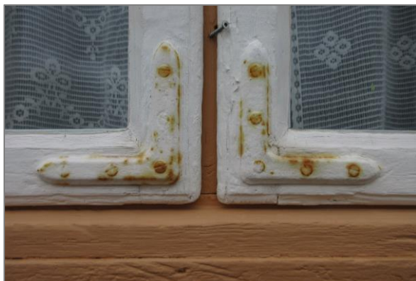
Nr. 4 Museumshytta. Formpressete hjørnejern på vindu fra 1919. Lignende beslag ble brukt på flere hus fra 1917–19, svært høy verneverdi.
