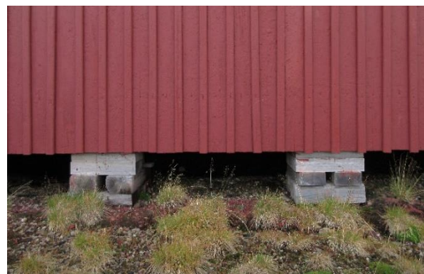
Nr. 28 Samfunnshuset. Fundament av krysslagt boks, opprinnelig løsning 1945.
