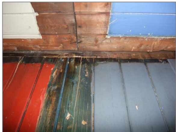
Nr. 14. Amundsenvillaen, under restaurering i 2010. Blågrønn grunning/impregnering ble avdekket på vegger med faspanel bak opprinnelige skillevegger i stuene i 1. etasje.
