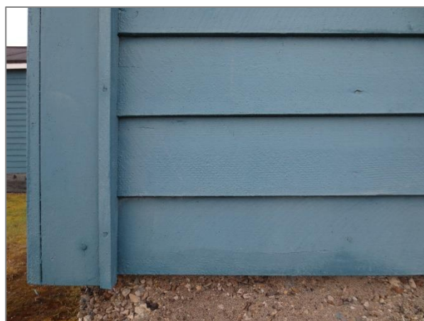
Nr. 23 Blått hus. Liggende enkeltfalset kledning fra 1961. Panelet inngår i en helhetlig modernisering av huset i 2. driftsperiode og representerer en viktig fase i gruvebyens historie. Dette bør bevares.
