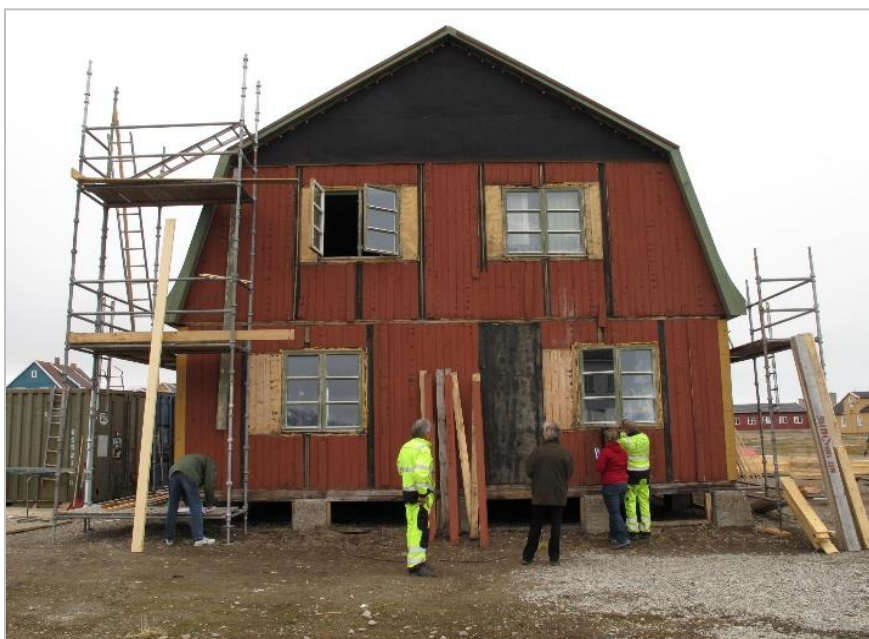
Amundsenvillaen ble i 2009–11 tilbakeført til utseendet fra 1. driftsperiode. Dette skjedde på dokumentert grunnlag, med avdekking av opprinnelig panel, tilbakeføring av vinduer mv. Foto: Siri Hoem 2010
