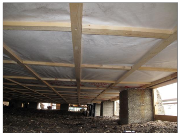
Nr. 14 Amundsenvillaen. Etterisolering med cellulosefiber under dekket for å bedre isolasjonen mot terreng.
