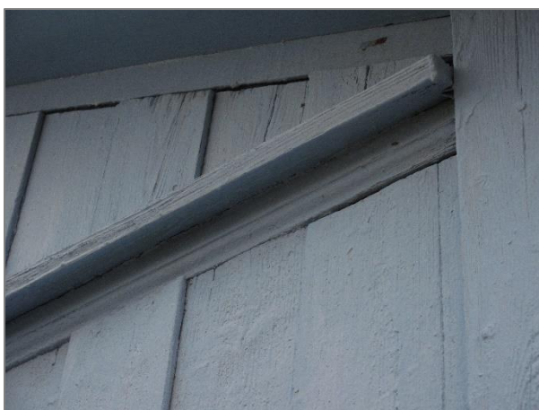
Nr. 6 Veteranhytta. Opprinnelig vekselpanel fra 1918, med profilert gesimsbånd (karniss) og vannbrett under gavlparket. Slike detaljer er svært viktige å bevare, de har høy kildeverdi og opplevelsesverdi.
