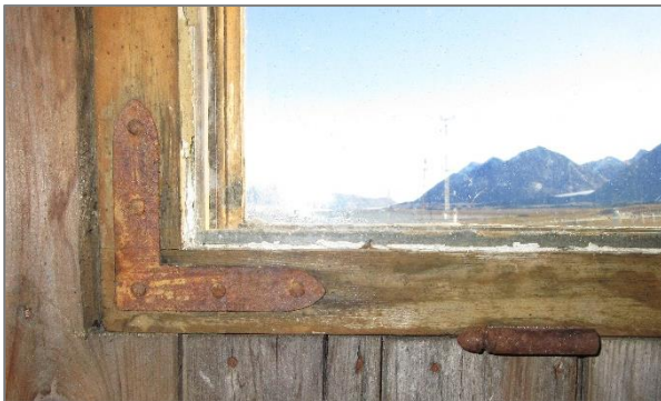
Nr. 16 Telegrafan. En gammel utvendig ramme med eikenøtthengsler er gjenbrukt som varevindu.
