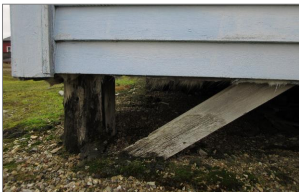
Nr. 6 Veteranhytta. Kraftig pelefundament med kryssavstiving, noe nedsunken i terrenget. Opprinnelig løsning fra 1918, jordvoll er fjernet.
