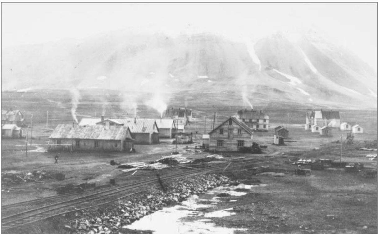
Leiren 1917–20, antatt 1919, siden taktekkning pågår på Sykehuset (bak til høyre), som ble oppført samme år. I «hyttebyen» ser vi at de fire hyttene fra 1919 er nyoppført og umalt, eventuelt malt i en lysere farge enn de fem rødmalte seksmannsbrakkene fra 1918. (To seksmannsbrakker er skjult bak det sentrale lagerbygget, nå nr. 32 Museet.) Se del 5 katalog for mer om hver enkelt bygning. Foto: ukjent, Svalbard museum, SVF 18007
