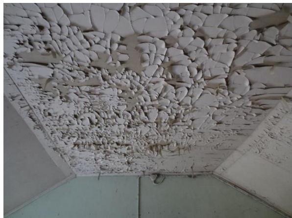
Nr. 34 Posten. Platekledning med avskallet maling. Så fremt huntonittplatene er hele uten store vannskader, kan de bevares. Maling skrapes forsiktig ned og ny linoljemaling påføres.
