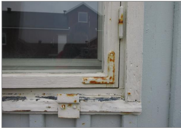
Nr. 24. Sykehuset. Typiske vindusdetaljer fra 1945 på svenskebrakke. Formpresset hjørnejern (svensk type), enkle kanthengsler, sinkbeslag på vannbrett og rester av beslag etter lem.
