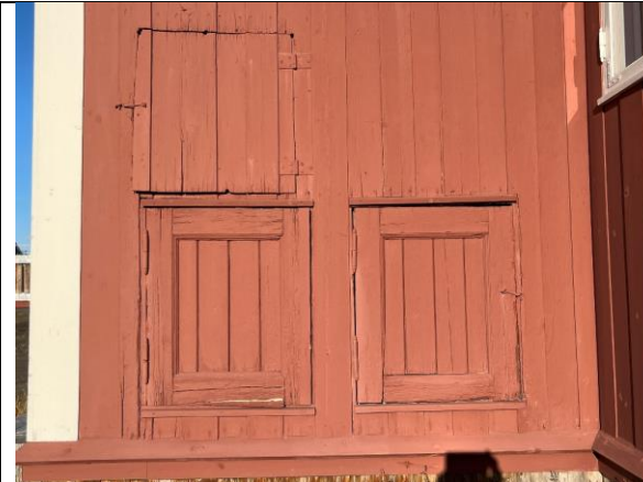
Tre luker i bislag mot vest. To opprinnelige luker med ramtrekonstruksjon, og en sekundært utskåret luke. Her var det kullbinge, trolig også bøttedo.
