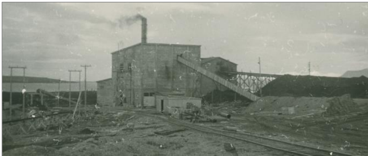
Bildetekst: «Kraftstasjonen og det nye tilbygget.» Antatt kort etter 1957. Bygningen med saltak fra 1949 til høyre. Foto: Ukjent. Svalbard museum, SVF 00075 (beskåret)
