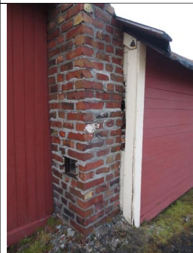
Pipa er dels murt i forband med en brannmur bak veggen i vestre hus.
