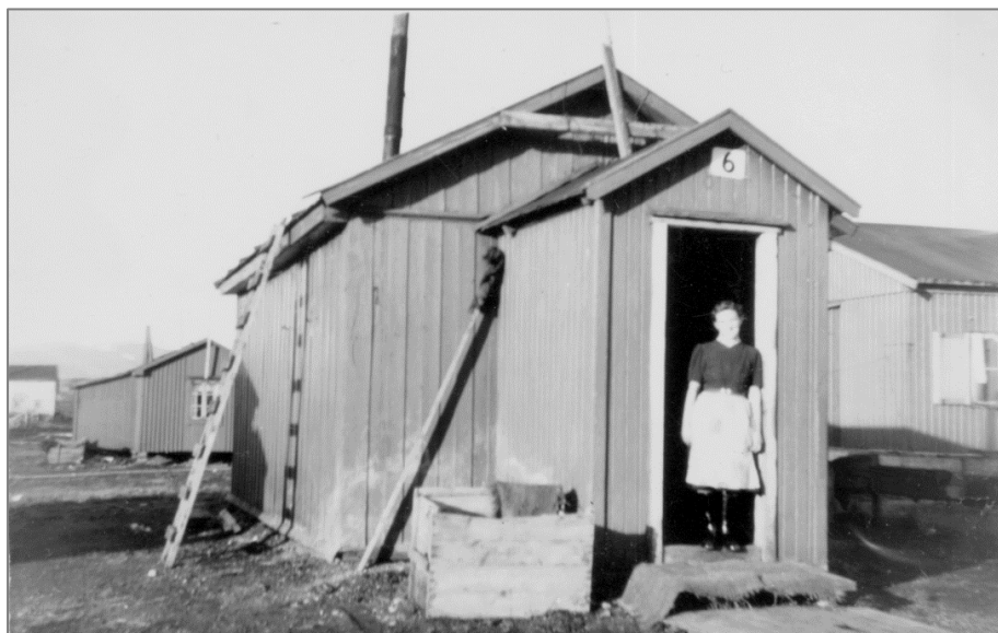
Ragna Grefstad foran hus nr. 6 i 1948–49. Eksteriøret er som opprinnelig, med vekselpanel fra 1918 på hovedhytta og faspanel på bislaget. Skiltet med nr. 6 står stadig på veggen i dag, dog helt nedslitt. Bislaget fikk ca. 1950 tilbygg på hver side. Merk takutstikket på bislaget. Foto: Richard Grefstads samling, Svalbard museum, SVF 06255
