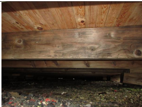
Opprinnelig bjelkelag med lufting mot grunnen.
