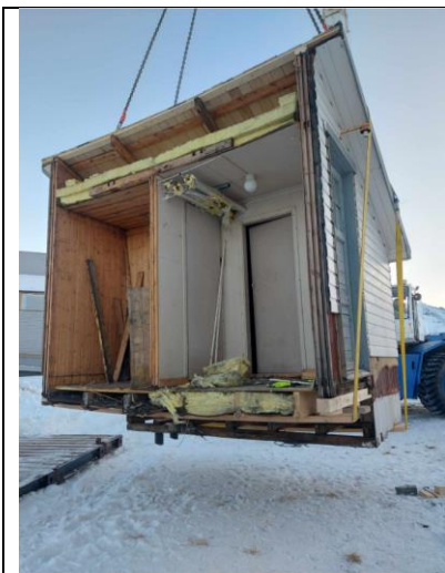
2023: Bislag øst på flyttefot. Vi ser inn i opprinnelig del fra 1919, med senket himling. Pulttaket ble fornyet ved oppføring av tilbygg få år senere. Foto: Lervike AS
