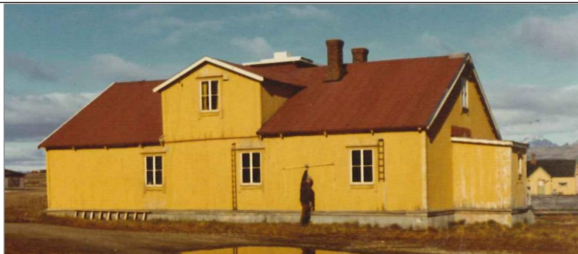
Skolen i 1973, med rød takpapp. Merk den rødmalte kledningen over tilbygg/bislag mot øst, muligens spor etter et høyt beslag. I det røde partiet skimter vi et umalt felt bak opprinnelig saltak på bislaget fra 1917. Foto: Rapport Reinertsen/Arkiplan 1973, Kings Bays arkiv
