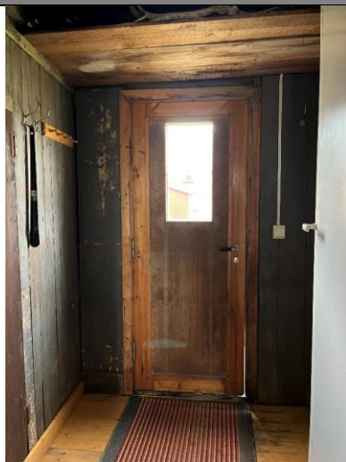
Opprinnelig bislag sett mot sør. Inngangsdør med huntonittplate og bakelitt dørhåndtak.
