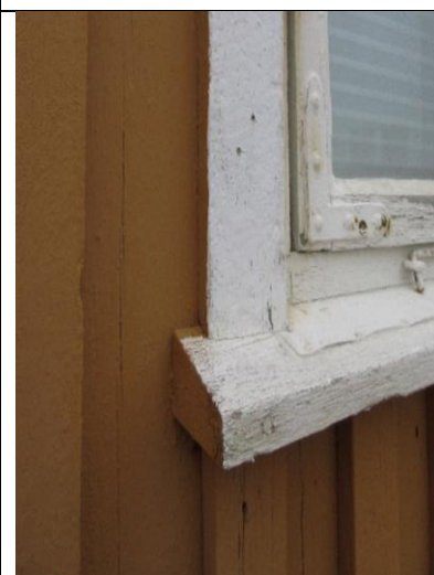
Opprinnelig vindu mot nord, med hjørnejern og beslag på vannbrett.
