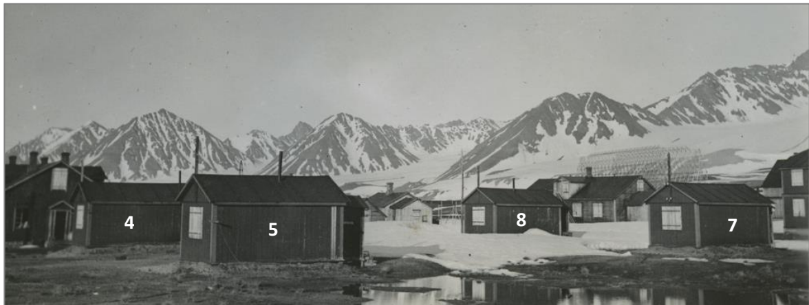
Seksmannsbrakkene i 1935. Fra venstre opprinnelig nr. 4 (flyttet/revet), 5 Arbeiderbrakka, 8 (flyttet) og nr. 7 Sysselfbu. Nr. 6 Veteranhytta ligger t.h. for bildet. Alle hyttene sto sannsynligvis på trepeler med isolerende jordvull omkring. Lemmene tyder på at brakkene sto tomme, da det var driftsstans i gruva på denne tida. Foto: ukjent, Svalbard museum SVF 00530 (beskåret)
