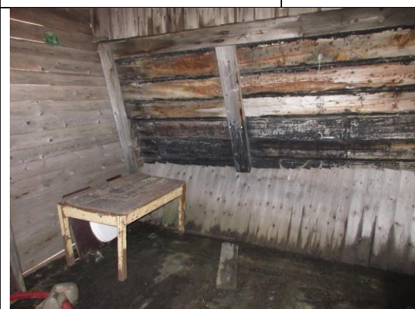
Interiør i tilbygg øst, sett mot bakvegg i kullprammen.
