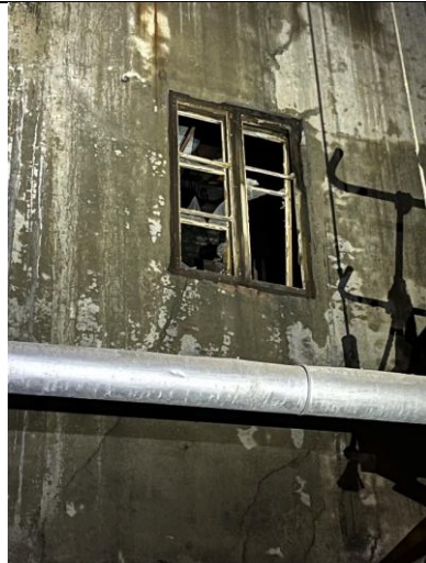
Vindu i opprinnelig yttervegg sør fra 1949. Typisk tofags vindu med varevindu fra 2. driftsperiode.
