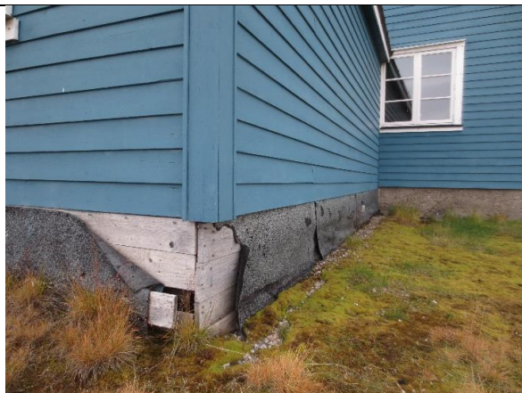
Den tilbyggete brakka mot øst står på trepeler, tildekket med et skjørt av liggende bord og asfaltpapp. Utlektet kledning fra 1961 skjærer inn i vindusomramningen på hovedbygningen.
