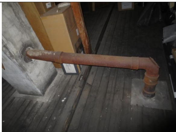
Den østre pipa er bevart med tilkoblet røykrør over loftsgulvet.
