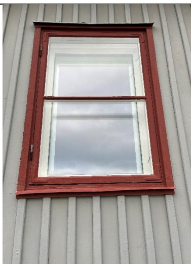
Gjeninnsatt vindu der det en periode var dør mot nord, se LPOs oppmåling 2016 og detalj t.h. Sinkbeslag over vindu, som opprinnelig løsning. Ny kledning under vindu.
