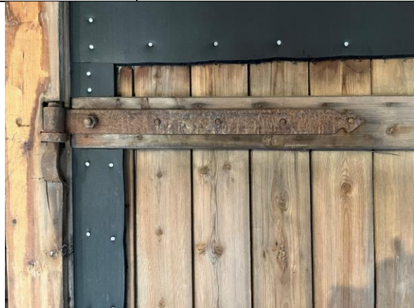
Detalj av porten vist over, tidstypisk beslag og stabelhengsel, antatt opprinnelig fra 1919.
