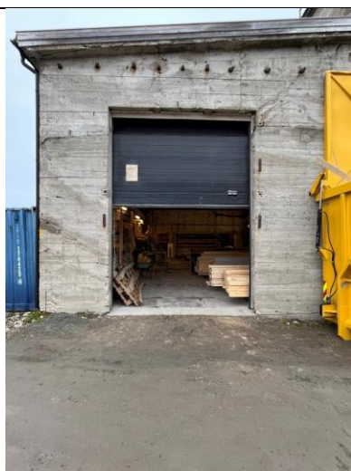
Fasade sør i lav fløy fra 1957. nyere port til Kings Bays materiallager.
