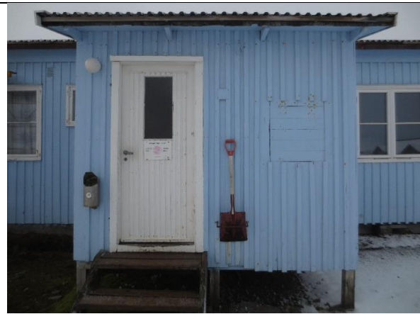
Opprinnelig bislag mot nord, med bygningens eneste ytterdør. Bislaget er delt i to: forgang og en kald bod. I øvre del av veggen mot boden er ei topphengsløst luke med liggende bord, tidligere kullager.
