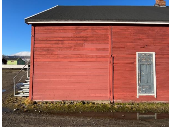
Tilbygget del fra 1919, med ny kledning fra 2014 i nedre del av vegg mot øst. Generelt bredere bordbredder på tilbyggene fra 1919 i hver side av bygningen.
