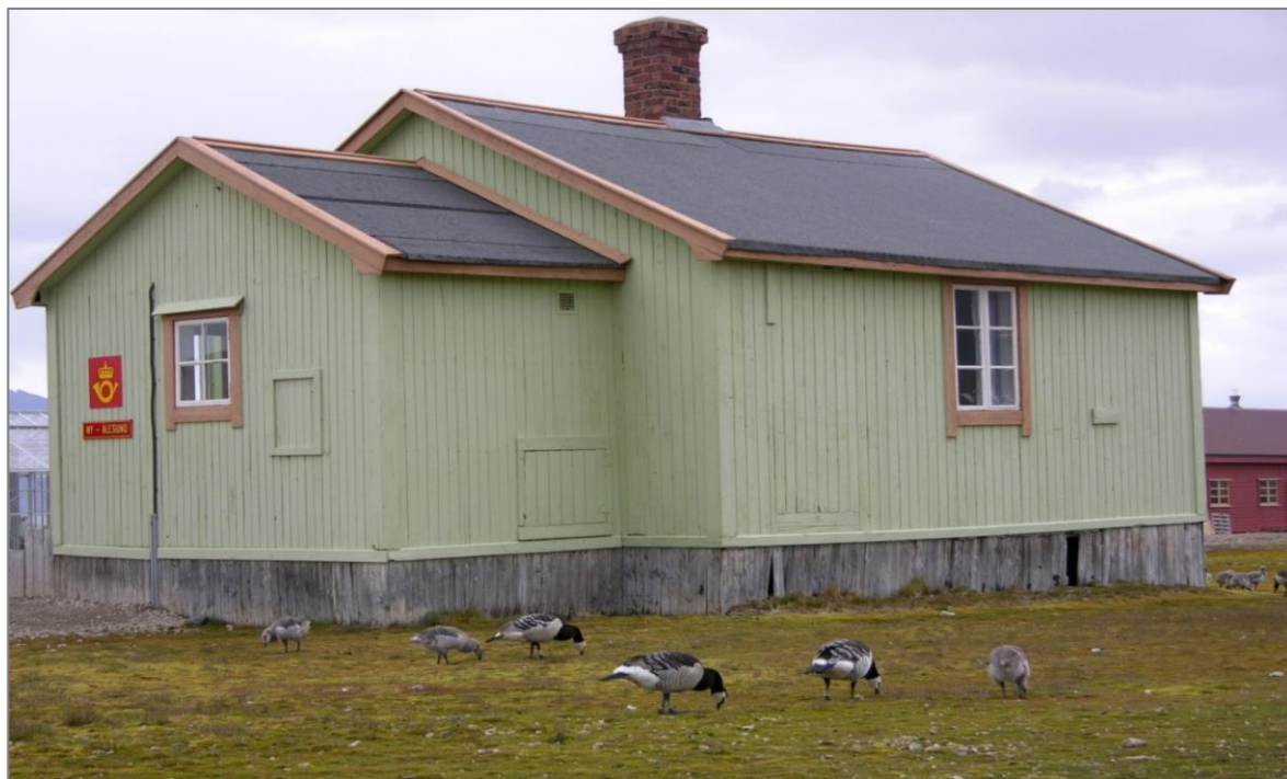
Bildet fra 2004 viser samme situasjon som i dag, men med grønnmalt fasade og uten postkasse på bislaget. (Foto 1979 bekrefter samme situasjon.) De to lukene i bislaget antas å ha betjent kullbinge (vestvegg) og tømning av dobøtte (sørvegg) i 2. driftsperiode. Foto: Kings Bays arkiv
