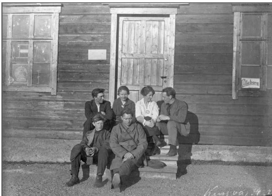
Antatt 1922 (påskrift). Inngangsdør til butikken er nå etablert i kortveggen mot nord. Vinduene har dråpehengsler og er uten hjørnejern. Dør og vinduer framstår umalt, mens kledningen har nedslitt (rød) maling. Foto: ukjent, Svalbard museum
