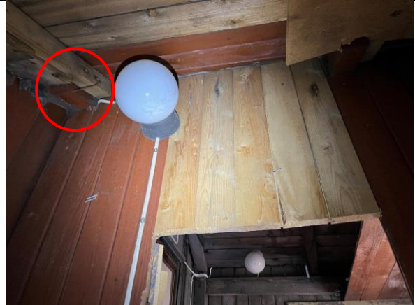
Vestre bod. Inne i bodene ses faspanel og takutstikk med sperreender (rød ring) på opprinnelig bislag, som hadde rødmalt fasade før tilbyggene ble oppført. Umalte bord over senere utskåret dør til tilbygg/do.
