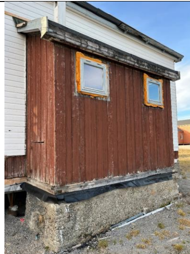
2024: Opprinnelig bislag nord, isolerglassvinduer med byggsaum i opprinnelige åpninger.
