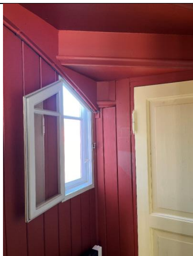
Opprinnelig vindu bevart i rom under trappa, se bildet over.
