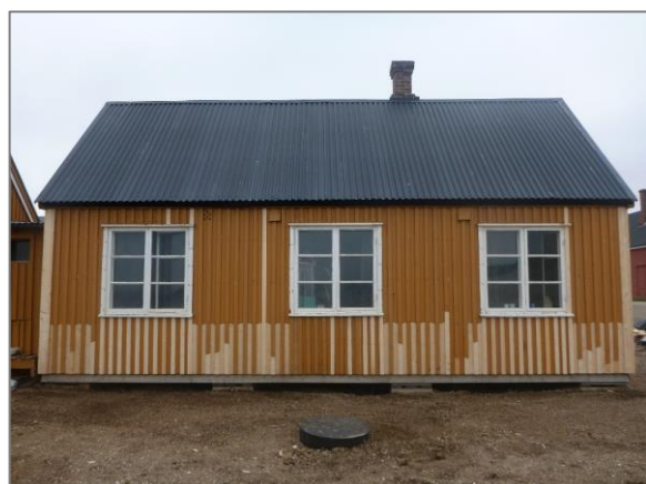
Under istandsetting 2012, med ny vindpapp og utbedret kledning. Foto: Y. Wennevold, Kings Bay
