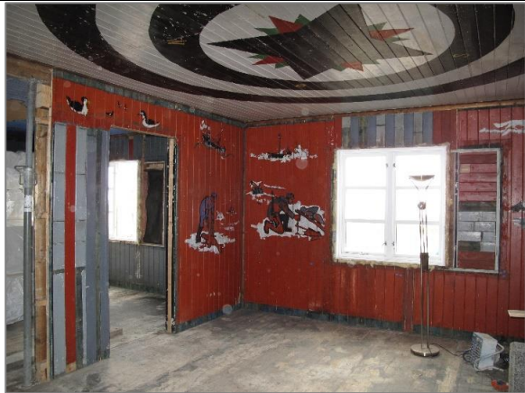
Veggmalierier fra Nordpol bar i 1938 er avdekket. Bemalt kledning var brukt til å tette opprinnelige dør- og vindusåpninger. Foto: Siri Hoem 2010
