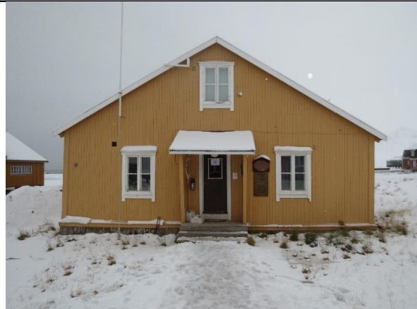
Fasade vest mot veien. Overdekket inngangsparti med pulttak fra 2. driftsperiode.
