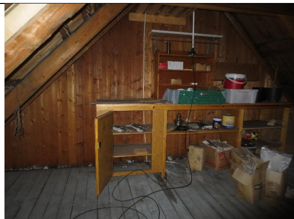
På loftet mot vestre gavl, der opprinnelig gavlvindu må være fjernet eller skjult bak faspanel.
