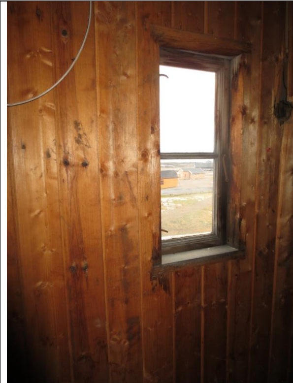
Opprinnelig vindu fra 1919 og faspanel på loftet i østre gavl.
