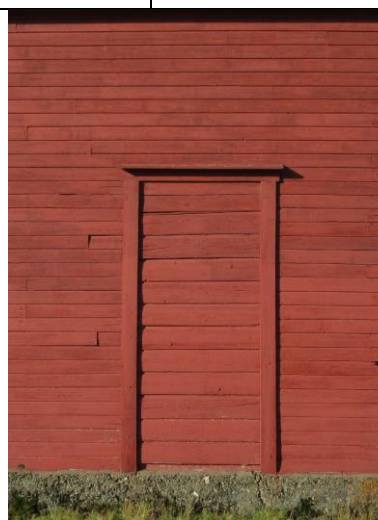
Opprinnelig (butikk-)dør fra 1919 mot øst, blendet etter kort bruk.
