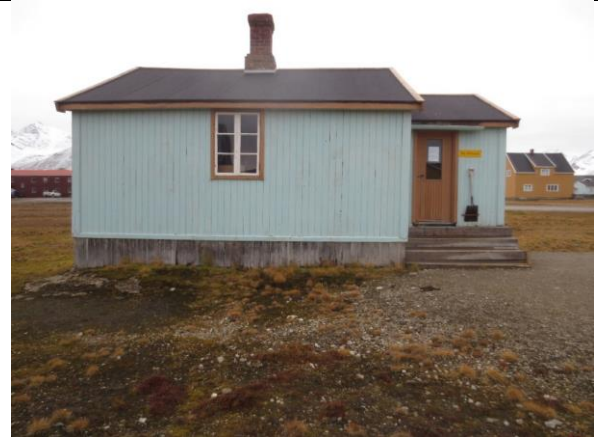
Fasade nord. Opprinnelig vindu. Bislaget fikk ny inngangsdør etter krigen.
