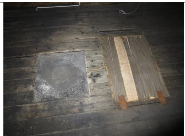
Ved den vestre pipa er røykrøret fjernet og gjennomføringen i gulvet/støpen er tettet.
