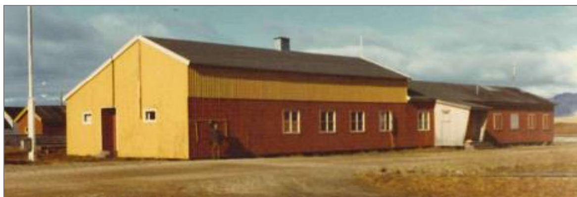
Foto 1973. Salen har fått tilbygg mot vest og påbygg i høyden, alt malt gult. På langveggen mot gata er et vindu blendet, og bislaget har fått ny utforming. Kilde: Rapport 1973, Reinertsen m.fl., Kings Bays arkiv
