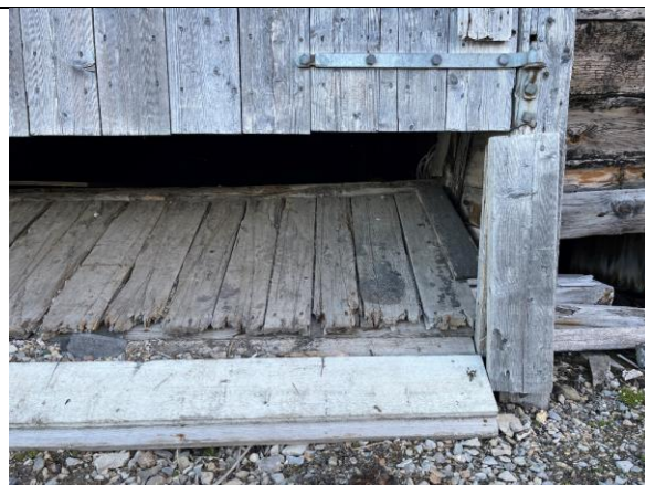
Under de nyere, lave portene i kullpramnaustet er det nå en stor åpning, jf. lemnen som ble påvist i Teppens registrering 2022.
