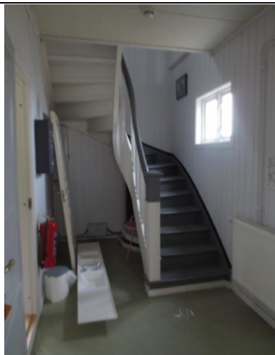
2023: Hovedtrappa fra 1919 er bevart.
