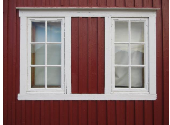
Typisk opprinnelig vindu, med to rammer og midtfelt. Typiske opprinnelige geriker, med vannbrett over hele vinduspartiet.
