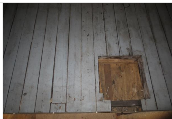
Eldre bordgulv på loftet, antatt tettet åpning for tidligere pipestokk.
