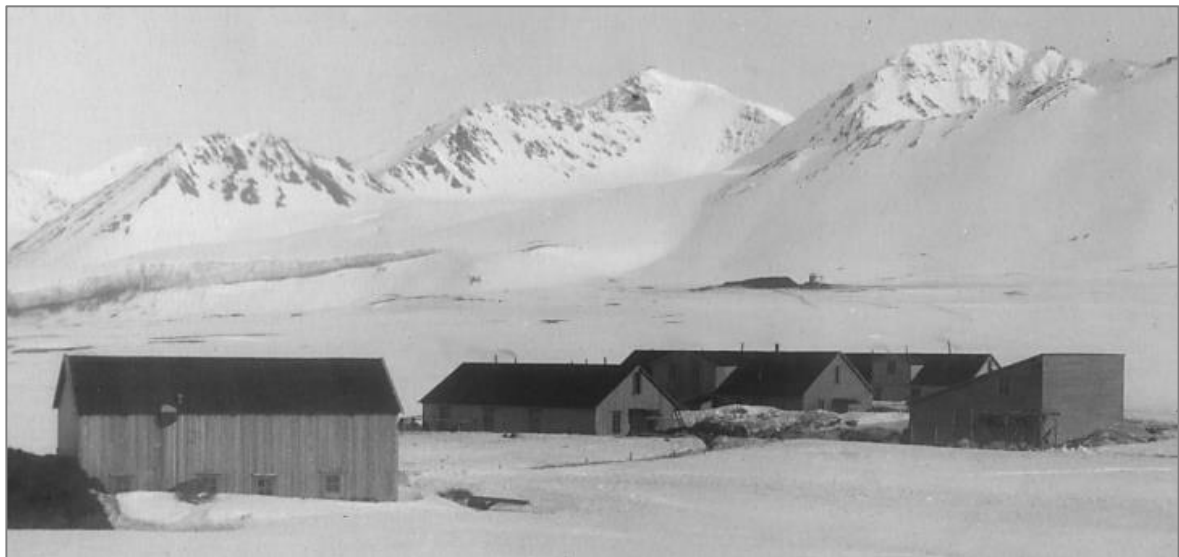
Den første bebyggelsen i leiren mai 1918. De tre parallelle brakkene med gavnl mot «gata» ble oppført vinteren 1917–18, Arbeidermessa i midten. Dagens nr. 2 Skolen er den eneste bevarte (bakerst). Det er ark på loftet og røykrør over tak. Stallen til venstre. Foto: Sigvald Moa, Norsk Polarinstittutt, np003099 (utsnitt)
