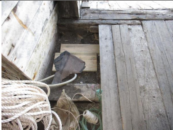
På gulvet innenfor porten er det lagt noen bord over spantene.
