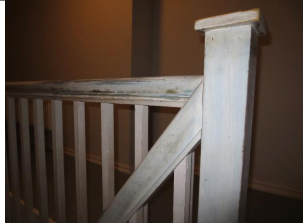
Trapperekker med enkel stolpe og spilerekker. Usikker datering, antatt fra ombyggingen omkring 1958.
