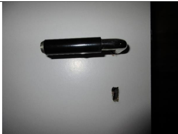
Gammel finérdør (senere malt) med bakelitthåndtak til soverom.
