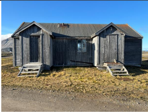
Fasade øst. Hovedform og fasadeutforming er lite endret siden byggeåret. Ny dør i høyre bislag, nye trapper fra 1992. Liggende kledning på sidefeltene fra ca. 1958.
