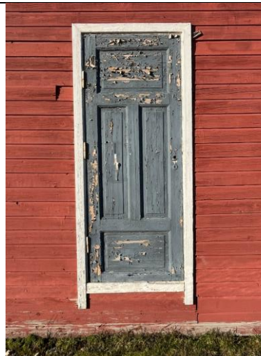
Opprinnelig fyllingsdør mot øst, nå avstengt. Nyere hengsler.
