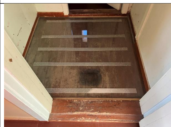
Opprinnelig bordgulv inne i gangen mot vest er beskyttet av en glassplate. Dørstokken er bevart med eldre maling og slitasje. Gammelt svimerke fra bøtte.
