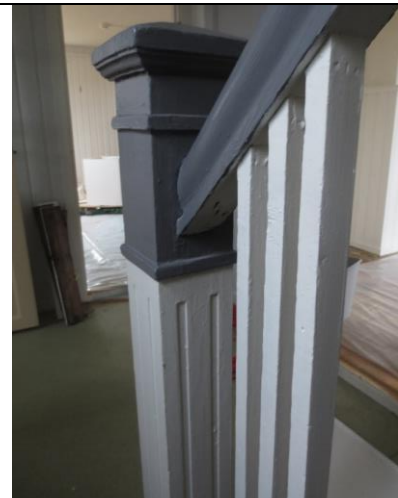
Detalj av trapp, med forseggjort mekler, typisk for arkitekt Flors hus i Ny-Ålesund.
