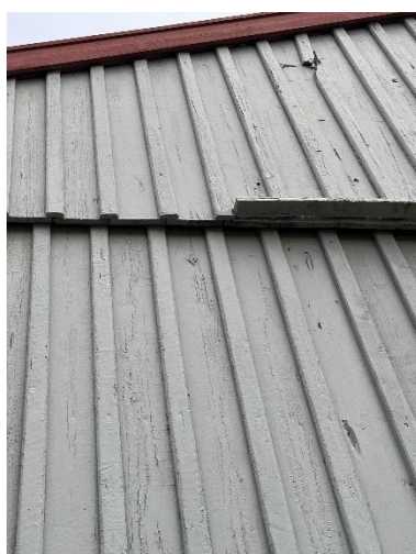
Detalj av gavl øst, der et beslag i panelskjøten antyder bredden på opprinnelig tilbygg med gang, do og kullbod.
