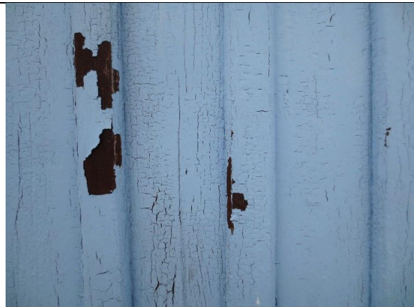
Det er påført lys blå maling i flere lag, med typisk linoljekrakelering. Innerste lag er en mørk brunlig behandling, som var bygningens opprinnelige farge fram til ca. 1960. Se også foto inne i bod.
