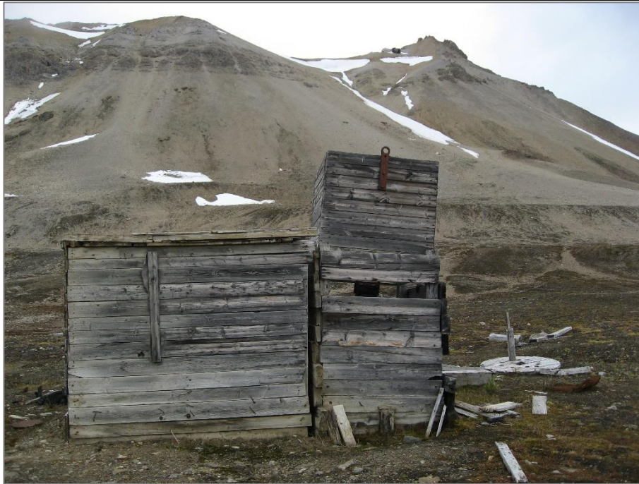
Varmestua med den høye luftesjakta, slik den framsto fem år etter istandsetting. Nytt trevirke har grånet naturlig. Foto Siri Hoem 2009
