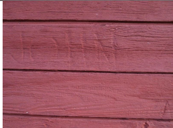
Vestre hus fasade sør. Pløyd liggende kledning, med skåret navn «JOHN».
