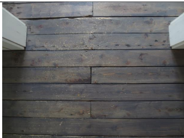
Detalj av bordgulv mellom gang/kjøkken, med spikersømmer etter tidligere huntonittplater. Bordgulvene ble tatt opp og lagt tilbake etter refundamentering og utbedring i 2008.
