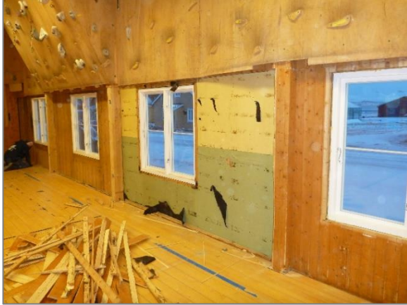
Under arbeid i 2012. Østveggen i salen ble strippet for to lag innvendig kledning før ny isolasjon ble lagt. På bildet t.v. er oljet vekselpanel fra 1962 fjernet og huntonittplater malt i grønt og gult fra etterkrigstida kommer fram. Det ble slått nye plater på veggen. Foto: Kings Bay AS
