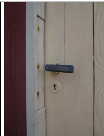
Detalj av døra t.v., glattpanel og enkelt stålhåndtak. Ombygget karm/låskasse.
