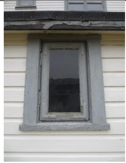
2023: Opprinnelig vindu i bislag øst, i tilbygg (før 1938). Tidstypiske hengsler og beslag (se senere foto), kledning og gerikter fra 1959.
