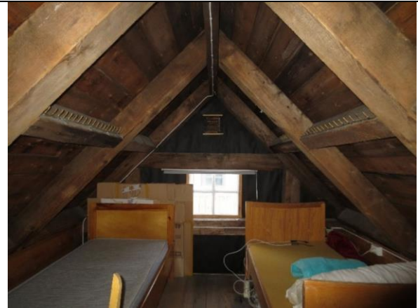
Opprinnelig tørkeloft i loftsrom mot vest. Opprinnelig vindu med fire ruter i gavl.
