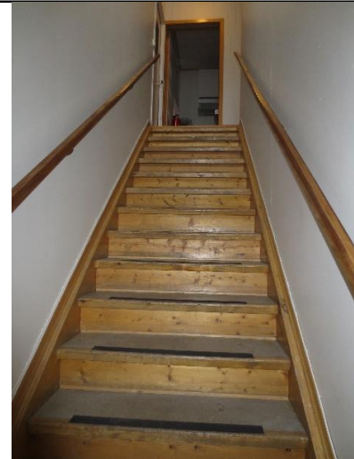
Ombygget hovedtrapp til 2. etasje.
