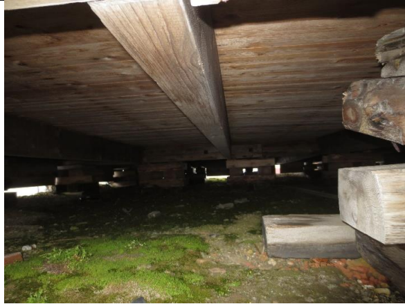
Det er lufting under bygningen, med synlig bjelkelag og bordkledning.
