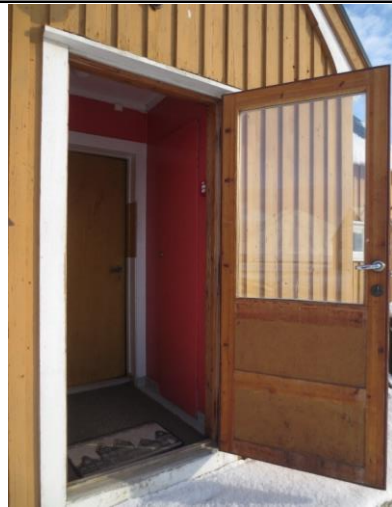
Åpen dør i bislaget, nyere ramtredør, noe fritt inspirert av originalen fra 1950-åra.
