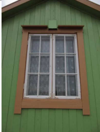
Antatt opprinnelig vindu mot nord, med tidstypiske detaljer og gerikter. Inndelingen i seks smale ruter i hver ramme er atypisk for bevarte vinduer i Ny-Ålesund.
