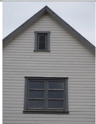
2023: Vinduer i gavl mot øst, bevart vindu fra 1919 øverst. Det store vindusfeltet ble betydelig endret i 1959 og senere i 1988.
