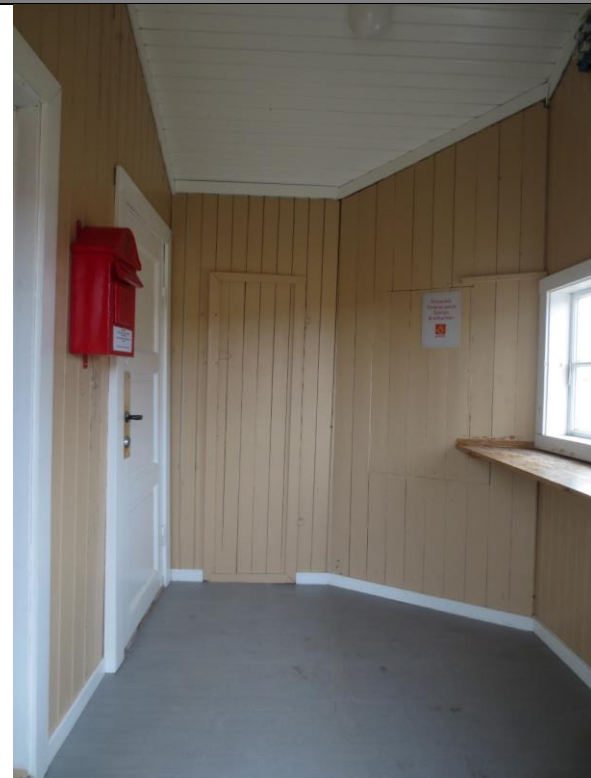
Interiør i bislag, sett mot sør og innvendig skillevegg mot bod. Antatt dør til do i kortvegg og kullbinge i skrånvegg, der ei luke er blendet.
