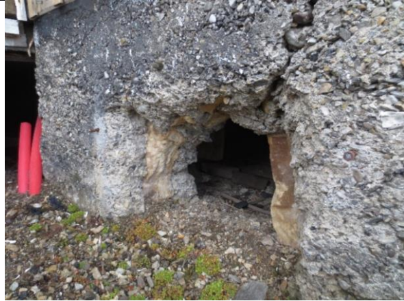
2023: Grunnmur støpt av lokalt framstilt betong fra 1919, med store steiner inne i muren (sparebetong).
