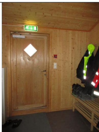
Interiør i nyere bislag mot nord. Vegger og himling har glattpanel.
