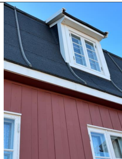
Takoppløft mot nord og papptak med avrundete lekter basert på opprinnelig løsning.
