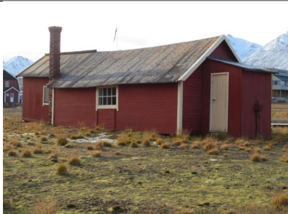
Fra nordvest, bislaget i vest er tilbygget i 2. driftsperiode, som inngang til boligdelen.
