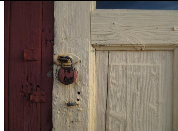
Detalj av fyllingsdør med nyere lås. Profilert ramtre og speil. Spor etter eldre beslag på vegg t.v.
