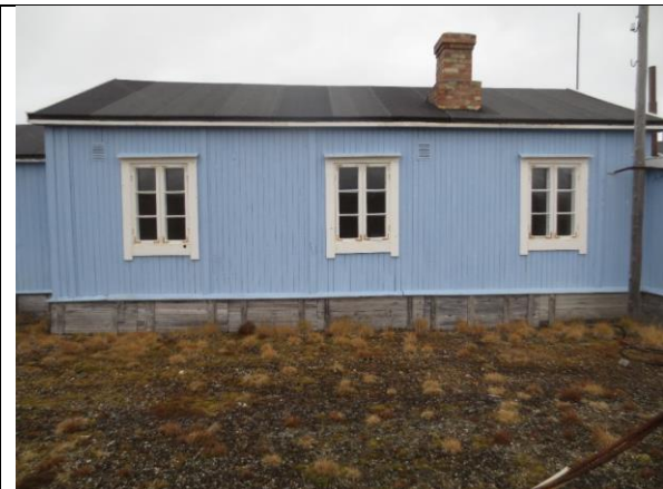
Fasade sør boligdel, opprinnelig oppført på tomte ved sjøen i 1929. Kledning og vinduer er som opprinnelig, muligens noe fornying av gerikter mv. ved flytting i 1946.
