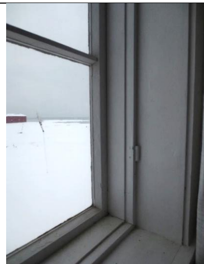
Detalj av opprinnelig 1950-tallsvindu mot nord. Varevindu er tatt ut, men nyere hengsler står i karmen.
