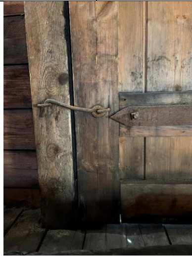
Detalj av eldre port i gavl mot vest, med opprinnelig beslag.
