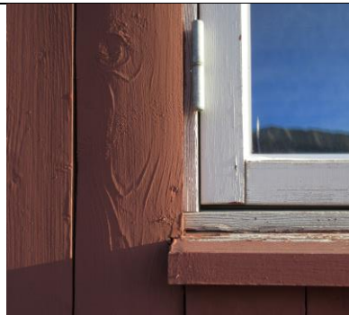
Detalj av ny vinduskopi og vekselpanel.
