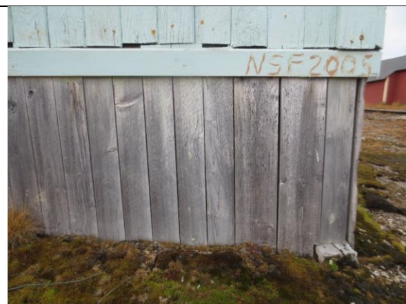
Detalj av kledning fasade øst. Skjørt av nyere rettkantete bord, ny dekklist påskrevet NSF 2005. antatt speidere som har utført siste oppmaling.
