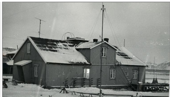
Observasjonsplattform fra 1966 over ark mot nord, med bøyte for «All-Sky kamera». Over tilbygg/bislag mot øst ses spor etter opprinnelig bislag, se foto fra 1973 neste side. Ei rørkasse går inn på hjørnet av nordveggen. Vi ser fortsatt spor etter disse endringene i dagens kledning. Bildet t.h. fra sørvest. De to pipene vest for arken er revet over tak. Begge foto: Jens Angard / Asgeir Brekke 1967, Kings Bays arkiv
