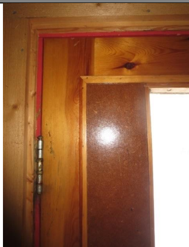
Ytterdør, huntonittplate mot glassfelt. Usikker datering, muligens modifisert etter 1945.
