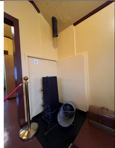
Ovns plass i stue, med brannmur og demontert røykrør.
