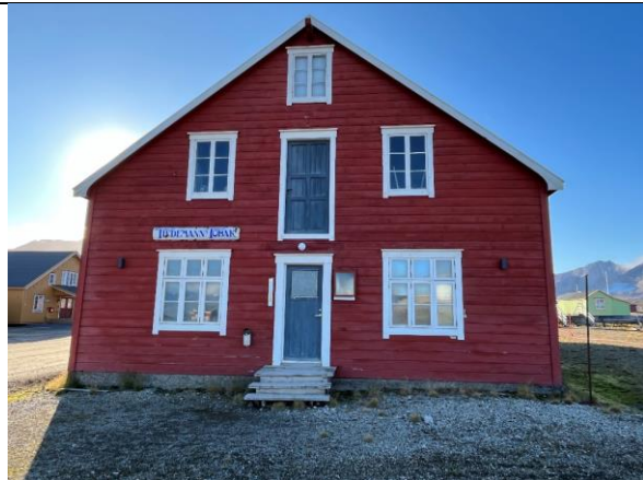
Fasade nord er lite endret, men i 1. etasje er vinduene fornyet. Butikkdøra er fornyet.
