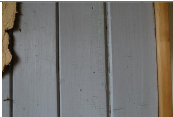
2023: Opprinnelig faspanel er avdekket i store deler av 1. etasje.
