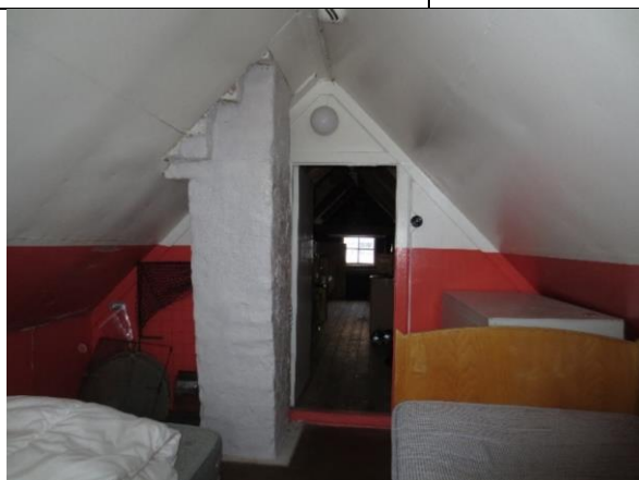
Fra soverommet sett mot midtgangen. Pipestokken står fritt i rommet og er ganske røft murt opp, pusset og malt.
