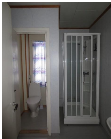
Bad kvinner. Et opprinnelig tofags vindu fra 1945 er bevart, men delt av en nyere lettvegg og blendet bak dusjkabinettet.
