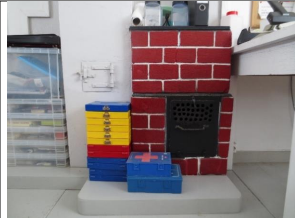
Opprinnelig ovn med støpt mur, som er påmalt imitasjon av rød teglstein og hvite fuger, bevart som på bilder fra 1950-tallet.
