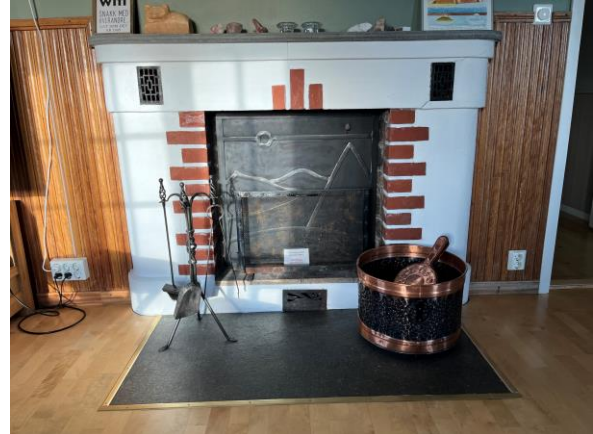
Peisen ble fornyet i 1950-åra, kombinasjon puss og dekorativ tegl med støpejernsriste og port.
