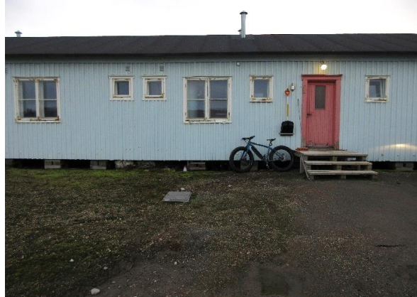
Bygningens eneste inngangsdør mot nord i opprinnelig brakke, antatt satt inn her ved riving av bislag på 1960-tallet. To parstilte nyere små vinduer i baderom, etablert ved moderniseringen i 1957–58.
