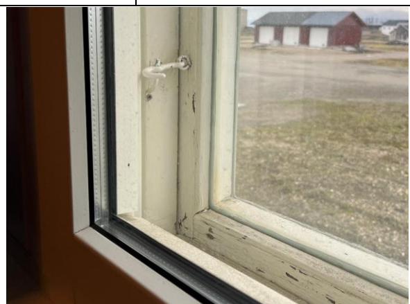
Opprinnelig koblet ytre vindu fra 1945/1949. Innvendig varevindu med isolerglass fra 2008.
