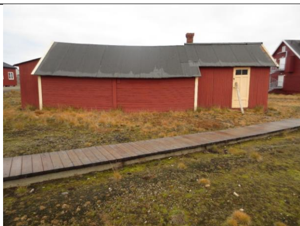
Fasade sør, lemrakka med inngang til malerboden til høyre. Mønekammen på østre hus er opprinnelig. Vestre hus har liggende bord og vertikalt dekkbord over panelskjøt midt på langveggen.
