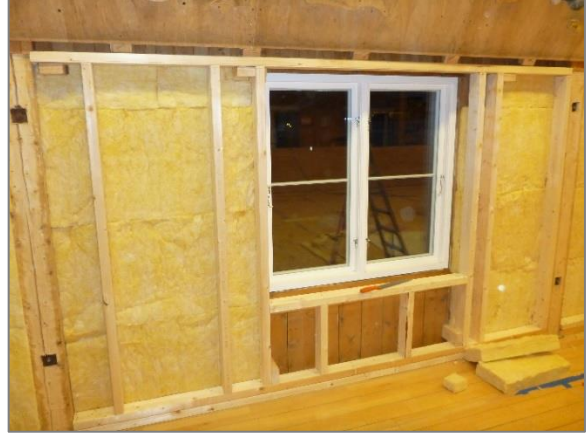
Under arbeid i 2012. Østveggen i salen ble strippet for to lag innvendig kledning før ny isolasjon ble lagt. På bildet t.v. er oljet vekselpanel fra 1962 fjernet og huntonittplater malt i grønt og gult fra etterkrigstida kommer fram. Det ble slått nye plater på veggen. Foto: Kings Bay AS
