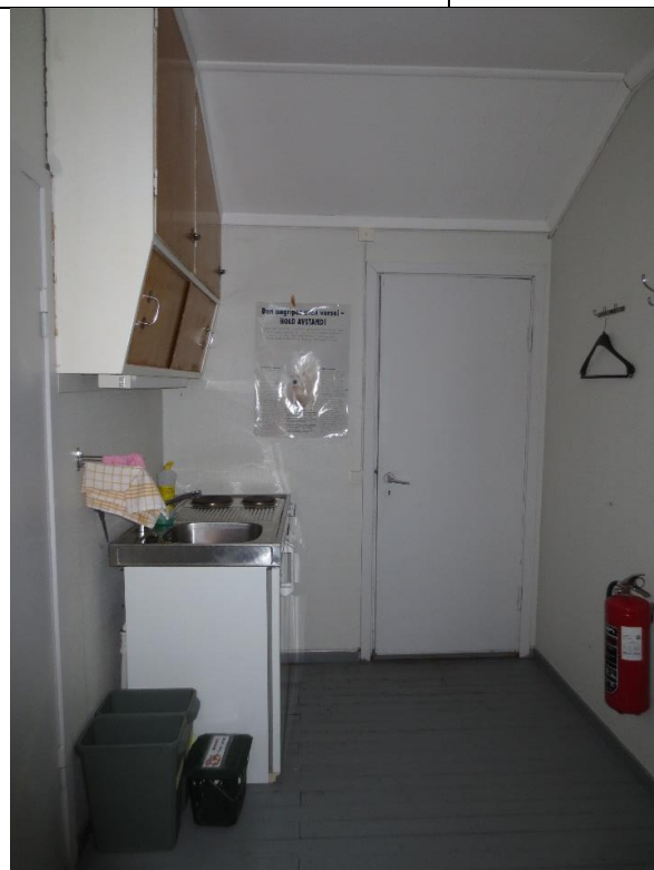
Midtrommet/kjøkkenet er del av det opprinnelige bygningsvolumet fra 1918, mens skilleveggen (bak skapet) ble tilføyd ved ombygging til familiebolig etter 1945. Kjøkkenets vegger og himling er kledd med malte plater. Dør mot tilbygget i øst.
