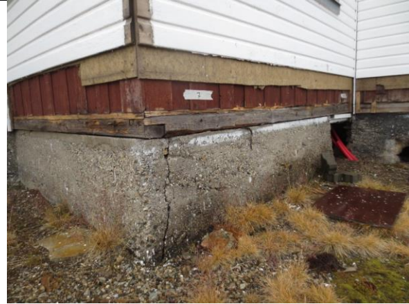
2023: Støpt grunnmur og to lag kledning fra henholdsvis 1919 og 1959.
