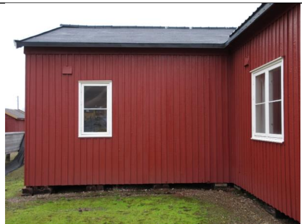
Etter takutbedring i 2017 fikk tverrfløyen tilbakeført takpapp på den ene siden.
