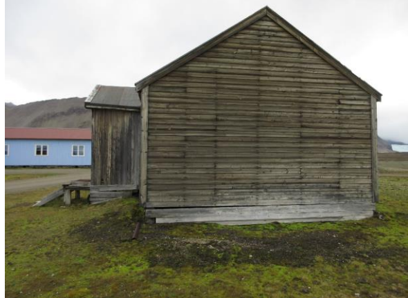
Fasade nord, med liggende dobbelfalset kledning. Bak denne kledningen er en blendet vindusåpning.
