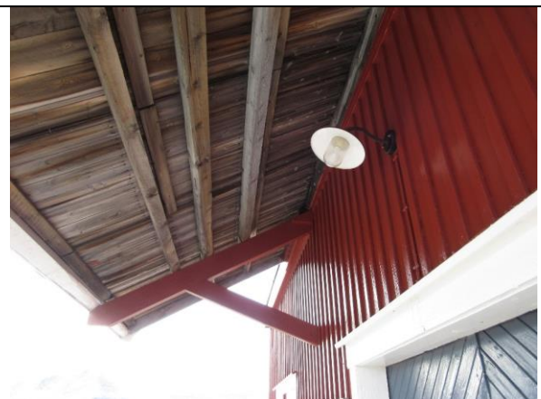
Undersiden av skjermtaket over hovedport/platting mot sørøst. Bærekonstruksjonen med knaster, bjelker og bordtak ble fornyet i 1992.
