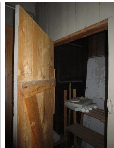
Labankdør inn mot boden i bislaget.
