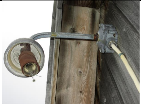
Eldre lampetype fra 2. driftsperiode over hovedinngangen, kolbe mangler.
