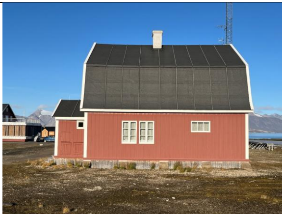
Fasade sør. Bislaget fra 1918 er bevart. Ved tilbakeføring i 2011 ble et senere oppført takoppløft (ark med pulttak) fjernet fra loftet.
