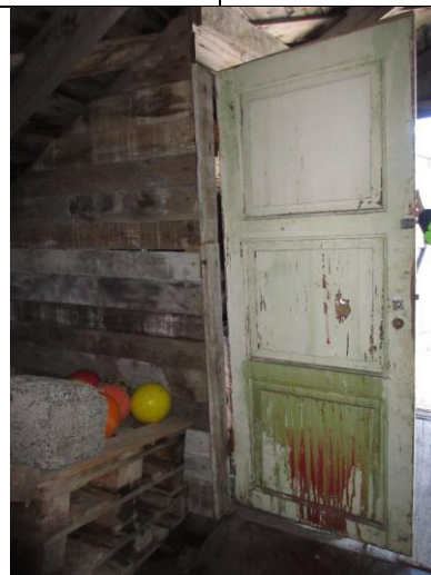
Gammel fyllingsdør fra ca. 1917–19, som er gjenbrukt i kullpramnaustet, motsatt side er kledd med plate (se foto forrige side).
