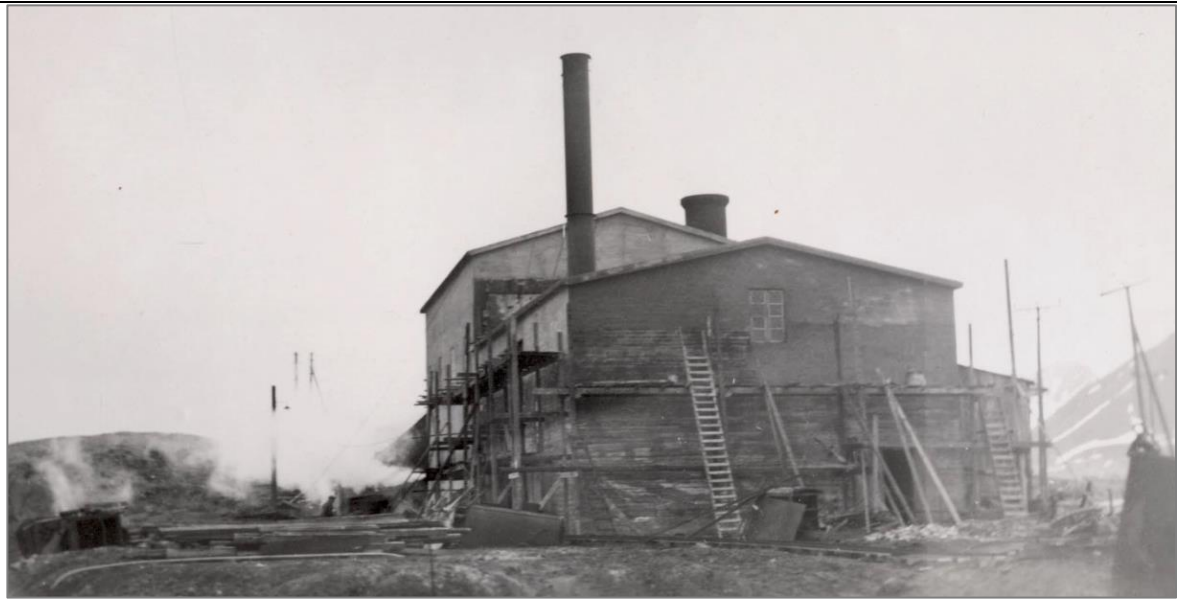
Udatert bilde av det nye anlegget fra 1949, sett fra vest. Det pågår pussarbeider på fasadene på vestfløyen. Den høye pipa i forgrunnen er senere revet. Foto: Ukjent. Svalbard museum, SMF 00665 (beskåret)
