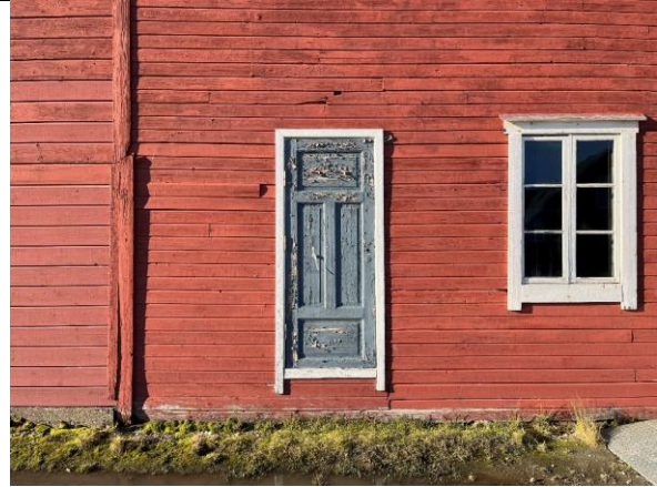
Opprinnelig fyllingsdør, muligens fra 1917, i midtre del mot øst, nå avstengt.
