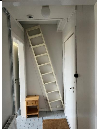
Interiør i mellomgang, loftstrappa er hengslet mot veggen.
