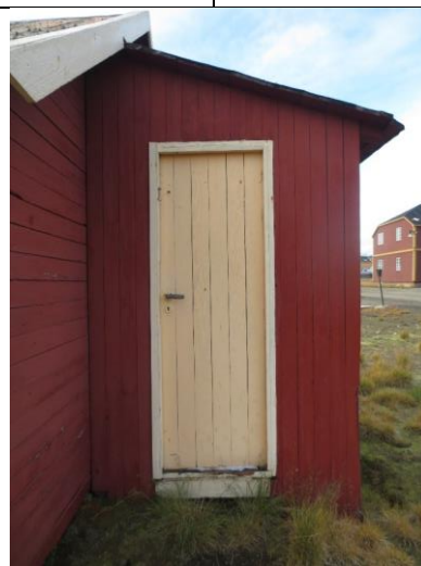
Sekundært bygget bislag mot vest, typisk etterkrigstid, enkel labankdør.
