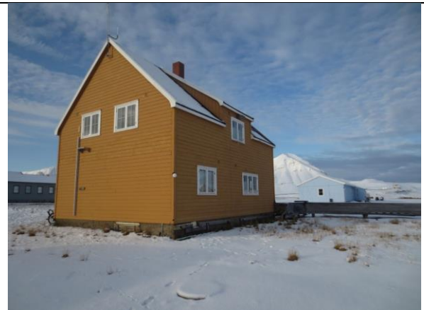
Huset fra nordøst. Det var opprinnelig to vinduer i 1. etasje i østveggen, inn mot opprinnelig spisesal. Disse ble fjernet før dagens kledning ble slått på, da spisesalen var endret til to boligrom.
