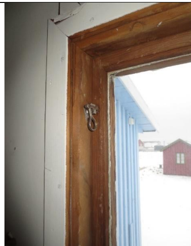
Detalj av vindu i bøttekott, med opprinnelig haspe.
