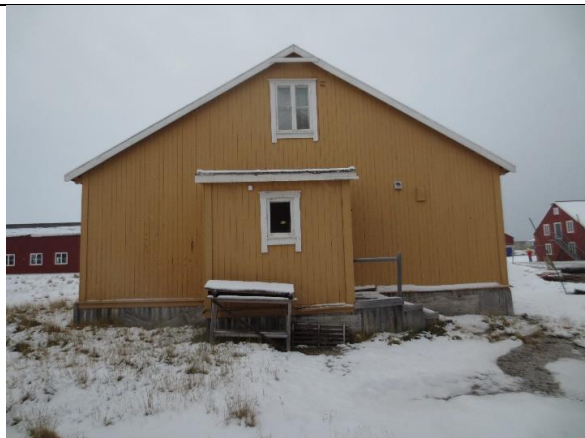
Fasade øst. Det lille tilbygget/bislaget ble ombygget i 2. driftsperiode.
