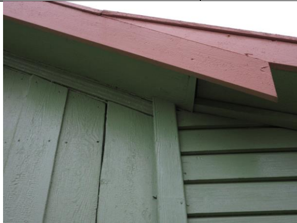
Detalj fasade nord. Opprinnelig vekselpanel med profilert list under saltaket. Til høyre nyere liggende dobbelfalset kledning på tilbygg.
