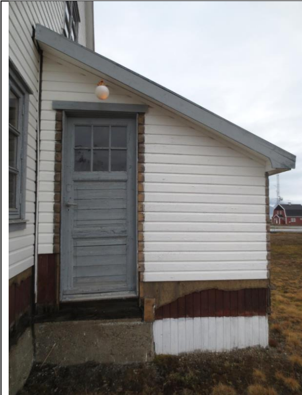
2023: Opprinnelig dør er bevart i bislaget mot øst. Skillet i grunnmuren viser tydelig opprinnelig størrelse, som på Flors tegning 1919, og senere tilbygg mot øst med fornyet tak. Opprinnelig tilbygg har underliggende vekselpanel lik hovedhuset, mens tilbygget har smalere faspanel.
