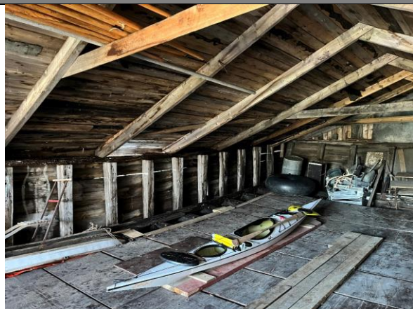
Interiør mot nordøst. Sperretak med enkelte hanebjelker.
