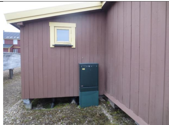
Tilbygg øst, med isolerglassvindu fra 1994 til baderommet. Nyere el-boks inn mot fasaden.
