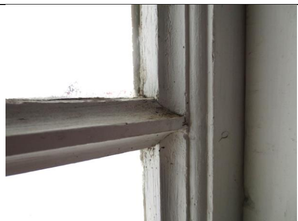
Sprossene har hulkil på hver side, også dette er en tidstypisk utførelse i Ny-Ålesund.
