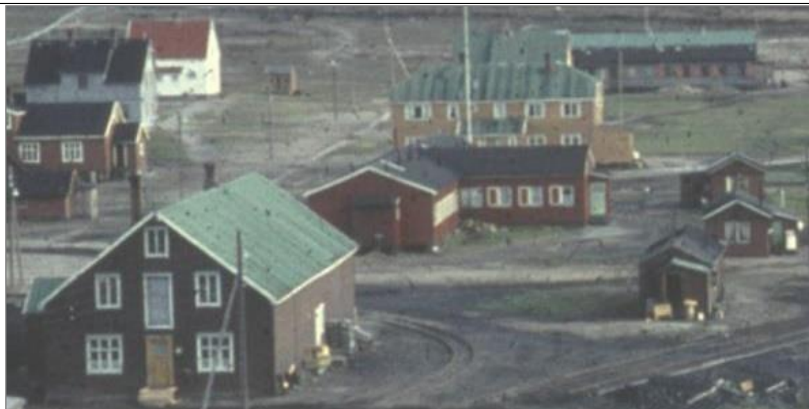
Samfunnshuset midt i bildet 1956–59, før påbygging av salen. Tverrfløyen hadde opprinnelig vinduer mot nord og et bislag med kjøkkeninngang i vest. Kilde: Hans H. Hagens fotosamling, Kings Bays arkiv (utsnitt)
