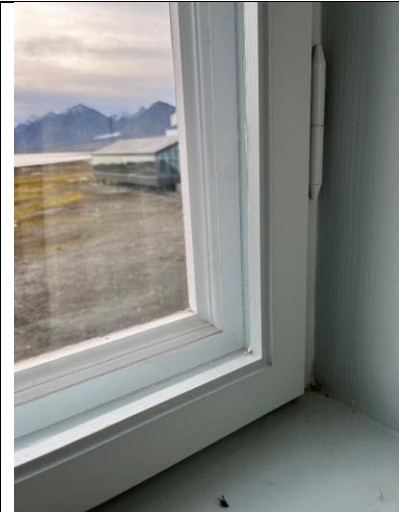
Vinduskopier som i 1. etasje, med profiler anno 1918 i ytre ramme, varevindu med energiglass.
