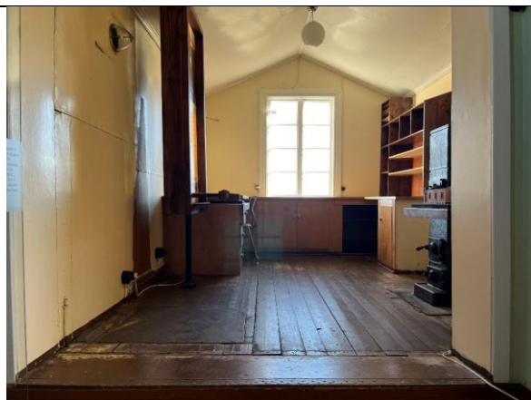
Den gamle telegrafan fra 1918. Innredningen er dels fra 1958, opprinnelig bordgulv er avdekket, malte huntonittplater på vegg/himling. Rommet er bevart med minimale inngrep, vegger og himling ble malt.
