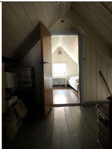
Midtrommet på loftet har malt bordgulv. Opprinnelige finérdør er bevart med lakkert overflate.
