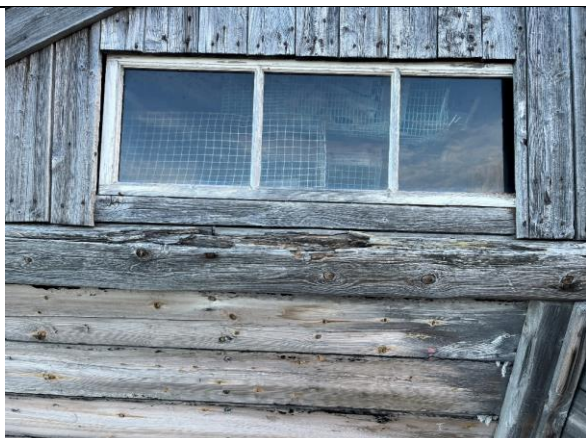
Nordre vindu i kullpramnaustets hovedfasade, med staffprofil og rester av hvit maling. Gjenbruksvindu montert med innsiden ut.
