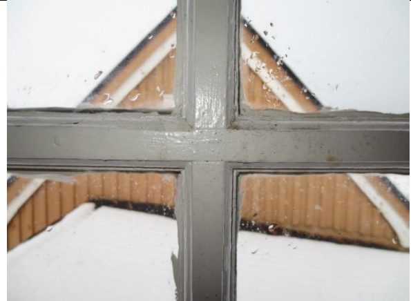
Opprinnelige, profilerte sprosser i vindu mot vest, med gjennomgående horistontal sprosse.
