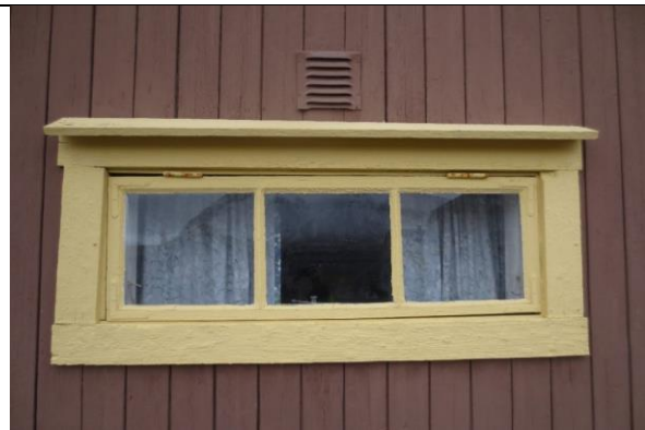
Opprinnelig vindu fra ca. 1946 i soverom mot sør, i tilbygget del fra 2. driftsperiode. Ventil over vindu er innvendig blendet, opprinnelig type gerikter.
