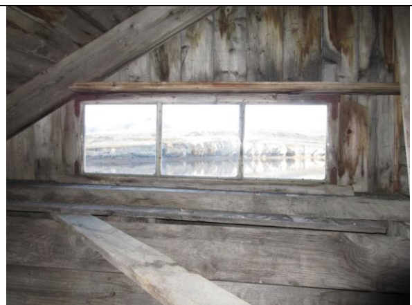
Vindu sør for porten i kullpramnaustet, med hjørnejern, som er rustne. Gjenbruk av vindusramme, som er montert liggende og snudd med utsiden inn.
