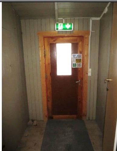
Forgangen i bislaget, mot inngangsdør i nord.
