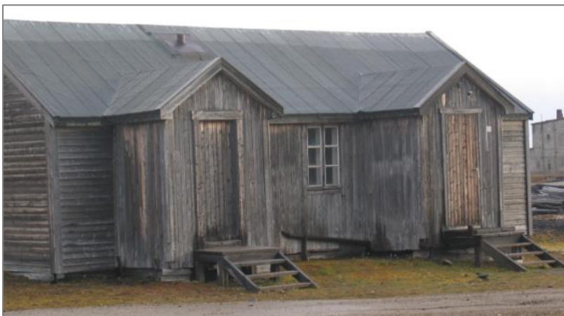
Foto: L Roll 1992. «Ny» ytterdør med ny kledning, ny takpapp, ny trapp bislag sør, nye trinn og vanger på trapp nord, ny kledning på vegg og nye vindskier på bislag nord.
