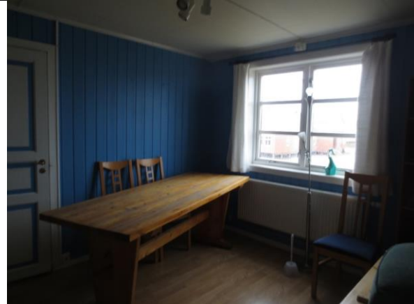
2023: Typisk interiør i kjøkken 2. etasje. Nyere skyggepanel og dører, vinduer med nytt format i opprinnelig åpning.
