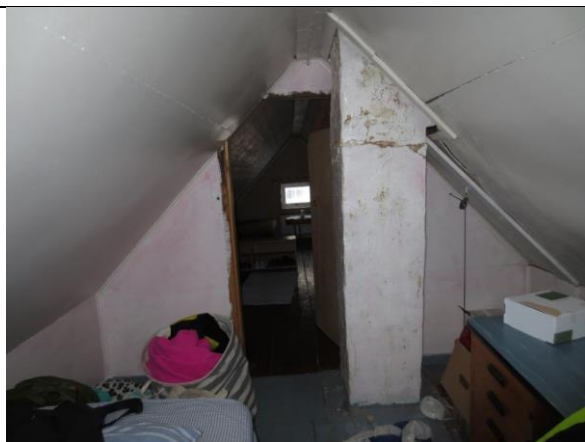
Vestre loftsrom har preg av 1950-tall. Pipestokken er murt noe skjev, pusset og malt.
