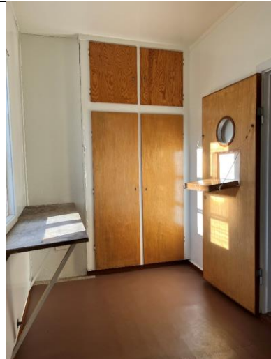
Skap og innerdør fra 1958, lakkert finér. Rommet kalles «skranke» på tegning 1957. I 1946 var dette barneværelse.
