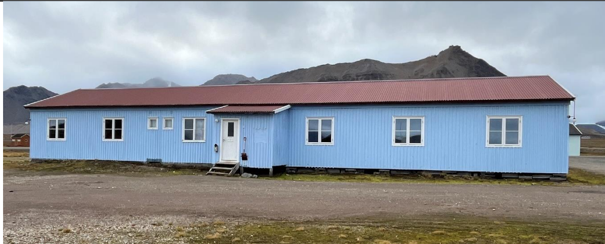
Fasade mot nord med bislag og små vinduer til boder og bad/WC fra 1958.
