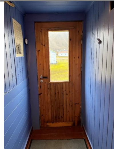
Gang med umalt panel på innside ytterdør, bakelitthåndtak. Veggene har pløyd faspanel.
