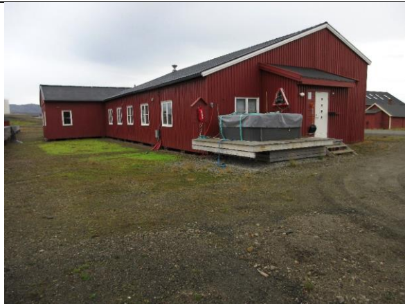
Fra sørvest, med opprinnelig tverrfløy fra 1945. Forsamlingsalen ble tilbygget i 1962, med tilsvarende vindusformater som i 1945 i den nye vestfasaden. Nyere terrasse med badestamp.
