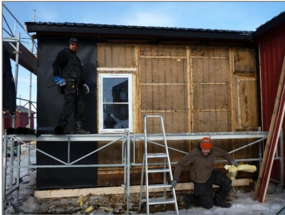
Isolasjon med trefiberplater på kjøkkenfløyen. Antatt opprinnelig løsning fra 1945, med prefabrikkerte elementer inndelt med losholter og fylt med trefiberplater.
