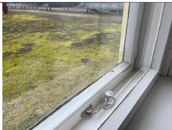
Innsiden av stuevinduet mot nord med nyere varevindu og moderne stormhaspe på ytre ramme. Muligens er stormhaspen montert i senere tid på et eldre vindu fra 2. driftsperiode.
