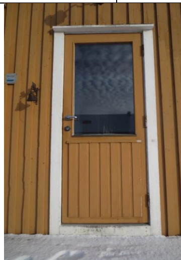
Nyere inngangsdør, glassfelt og kledning er inspirert av original dør fra 2. driftsperiode.
