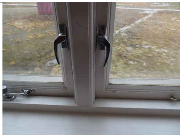
Detalj av vindu, rammer, sidekarm og midtpost har staffprofil.
