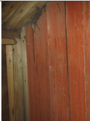
Rødmalt vekselpanel fra 1918 på hovedhusets opprinnelige fasade sør, nå inn mot vestre tilbygg.
