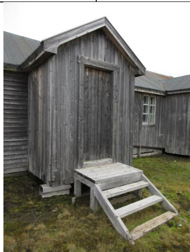
Søndre bislag, med opprinnelig dør (avstengt, blendet innside). Ny trapp fra 1992, trappa mangler historisk belegg på dette stedet.
