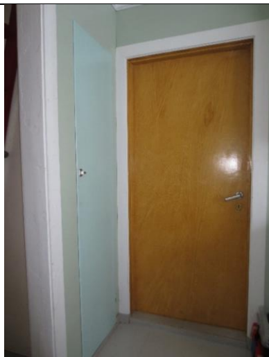
Bevart 1950-tallsdør med ådret overflate.
