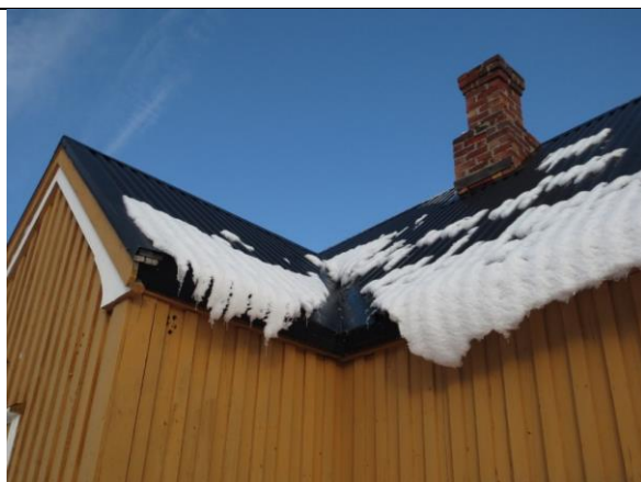
Overgang mellom bislag og hovedtak.
