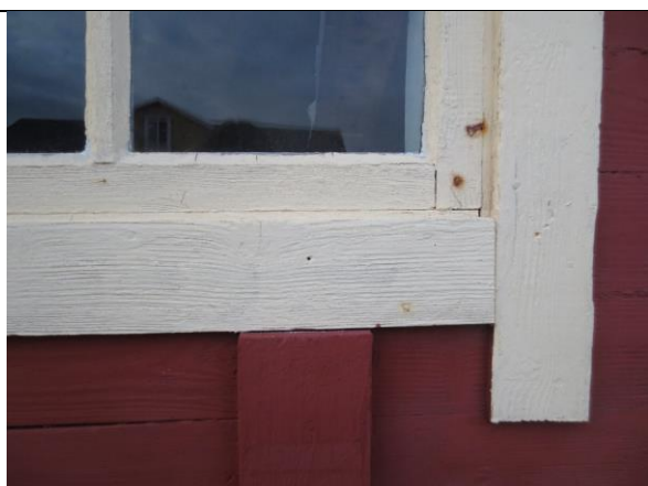
Detalj av vindu mot nord i boligdelen. Rammen er spikret fast i karmen. Enkel utførelse på vindu og listverk, glass i kittfals. Vertikalt dekkbord i kledningen viser opprinnelig vindusbredde.
