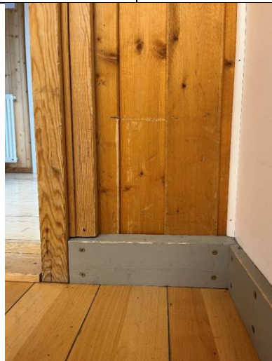
Detalj av vegg ved dør i gymsalen, der det er bevart vekselpanel på vegg.
