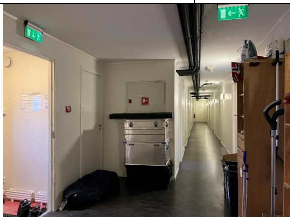
Opprinnelige korridorvegger er skjult bak nyere kledninger.
