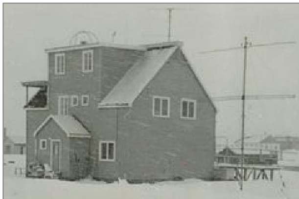
Etter ombygging til forskningsstasjon, med observasjonsplattform på tak og forhøyet takoppløft mot sør. Piper over tak er revet. To opprinnelige vinduer i 1. etasje mot øst ble trolig fjernet allerede i 1957. De fleste vinduene er sprosseløse, antatt som i 1957, se også foto ca. 1960 i katalog nr. 21 Hvitt hus. Foto: Svalbard museum (utsnitt)
