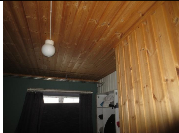
Typisk interiør i leilighet, med malt/umalt skyggepanel på vegger og himling fra senere modernisering.
