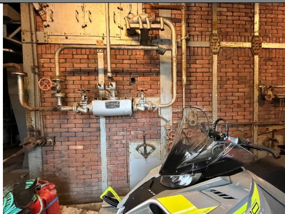
Nedre del av ovnen fra 1957.
