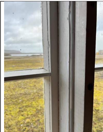
Vinduet mot vest i kjøkkenet har opprinnelig profilert midtpost (dels skjult), men nyere rammer.
