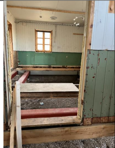
2024: I 1. etasje ble gulvet fjernet i forbindelse med refundamenteringen.
