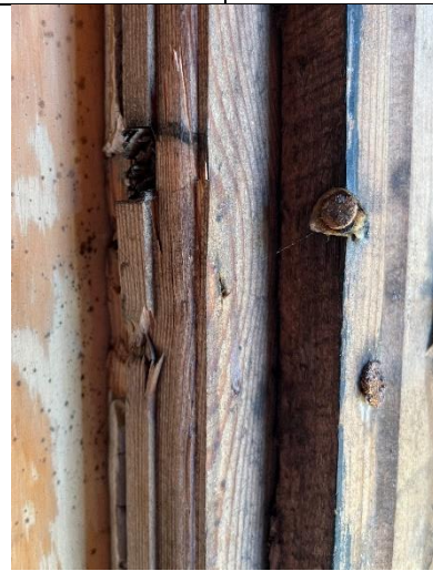
Vinduet mot nord med staffprofil på ramme og tapphull etter opprinnelig srosse.
