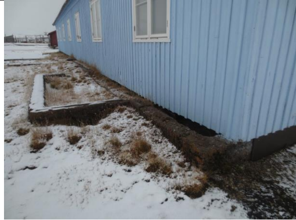
Møt sør ses rester av grunnmuren fra sykehuset anno 1919, her med utbygg/bislag. Svenskebrakka er litt smalere, slik at søndre grunnmur ligger like utenfor fasaden.
