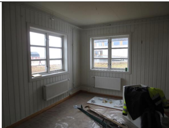
2023: Stua mot nordøst, med to nyere vinduer i opprinnelige åpninger. Nyere skyggepanel.
