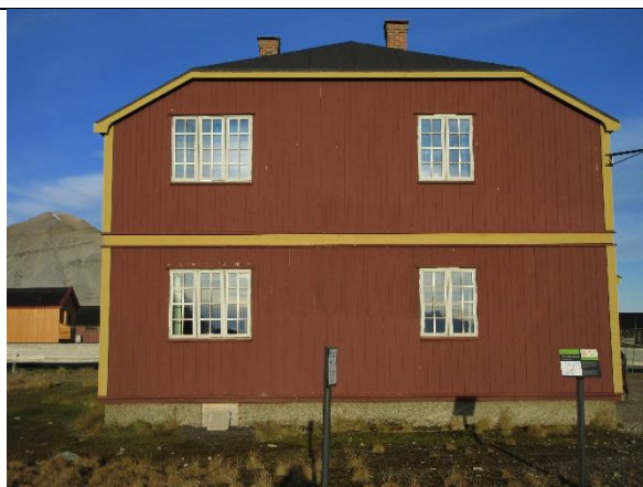
Fasade øst, tilbakeført til opprinnelig uttrykk. I 1. etasje ligger peisestua, eller salongen, som den ble kalt ved etablering av hoteldriften på 1930-tallet.
