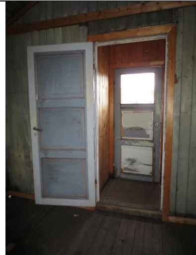
Hovedrom mot bislag. Fyllingsdørene er typisk for rett etter krigen, men begge dørene er trolig satt i eksisterende posisjon etter 1988 (gjenbruk).
