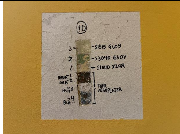
Fargehistorikk på brannmur i stue. Hele interiøret ble undersøkt og tilbakeført i 2019. Tolkning av fargehistorikken og definering av fargekoder må tas med noe forbehold.
