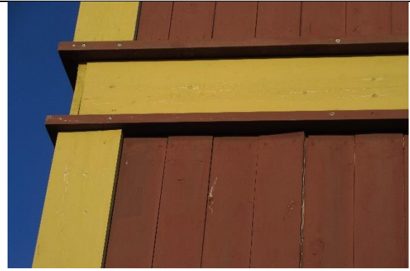
Gesimsbånd med liggende bord foran etasjeskillet er i gjenskap etter forbilde av løsningen i 1919.
