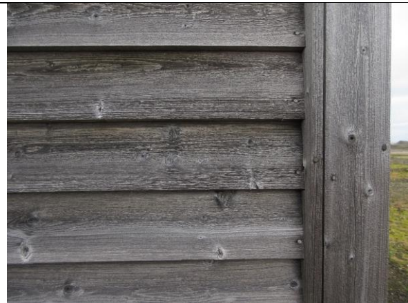
Enkelfaset liggende kledning (sulagt) på de fleste fasadene.
