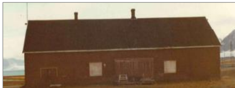
Fasade vest 1973, flere endringer og nyere åpninger sammenlignet med eldre foto. To blendete vindusåpninger tilsvarer dagens vindusplassering. (T.v. mann med gul vinkel/målestokk.) Kilde: Reinertsen m.fl. rapport 1973.
