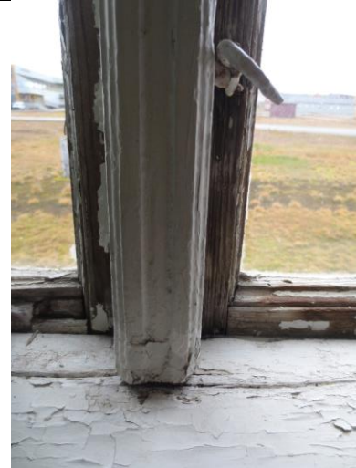
Detalj av profilert midtpost og ramme med profil og opprinnelig haspe, typisk utførelse ca. 1920.
