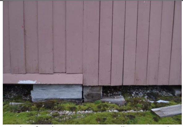
Detalj av fasade vest, overgang mellom opprinnelig brakke og tilbygg sør. Tilbygget har glattpanel og er uten vannbrett.
