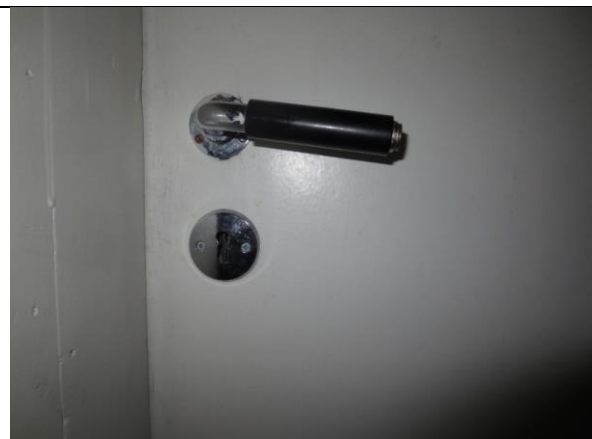
Dørhåndtak av stål og bakelitt til soverom på loftet. Typisk 1950-talls finérdør som er malt.
