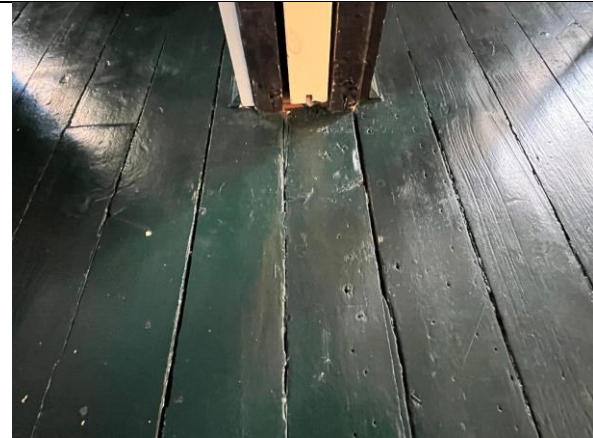
Opprinnelig bordgulv ved skillevegg. Skyvedørene ble laget nye, én av spaltene i vegg eksisterte.
