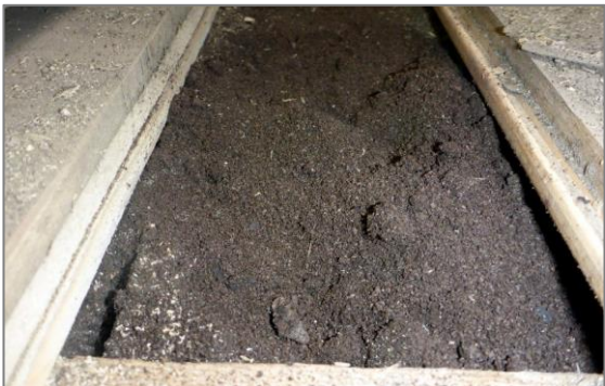
Istandssetting 2014. Utbedring/utskifting av utvendig kledning mot øst, opprinnelig konstruksjon avdekkes. Fornyng av bjelkelag i søndre del, stubbloftet var fylt med en slags grus. Foto: Kings Bays arkiv
