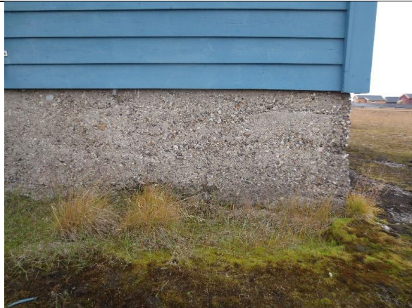
Grunnmuren er støpt av sparebetong, med store steiner skjult inne i den grove sementblandingen (som Gult og Hvitt hus).
