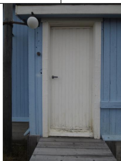
Inngangsdør bislag sør, til telegrafren. Ramtredør med utvendig smal panel, fornyet ca. 1958–60. Nyere lampe.
