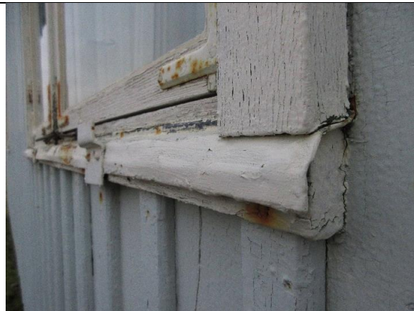
De opprinnelige vinduene fra 1945 har sinkbeslag over vannbrett, innfelt under belistningen på sidene.
