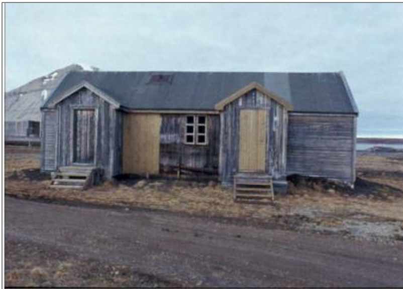
Foto: L Roll 1992. «Ny» ytterdør med ny kledning, ny takpapp, ny trapp bislag sør, nye trinn og vanger på trapp nord, ny kledning på vegg og nye vindskier på bislag nord.
