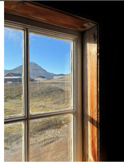
Ett opprinnelig loftsvindu med fire ruter anno 1919 mot vest. Rammen er profilert med hulkil og staff, srossen med hulkil på hver side.
