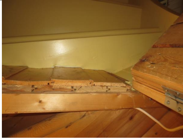
Veggstumpen over døra til boden under trappa viser to lag panel: vekselpanel med avrundete kanter er slått utenpå en pløyd glattpanel, jf. panelet på bildet t.h.
