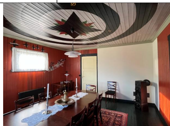
Spisestua sett mot kjøkkendøra. Brannmuren ble rekonstruert ved siste restaurering, da skilleveggene fikk tilbake sin opprinnelige plassering, basert på spor i himling. Fin kompassrose malt på himlingen.
