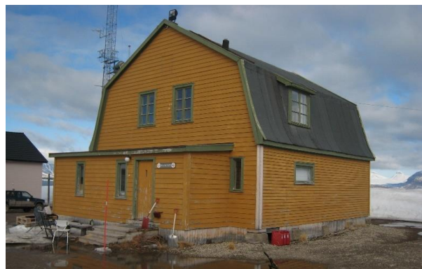
Tv.: planløsning 1997. T.h. Amundsenvillaen i 2008, like før restaurering. Utvendig kledning og vinduer var fornyet. Vekselpanelet fra 1918 lå skjult under, likeså bislag mot vest med opprinnelig vindu og lemmer.
