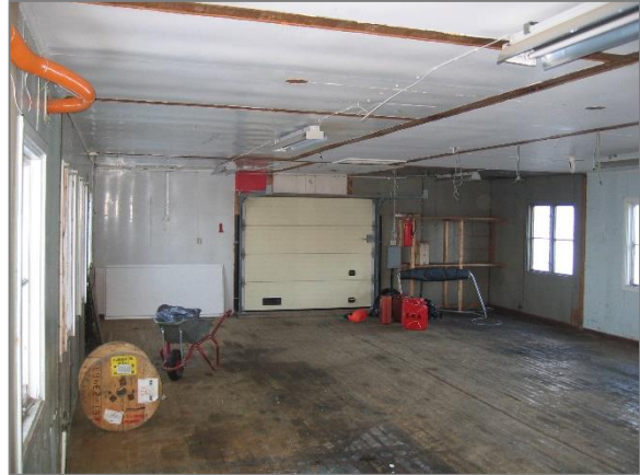
Bygningen i 2004, dobbel port mot øst til skutergarasjen, og nyere døråpning mot nord. Interiør i østre del, opprinnelig bordgulv og spor i platekledd himling etter korridor- og skillevegger. Foto: Kings Bay AS 2004
