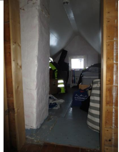
Vestre loftsrom er kledd med malte huntonittplater, typisk 1950-talls.
