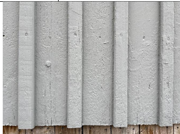
I nedre del av kledningen er det bolter som forbinder veggkonstruksjonen med bjelkelaget.
