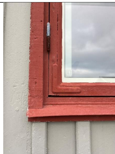
Det tilbakeførte vinduet mot nord har formpressete hjørnejern og må være gjenbruk av et eldre vindu.
