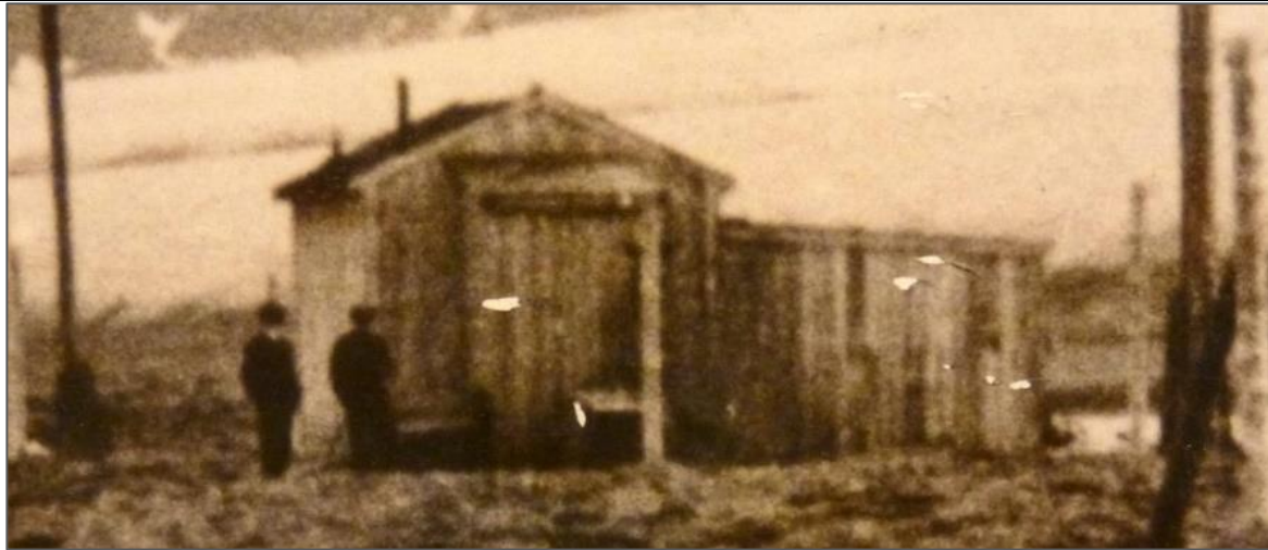
Utsnitt av foto av opprinnelig stasjon før oppføring av det store tilbygget mot vest i 1929. I kortveggen er det noen vanskelig tolkbare elementer: vannbrett, stender, benk? Kilde: foto gjengitt i Treider 2012, usikker kilde.
