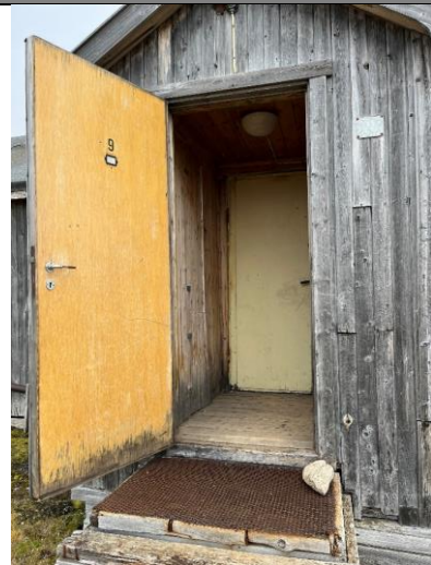
Bislag nord, med en nyere finérdør (med nr. 9), satt inn her i 1992.
