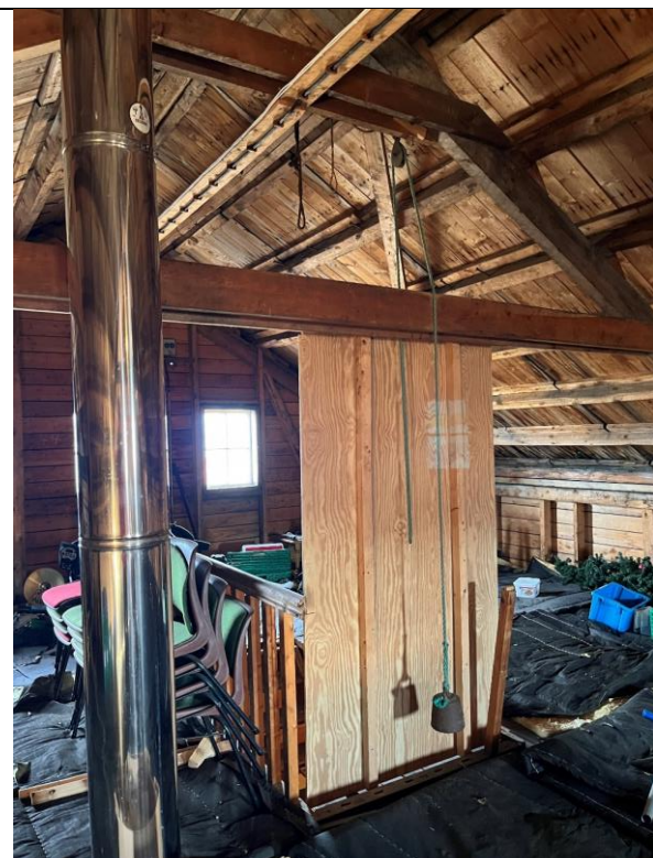
Sperrebind med hanebjelker av to planker. Lemmen over loftstrappa er nyere. T.v. nyere stålrørspipe fra ovn i 1. etasje.
