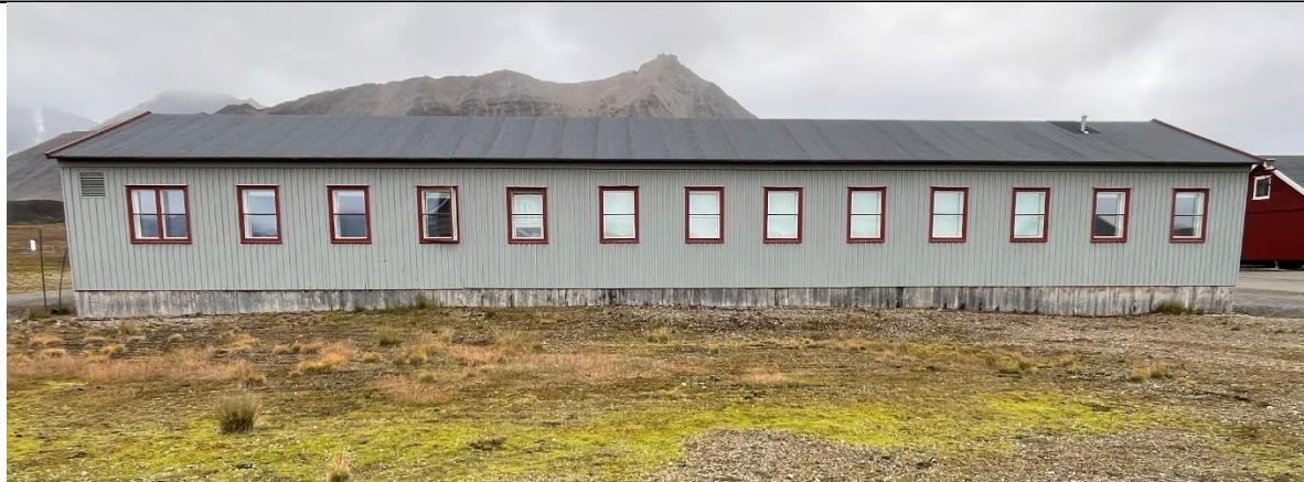
Fasade nord. Vindusplasseringen er som i 1945, med opprinnelige vinduer bevart. Tilbygget fra ca. 1946 sto foran vindu nr. 4 fra venstre, med stor åpning i vegg. Dette ble fjernet ca. 1984.
