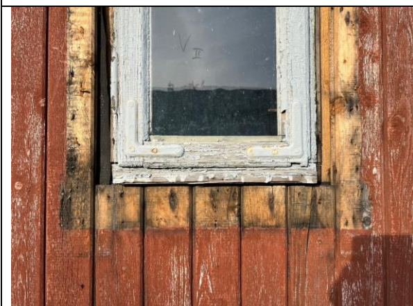
2024: Detalj av opprinnelig vindu i tilbygget bislag øst. Hengsler, beslag og geriktdetaljer er som på hovedhuset anno 1919.
