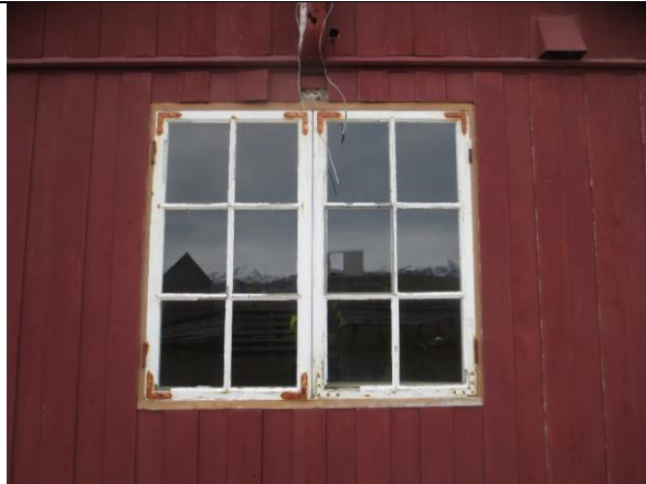
Opprinnelig vindusløsning mot nord. Antatt gamle rammer med nyere beslag fra restaureringen i 1987. Dimensjon og sprosseinndeling er som i 1918.
