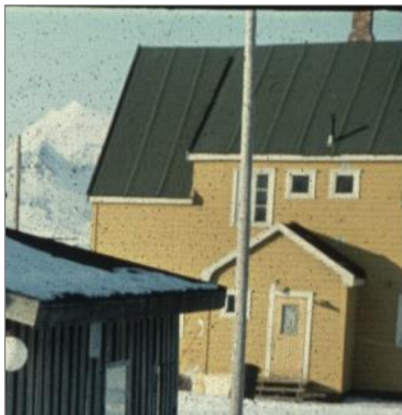
Like etter moderniseringen i 1957, liggende kledning. Muligens ett opprinnelig vindu bevart i oppløft mot trapperom. Enda en pipe er revet. Kilde: Hans H. Hagens private samling (utsnitt).
