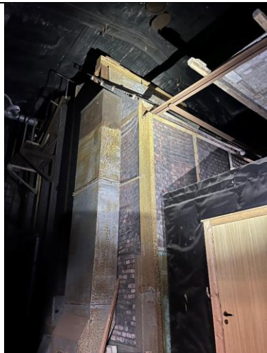
Teglmurt fyrkjele fra 1928. T.h. dør Nansenlaboratoriet fra 1990.
