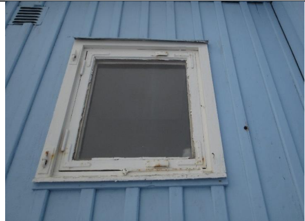
Opprinnelig vindu fra 1945 mot bøttekott, koblet utførelse. Gamle hengsler for vinduslemmer står i venstre karm.
