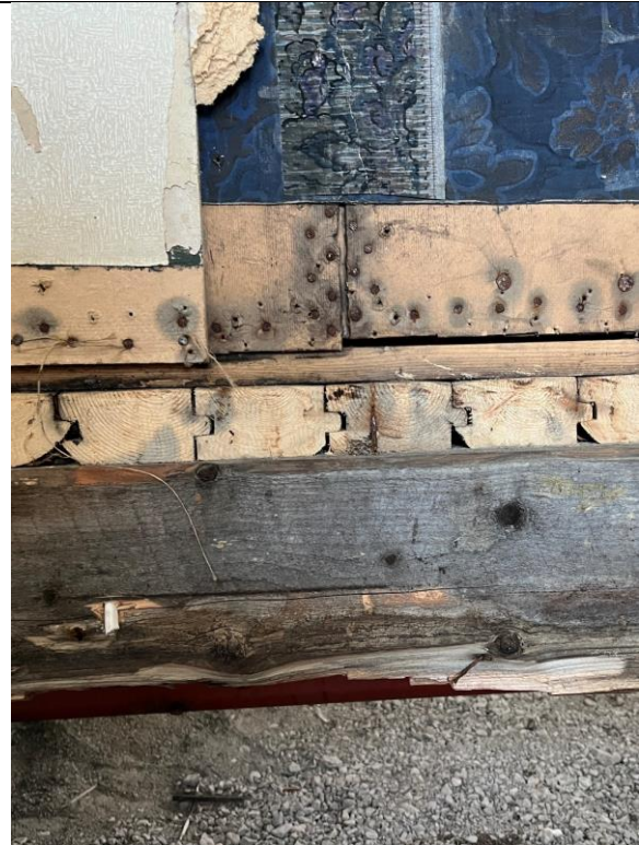
2024: Detalj av skillevegg mellom stuen i østre del av 1. etasje. Avsaget gulvplank og blå mønstret tapet.
