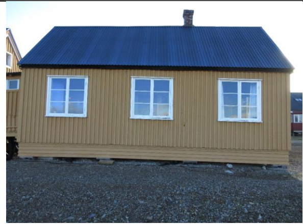
Fasade nord, med tre eldre vinduer.
