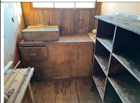
Bevart innredning i bod mot øst, antatt fra 1946, snekret på stedet av treverk og huntonittplater.
