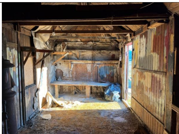
Interiør i malerboden, sett mot øst. Taket er bygget av prefabrikkerte lemmer, som er anlagt på svill/vegg og mønås, med frittgående bindbjelker tvers over rommet.
