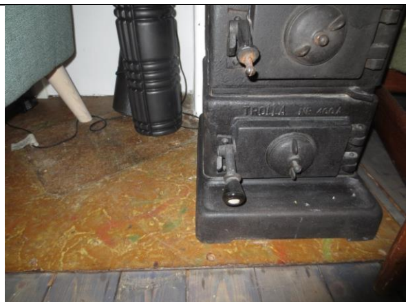
Under støpejernsovnene er det bevart en bit av huntonittplate med bemaling (imitasjon av linoleum). Bak til venstre ses avtrykk etter en blikkplate under ovnen, som er flyttet og tatt ut av bruk.
