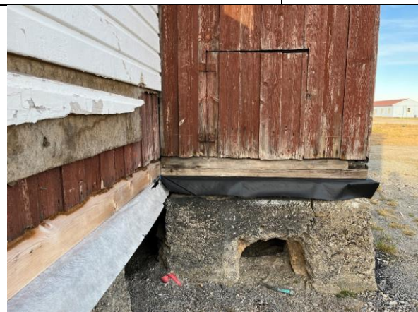
2014: Detalj bislag nord, opprinnelig østvegg med luke for dotømming. Stor avstand mellom svill og mur grunnet oppretting ved refundamentering.
