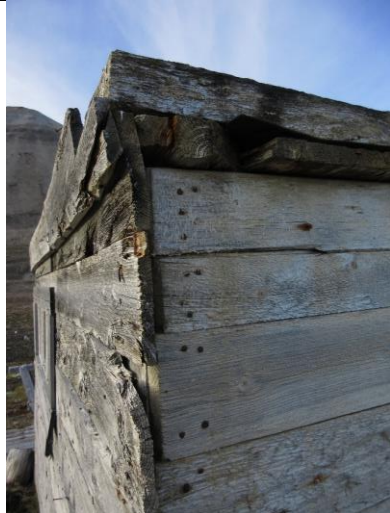
Varmestuas utvendige hjørne nordøst, liggende kledning.
