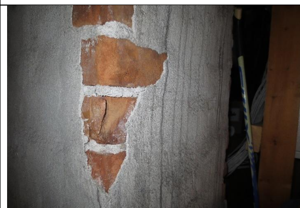
Detalj av kalkbasert puss og mørtel i pipestokk på loftet, antatt som opprinnelig murt med rød tegl i 1919.
