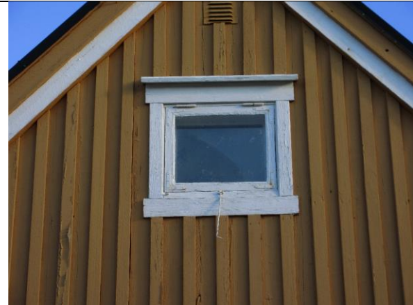
Eldre loftsvindu mot vest, topphengslet med hjørnejern.
