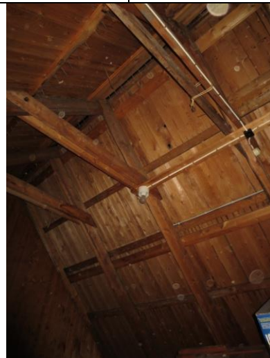
2023: Opprinnelig takkonstruksjon med kraftige sperrer og høyt plassert hanebjelke av to sidestilte bord. Takstrø og stående bordtak (lemmer).
