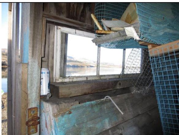
Vindu nord for porten i kullpramnaustet. Montert med utsiden/kittfalsen inn. Gjenbruksramme.
