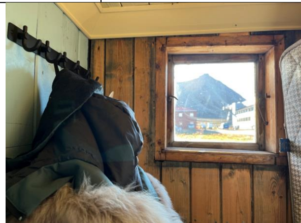
Opprinnelig vindu i bislag vest, i sørveggen. Antatt tidligere bøttedo. Blålig impregnering fra 1918 omkring vinduet, dels avvasket/bleket (?).
