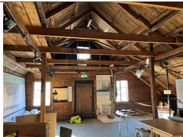
Interiør i polarutstillingen i loftets søndre del. Opprinnelig port og tre vinduer i gavlveggen. Opprinnelig takkonstruksjon er understøttet av langsgående dragere og stolper (= stol).
