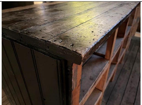
Detalj av disken vist t.v., med kraftige pløyde bord i toppdekket og pløyd faspanel på siden.
