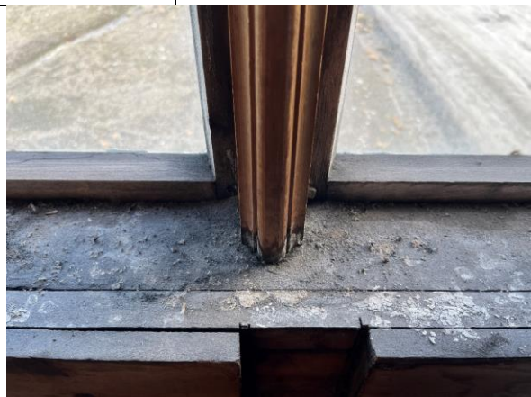
Detalj av opprinnelig vindu mot nord. Fint profilert midtpost og rammer uten profiler.
