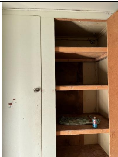
Innkikk i skap på sørveggen i bislag vest anno 1929. Malte plater på vegg og blendet tidligere ytterdør mot sør, se foto under.
