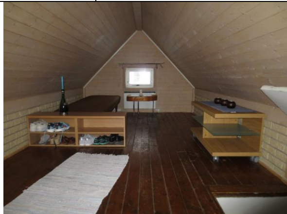
Midtsonen og østre del av loftet er et større oppholdsrom. Nyere kledning på vegger og tak. Nyere isolerglassvindu.
