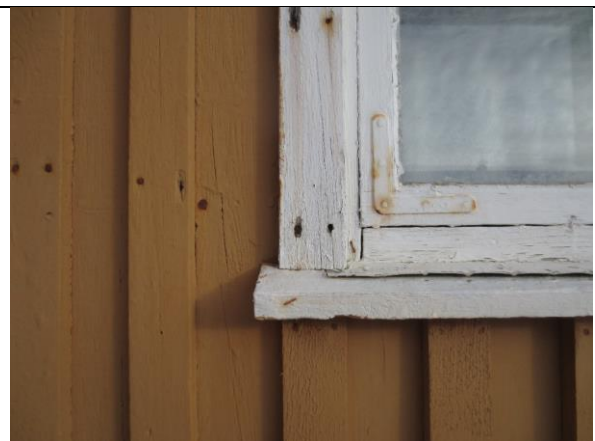
Detalj av vinduet vist t.v., hjørnejern med runde ender, typisk 1950-talls.
