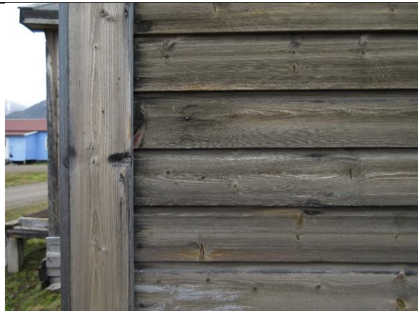
Dobbelfaset liggende kledning på nordveggen.
