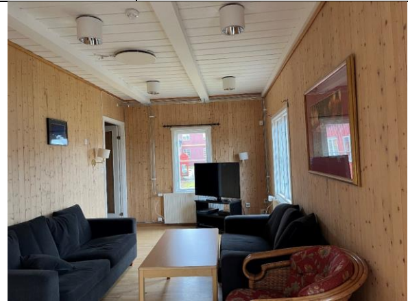
Oppholdsrom i tverrfløyen, sett mot sør. Veggene har nyere pløyd glattpanel.
