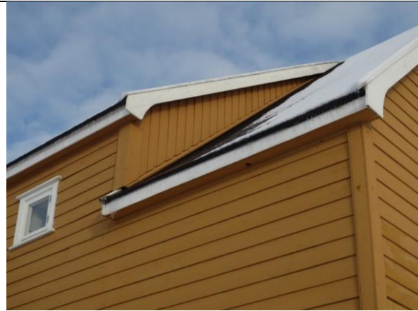
Detalj av takoppløft mot sør, som er tilbakeført etter å ha vært påbygget med observasjonsplattform for Norsk Polarinstitutt.
