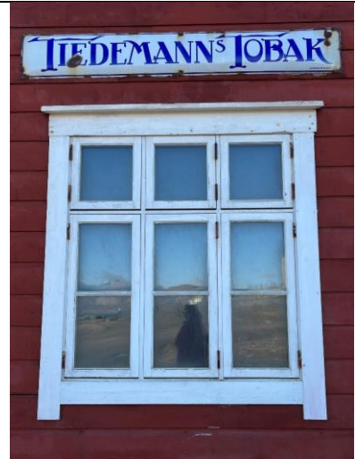
To butikkvinduer i 1. etasje mot nord er erstattet av grove kopier, med opprinnelig inndeling.
