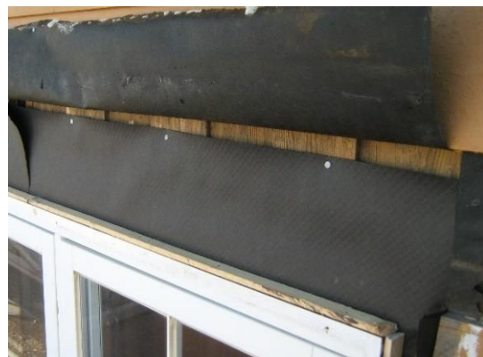
Opprinnelig vekselpanel avdekkes over vindu, det er umalt. Kilde: Hermansen 2012
