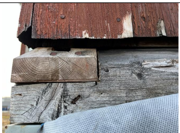
2024: Opprinnelig bunnsvill er skrånkjært for legging av vannbrett (fjernet 1959). vekselpanelet er tilsvarende skrånkjært, med spiss ende som sto tett ned mot vannbrettet. Glimrende tilstand på endeveden etter førti års værbelastning (1919–59).
