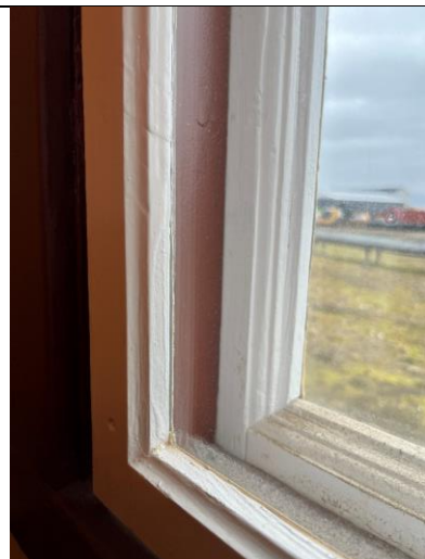
Opprinnelig vindu med eldre varevindu i stuas nordvegg.
