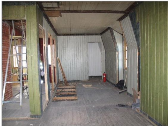
Når nyere materialer ble fjernet i 2. etasje, ble opprinnelig panel og spor etter skillevegger avdekket. Foto: Siri Hoem 2010
