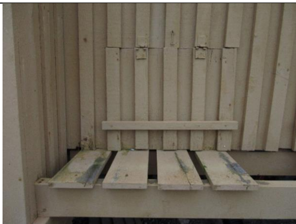
Luke for dotømming i mellombyggets nordvegg.
