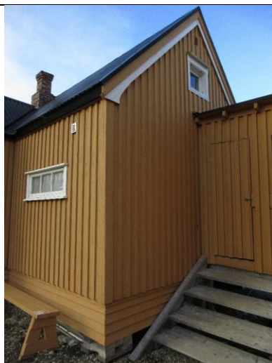
Gavlvegg øst mot mellombygg/uteto fra 1960.
