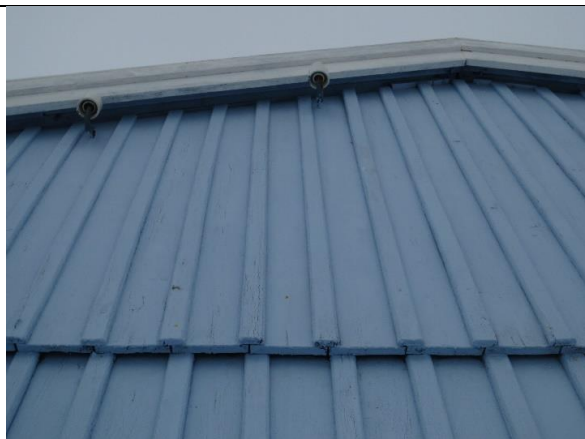
Typisk lek tepanel. På kortvegg er kledningen i gavltrekanten bygget noe lengre ut enn i hovedetasjen.
