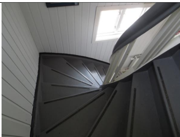
2023: Selve trappeløpet er bevart som i 1919, men med ny bemaling og ny skyggepanel på veggene.
