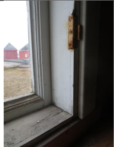
Vindu mot nord. Rammene er profilert med staff og hulkil, typisk for 1. driftsperiode. Hengsler fra varevindu, trolig en forbedring i 2. driftsperiode.
