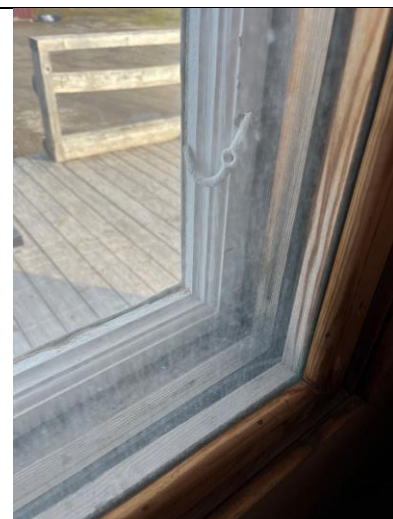
Opprinnelig vindu fra 1919, profilert med hulkil og staff og med bevart haspe. Nyere varevindu med isolerglass.
