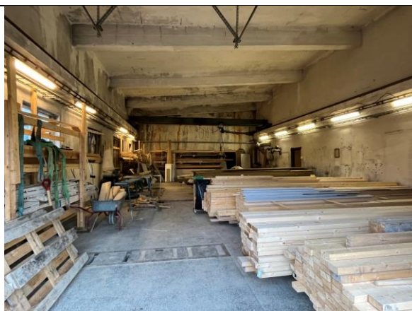
Interiør i dagens materiallager i lav fløy fra 1957. Støpt tak med dragere.
