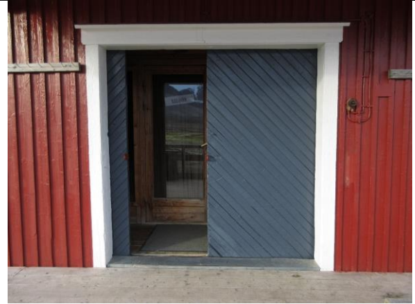
Opprinnelig hovedinngang med skyveporter, over plattingen mot sørøst. Lektene på kledningen går nå litt ned bak den hevete plattingen.
