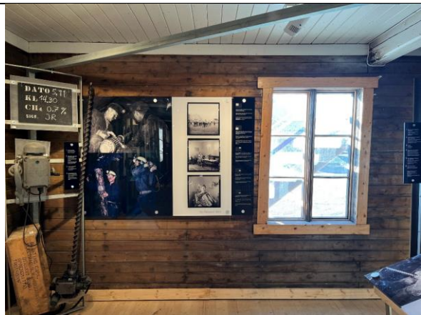
Mot sør. Opprinnelig vindu med ny belistning.
