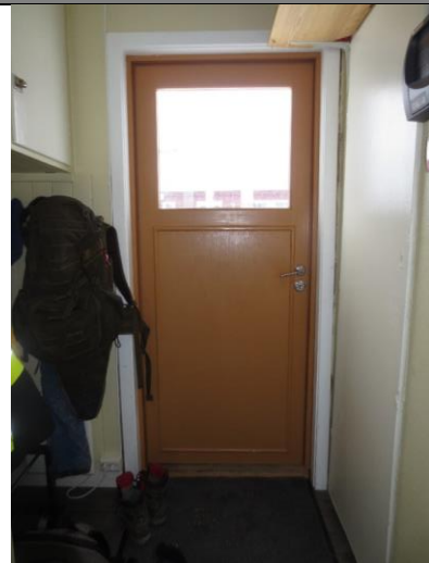
Nyere inngangsdør fra 2011 i bislaget. Vegger med malte plater.
