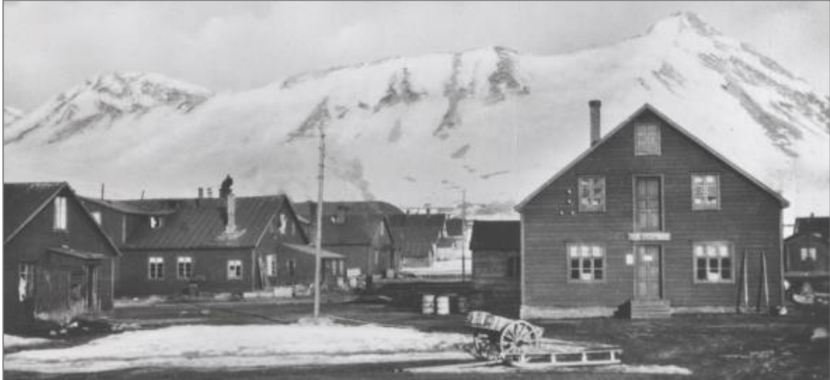
Utsnitt av postkort (før 1940). Butikken til høyre. Mot gata ses utbygget med saltak mot øst. Det er murt opp ei høy pipe. Butikken og lagerloftet har samme type dører. Foto: Svalbard museum
