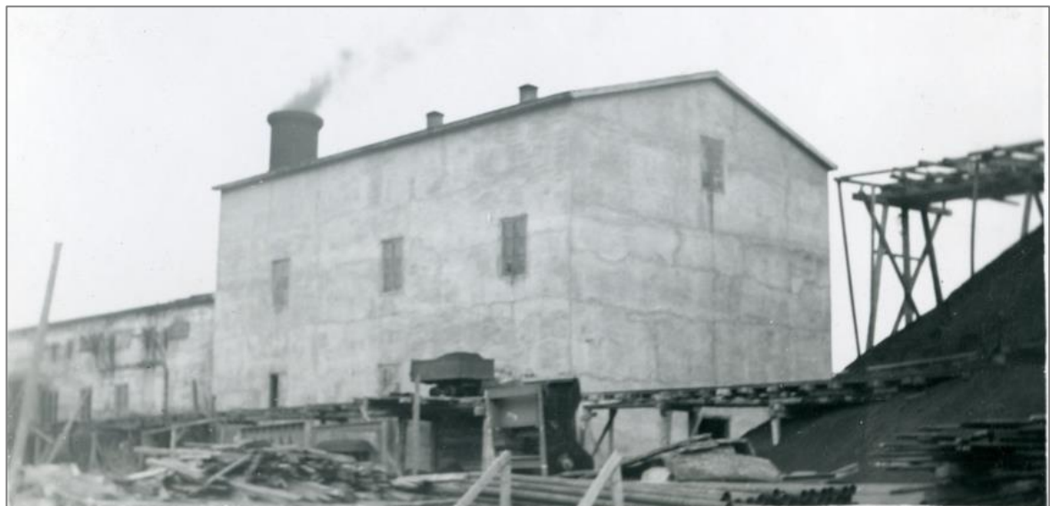
Foto 1950: «Ny kraftstasjon ferdig bygd.» Det er igjen røyk i den gamle pipa. Foto: Arne Brøgger, Svalbard museum, SVF 00666
