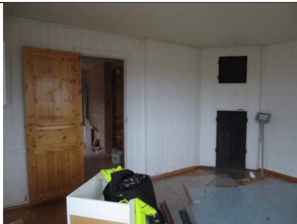
2023: Interiør i stue nordøst i 1. etasje. Skrå brannmur/pipe med integrert støpejernsovn og varmluftsventil.
