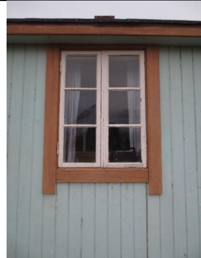
Opprinnelig torams vindu, ett på hver langvegg nord/sør i hovedhuset. Typiske gerikter.
