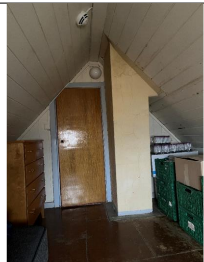
Vestre soverom, med opprinnelig pipestokk som er pusset og malt. Huntonittplater på gulvet.
