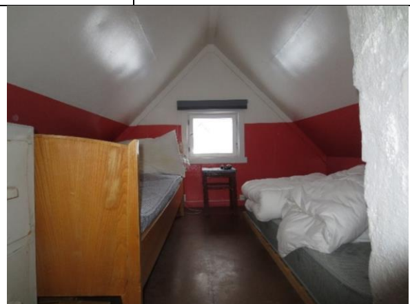
Opprinnelig platekledning på vegger og takflater ble malt opp i 2013–14 i samme farger som eksisterende.
