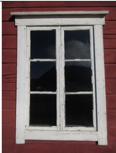
Antatt opprinnelig vindu mot sør. Faste rammer som er spikret fast.
