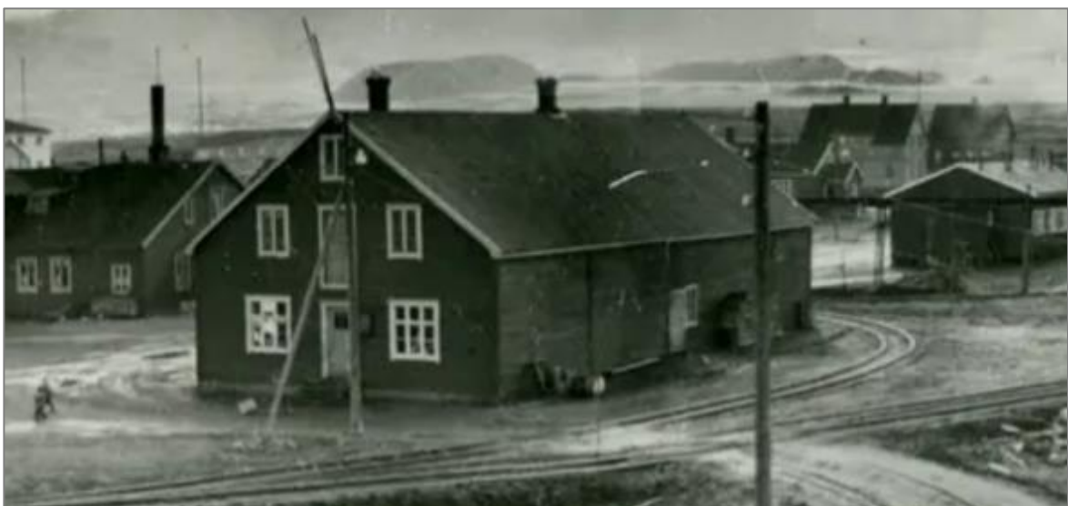
Lageret i 1958–59. Døra til butikken har fått glassfelt. Mot vest er det satt inn et lite vindu ved siden av døra. Kilde: ukjent, Svalbard museum, SVF 25661 (utsnitt)
