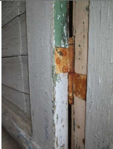
2023: Detalj av opprinnelig dør, fyllinger laget av liggende bord med enkel ytre profil/platte. Opprinnelig eikenøtthengsel. Her finner vi en underliggende grønnfarge, som også har vært på vinduene (før moderniseringen i 1959).
