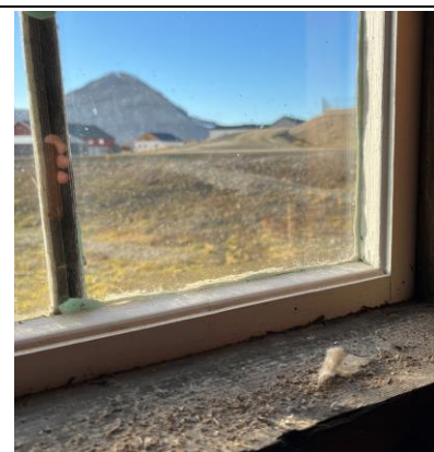
Det ene vinduet mot vest er skiftet i nyere tid. Rammen er enkelt profilert og srossen er ikke gjennomgående.
