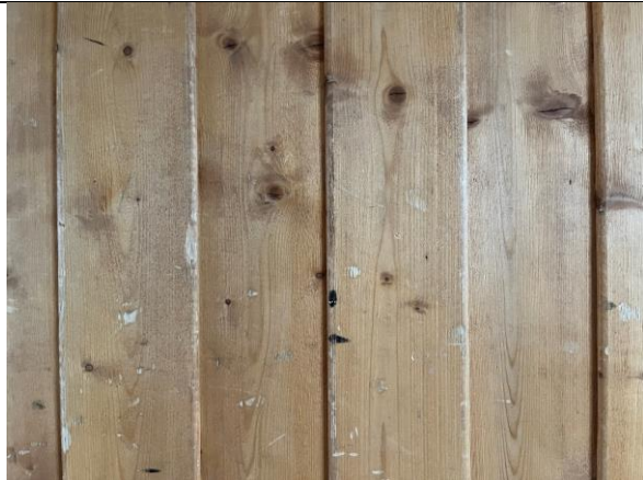
Vekselpanel med avrundet kant på vestveggen i trimrommet. Overflaten er trolig oljet, antatt som utført i 1962.
