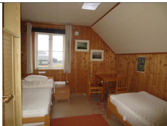
Typisk interiør i soverom 2. etasje, med nyere skyggepanel på veggene og platekledning i taket.
