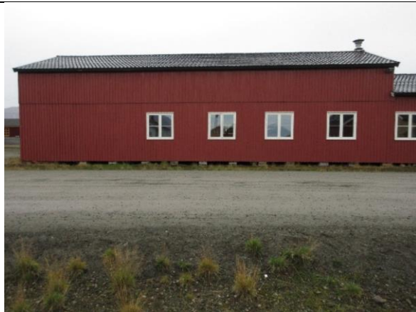
Forsamlingsalen fasade øst. Påbygget fra 1962 er synlig med panelskjøt over opprinnelig vegg høyde fra 1945. Ett vindu lengst til venstre er blendet, se senere nærbilde av dette.
