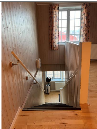
Gangen i 2. etasje, nye kledninger omkring opprinnelig trappeløp.
