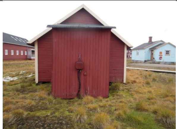
Fasade vest med tilbygget bislag og elektrisk anlegg/el-boks fra 2. driftsperiode.
