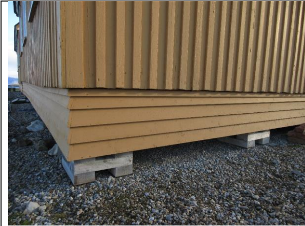
Etter refundamentering i 2015 er huset hevet med et høyere skjørt av liggende bord.
