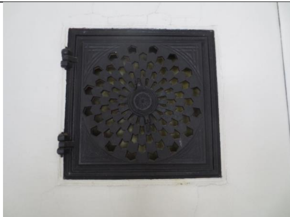
2023: Jernluke/ventil i øvre del av pipe/brannmur i stue. Det er fine dekorative detaljer i overflata.
