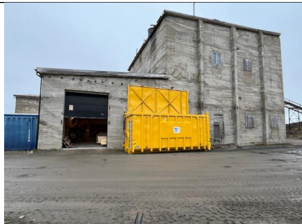
Fasade sør, med to bygninger fra 1957. Begge disse står med rå betong uten puss. Nyere rulleport.
