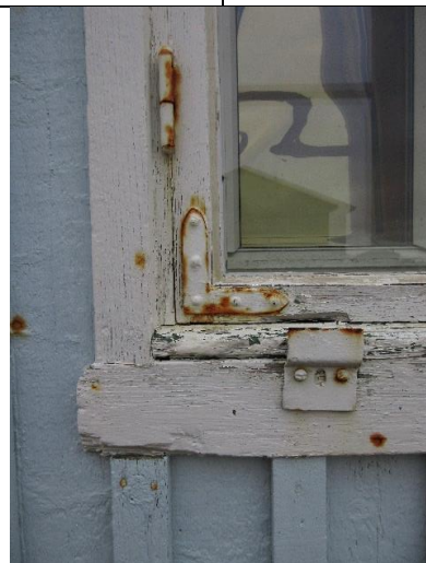
Tidstypiske flate og spisse hjørnejern og enkle sylinderhengsler. Vannbrett under vindu av tre, uten beslag.
