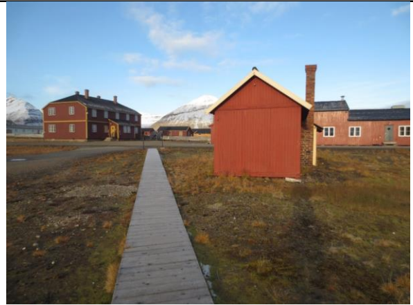
Fasade øst, gangvei over tundraen. Kortveggen består av tre lemmer som er slisset inn i synlige sviller nede og oppe.
