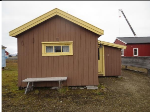
Fasade sør. I 2. driftsperiode ble hovedvolumet forlenget mot sør og tilbygg/bislag oppført mot øst.
