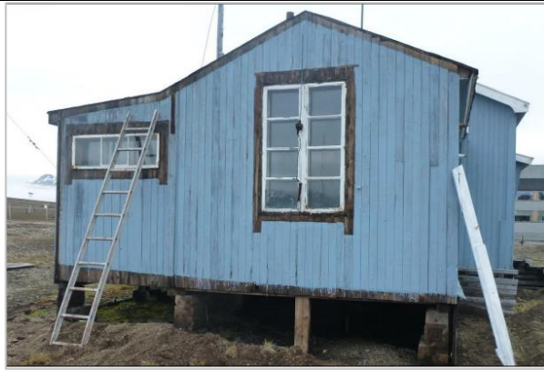
T.v.: Under restaurering 2013. Spor i malingen etter vannbrettet, montert et stykke opp på kledningen, som utført ved flytting 1946. Negative spor etter stedstypiske gerikter. T.h.: Utbedring av taktro over bislaget mot sør. Taket fra 1918 (med røykrør) har liggende taktro, (ikke lemmer). Foto: Kings Bays arkiv
