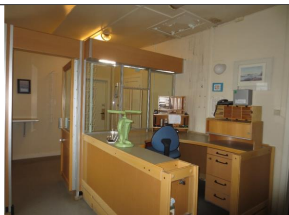
Nyere innredning med ekspedisjonsdisk fra 1990-åra. Lettvegg av glass med integrert dør. Midt på veggen t.h. er opprinnelig pusset brannmur.
