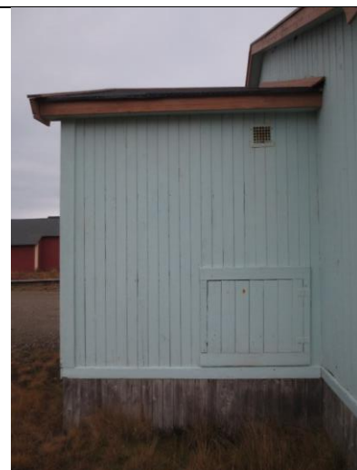
Bislagets sørvegg, tett luke, ventil med stålrisk. Luke i bislag for dotømming.
