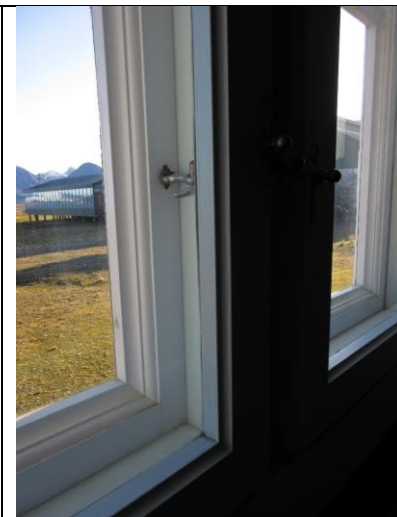
Vinduene fra 2011 ble laget som kopier av de opprinnelige, med hulkil og staff på rammene. Innvendig varevindu.
