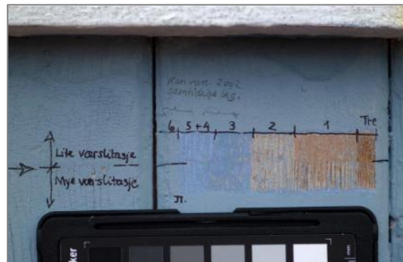
T.v.: Rustbehandling av beslag, jernmønje fra Molo AS. Ny rust oppsto raskt. Foto: Kings Bays arkiv. T.h.: Fargeundersøkelse under vindu nord i boligdel fra 1929. Her ses fargelagene 1. lys grårosa, 2. lys grågul og 3. lys blå. Den opprinnelige rødfargen på bygningen fra 1918, mangler her. Kilde: Treider 2012
