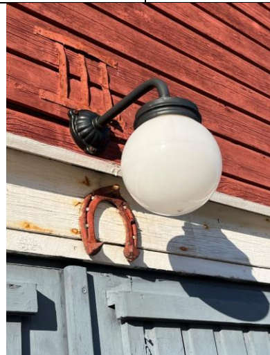
Over hovedinngangen er det bevart et opprinnelig skilt av stålremser, (Brakke) III. Dette har høy historisk verdi, jf. tilsvarende skilt nr. II på nr. 33 Mellageret. Eldre lampe, typisk for 2. driftsperiode, samt hestesko.
