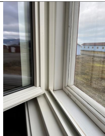
Opprinnelig koblet ytre vindu, nytt varevindu med isolerglass 2017.
