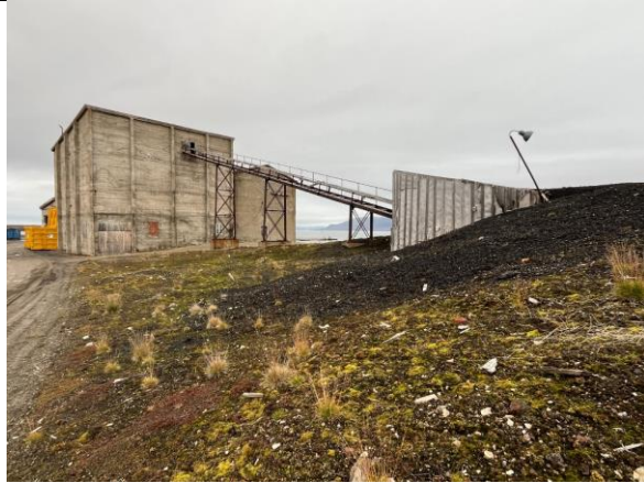
Fra sørøst. Stasjonen fra 1949 til høyre, tilbygget kraftstasjon fra 1957 til venstre. Transportanlegg for kull med understøttende bein av stålfagverk.
