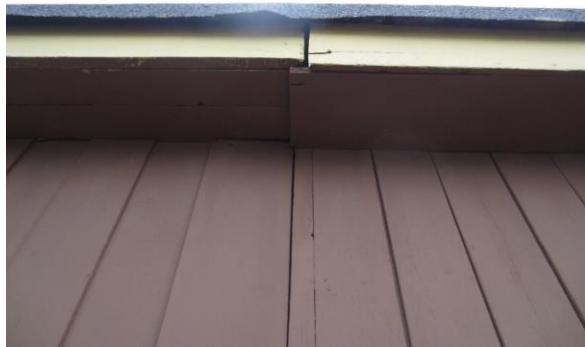
Detalj av fasade vest, der overgangen mellom opprinnelig brakke og tilbygg ses i både kledning og takutstikk.
