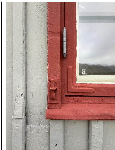
Typisk opprinnelig vindu med formpresset hjørnejern og nyere/restaurerte hengsler med konisk tupp. Hengsel for lem i karm.
