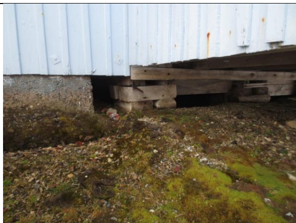
Deler av bygget er fundamentert på den støpte grunnmuren anno 1919 som sto igjen etter det tapte sykehuset. T.h. overgang mot fundament på trepakninger.
