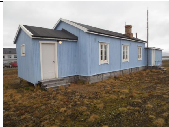
Fra sørvest, inngang boligdel. Bislaget fra 1929 ble utvidet med tilbygg og ny dør mot sør ca. 1954. Til høyre for døra, i vegg fra 1929, er det en innebygget eldre døråpning (dørhengslar ses i skap inne).
