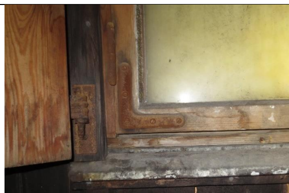
Detalj av opprinnelig koblet vindu og hengsler. Hjørnejernene har en karakteristisk formpresset utforming, antatt svensk fabrikat.
