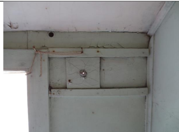
Til høyre for vinduet er en ventil med skyveluke, se eksteriør. Denne ser ut til å være samtidig med skilleveggen til høyre.
