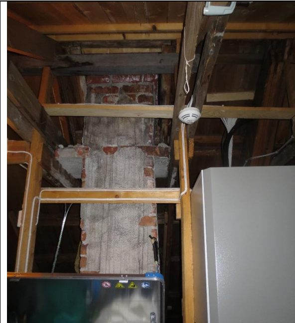
Antatt opprinnelig pipestokk på loftet, med rester av puss. Utmurt krage i nivå med hanebjelken tyder på ombygging.
