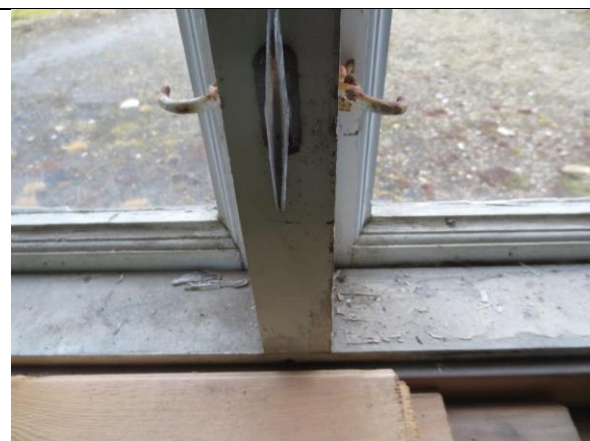
Detalj av vindu mot nord, med opprinnelige hasper. Rammene er profilert med hulkil og staff, typisk for 1. driftsperiode.
