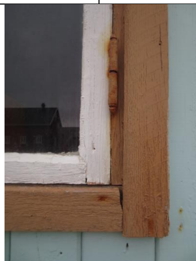
Detalj vindu nord med eikenøtthengsler. Knappere gerikter enn øvrige vinduer.
