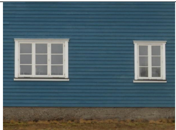
Typiske nyere vinduer med tre ruter i hver ramme, her fra 1. etasje mot nord.
