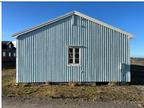
Kortvegg mot øst, Ny Mexico. Denne delen står på en gammel støpt grunnmur fra 1919. Opprinnelig lektepanel og vindu fra 1949.
