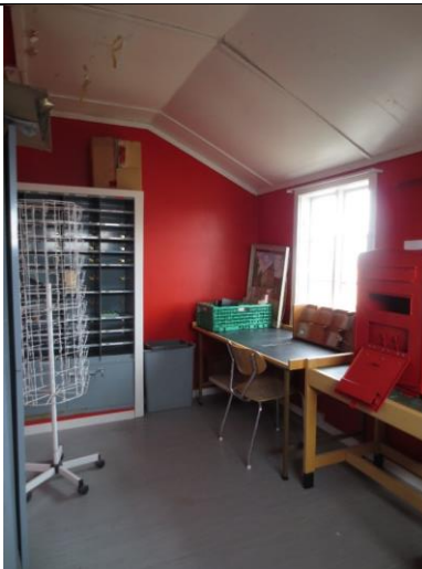
Kontor mot nord, med brukket himling under hanebjelken, som opprinnelig form. Platekledning fra 2. driftsperiode.
