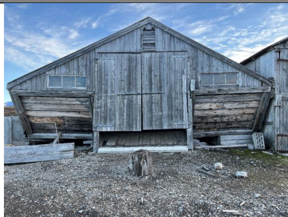
Den ombygde kullprammen med porter og overbygg. To liggende vindusrammer, gjenbrukte elementer med noe ulike detaljer.
