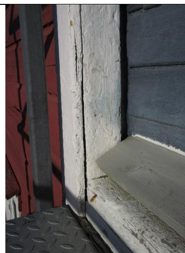
Loftsdør sør, nytt vannbrett for å redusere vanninntrengning.
