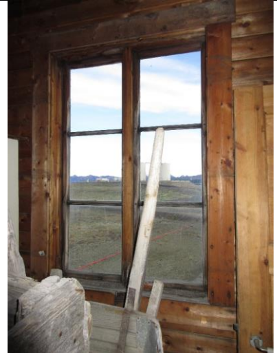
Ett av to opprinnelig vinduer mot nord i loftets hovedplan.
