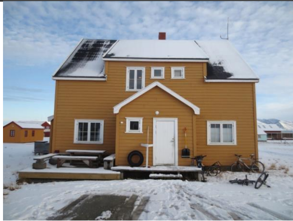
Fasade sør. Hovedvolumet er som opprinnelig, etter at påbygg/observasjonsplattform fra perioden med Norsk Polarinstitutt er fjernet.
