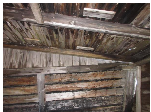
Pulttak med sperrer og bordtak/lemmer i det lille tilbygget mot øst.
