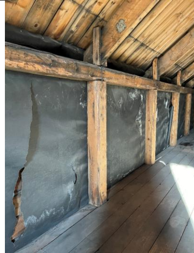
Knevegg mot nord. Opprinnelig konstruksjon, stendere støtter opp en drager under sperrene. Bak pappen er det liggende kledning.
