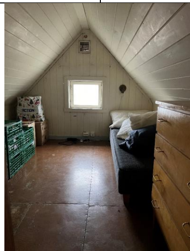
Soverom mot vest. Umalte 1950-talls huntonittplater er spikret over bordgulvet. Vegger og himling malt pløyd faspanel.
