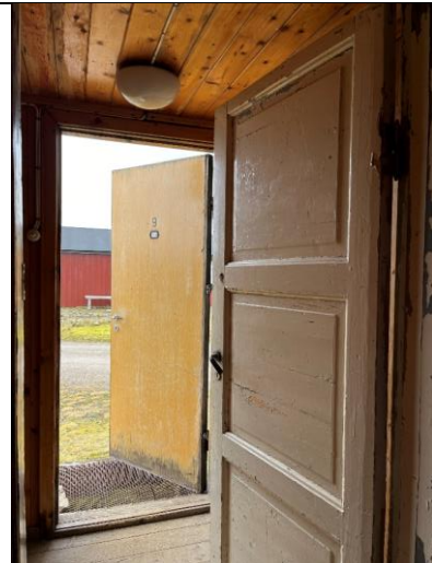
Fra forgang sett ut i nordre bislag. Eldre fyllingsdør, med platebeslått utside. Se detaljer på bilder t.h.
