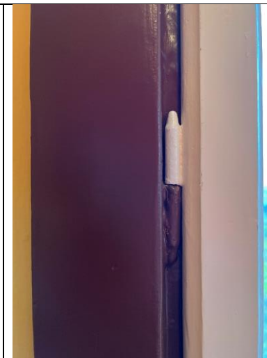
Varevinduet mot nord har tidstypisk hengsel med konisk dråpe og antas å være opprinnelig fra ca. 1919.
