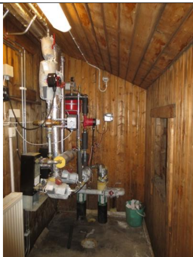
2023: Interiør i tilbygg bislag øst. T.v. er opprinnelig yttervegg i bislaget anno 1919, se foto under.
