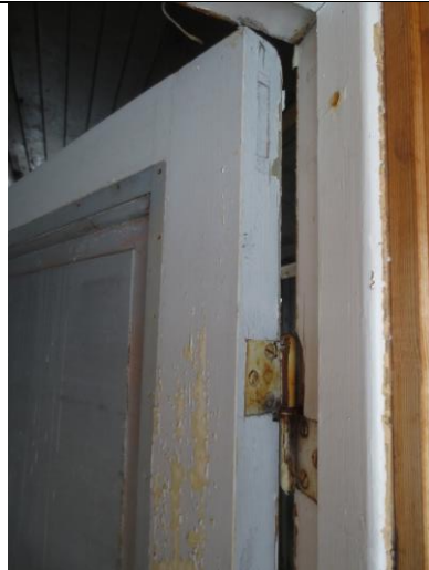
Tradisjonell fyllingsdør med ramtre og sliss/tapp i sammenføyningene.
