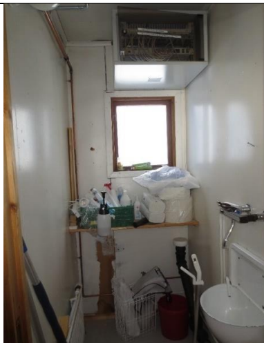
Opprinnelig koblet vindu i bøttekott mot nord, se foto eksteriør.
