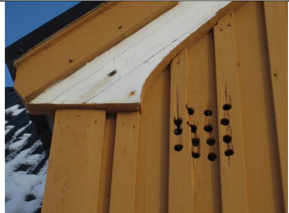
Enkel ventil med borehull i vegg i bislag, typisk for Ny-Ålesund på denne tida.
