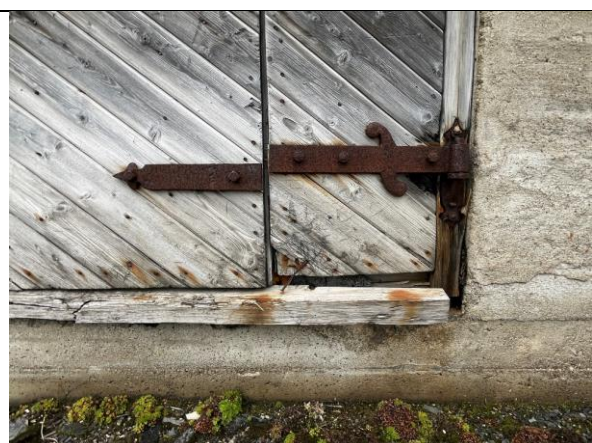
Detalj av port, jf. bildet t.v. Stabelhengsel og fint dekorert jernbeslag, som er brukket.
