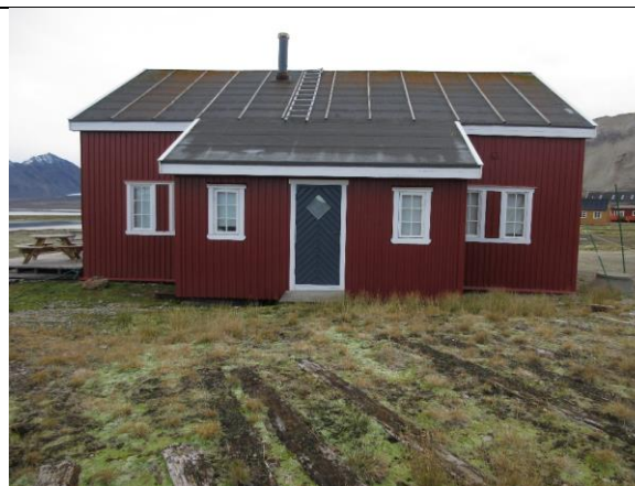
Fasade nord. Tilbygg med inngang og toaletter ble oppført i 1992. Vinduene i hovedfasaden er fornyet, etter riving av eldre tilbygg/saltskur (etter 1973).
