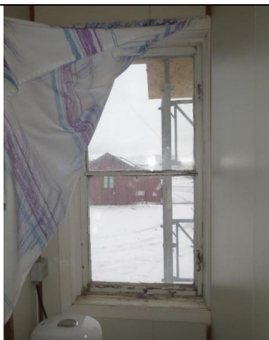
Del av opprinnelig tofags vindu fra 1945, koblet utførelse. Delt i to av skillevegg i damenes bad/WC.
