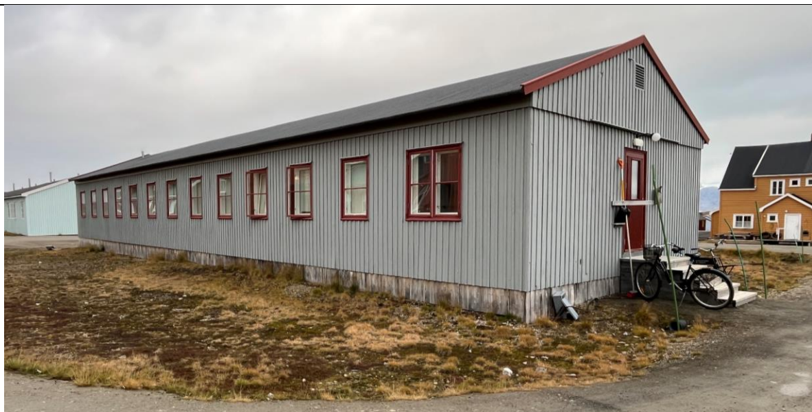
Langfasaden mot sør og østre gavl, med ny inngangsdør og trapp, der det opprinnelig var et tilbygg/bislag med do og kullbod. Lektepanelet og vinduene er opprinnelige fra 1945. Ny ventil i gavl mot råloft.
