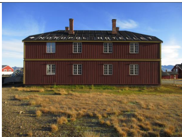
Fasade sør. Tilbakeført med vindustyper og fire piper, i prinsippet som oppført i 1919. Påmalt skilt på taket, «Nordpol hotellet», som etablert på 1930-tallet.
