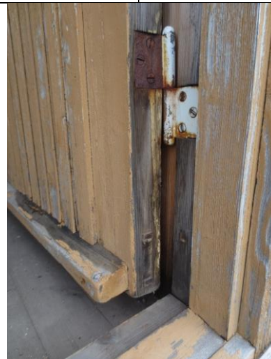
Ramtredør med utvendig smal panel og vannbrett, som er festet utenpå den opprinnelige fyllingsdøra.
