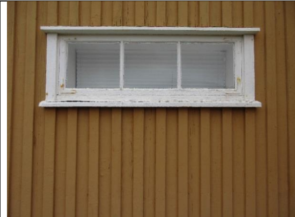
Typisk vindu mot sør.
