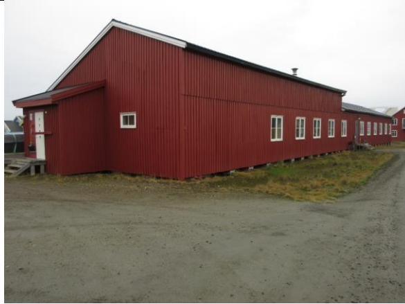
Bygningen fra sør, der forsamlingsalen ble påbygget i 1962. Hovedfasaden langs gata i øst.
