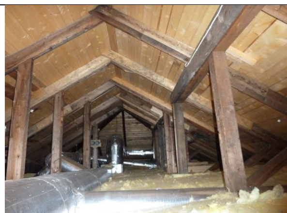
Loftet er bevart med opprinnelig konstruksjon, sperrer og understøttende drager/stolper. Taktroa er for en stor del fornyet. Isolasjon og kanalføringer over gulv/hanebjelkenivå. Foto: Kings Bay 2012
