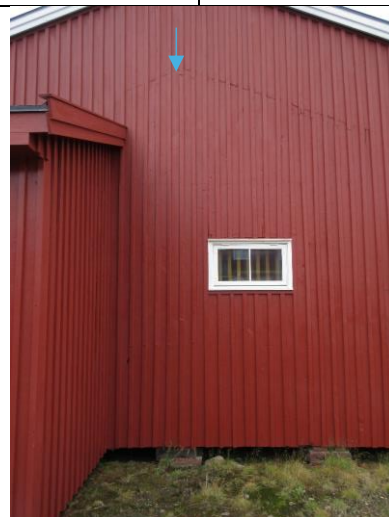
I sørveggen ses tydelig spor etter den opprinnelige svenskebrakkas volum/gavl i form av panelskjøt. Pil markerer mønet.
