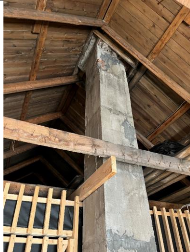
Opprinnelig pusset pipestokk midt i loftsrommet.
