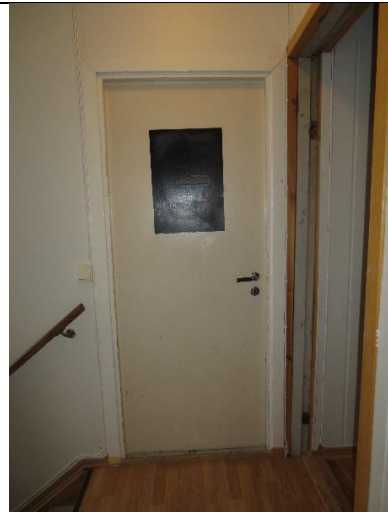
1950-tallsdør i gang 2. etasje, overmalt finérdør med opprinnelig dørhåndtak.
