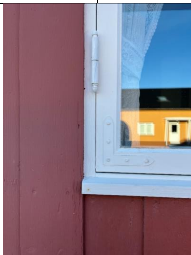
Detalj av rekonstruert vindu. Hjørnejern og beslag med eikenøtthengsel er forsøkt kopier slik man antok det var i 1918.
