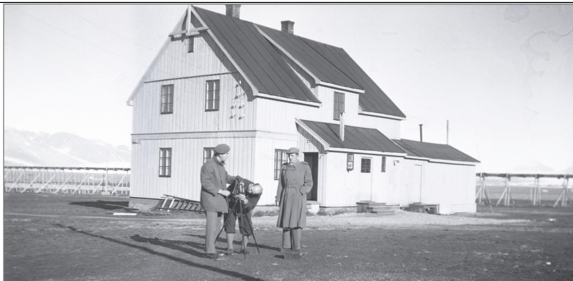
Foto 1948–49. Huset har stadig opprinnelig stående kledning (nymalt) og opprinnelige vinduer. Bislaget har to inngangsdører, med skilt nr. 23 over døra. I bislaget var det også bøttedo og kullbinge, som tegnet av arkitekt Flor. Mast i gavl er senere fjernet. Seksmannsbrakke nr. 8 fra 1918 ble flyttet i 1945 og oppført som tilbygg mot øst. Foto: NN, Svalbard museum
