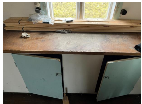
Detalj av kjøkkenbenk, med nedfelt huntonittplate.
