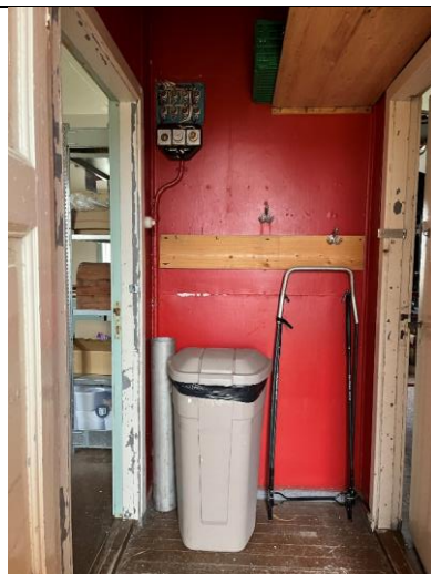
Forgang med platekledd vegg.
