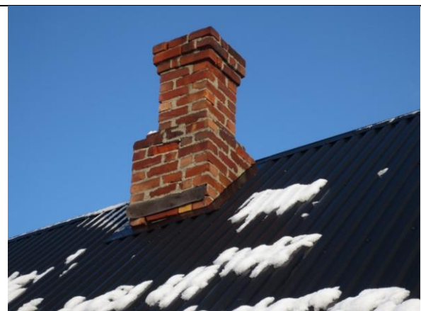
Pipe oppmurt ved gjenoppføring i leiren i 1950-åra. Rød tegl og sementrik mørtel. Beslagløsningen under stålplatetekkingen er ikke kjent.
