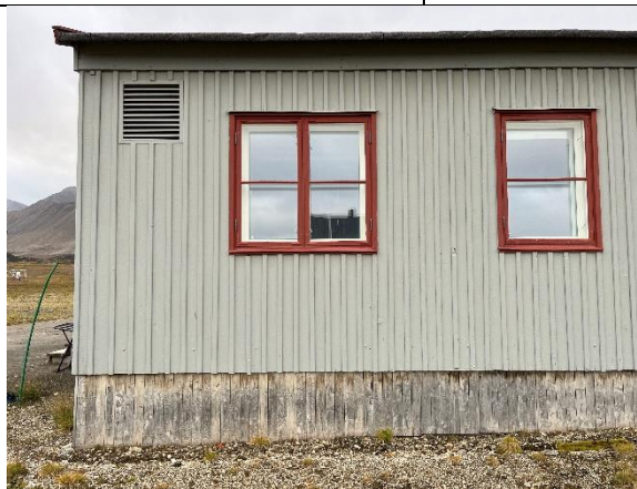
Utsnitt fasade nord, med tofags vindu i rommet i østenden, som opprinnelig. Nyere ventil i vegg.
