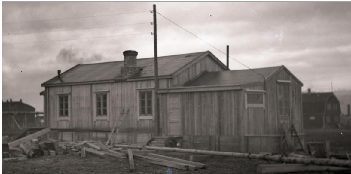
Telegrafan fra sør etter flytting 1946. Sør for selve telegrafan i østre del ble det bygget et nytt tilbygg med egen inngang. Her sto det i 1946 ei fyllingsdør med tre speil, denne ble fornyet omkring 1960. De eldre fasadene er svært malingslitt. Foto: Arne Brøgger, Svalbard museum (beskåret)
