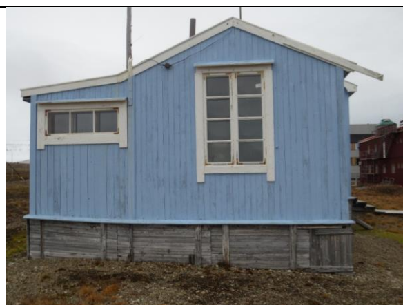
Fasade øst. Opprinnelig bygning fra 1918 med stort vindu, tilbygget bislag/bod slik det var utført etter flytting 1946. Eldre liggende vindusramme er gjenbrukt i bislag. Dette har innvendige profiler lik vinduer fra 1919 og antas å være satt inn her i 1946.
