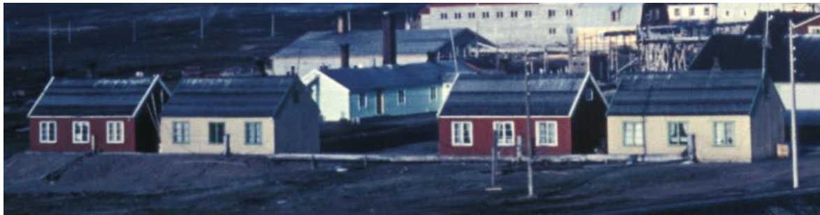
Londonhusene i 1962. London 2 har røde vegger og hvite vinduer, mens London 1 har okergul vegg og grønne vinduer. Før dette hadde alle hus grønne vinduer og ytterdører. Foto: J.Å. Ødegård, Kings Bays arkiv (utsnitt)
