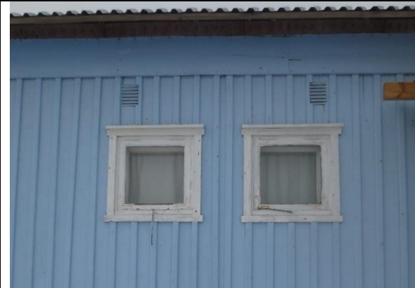
To eldre vinduer til herretoalettet, antatt fra ca. 1958.
