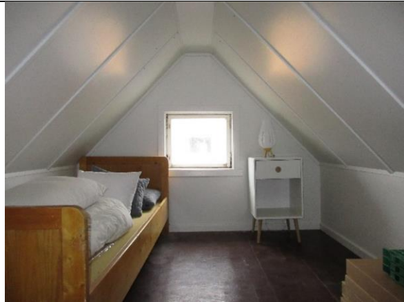
Loftsrom mot vest er bevart med huntonittplater på vegg, himling og gulv, typisk for 1950-tallet.
