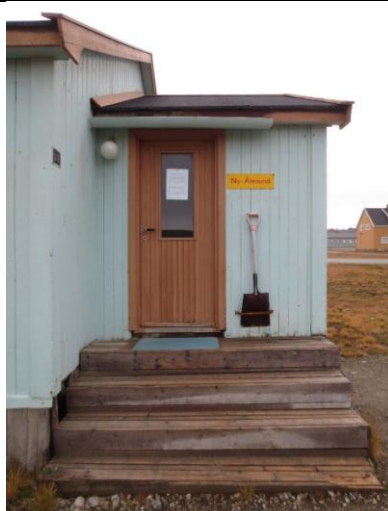
Bislag med tradisjonell tretrapp med innklede sider.
