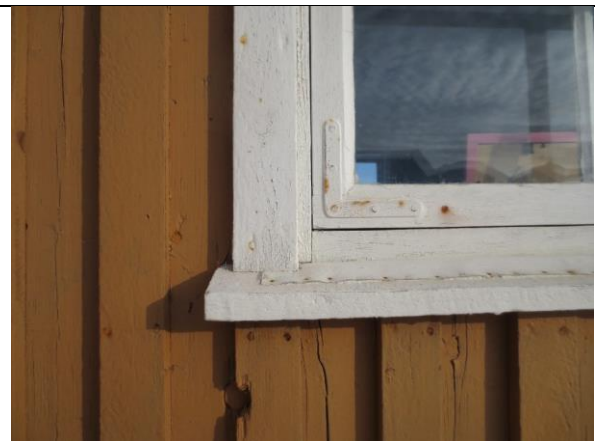
Detalj av vindu mot sør, med avrundete hjørnejern typisk for 1950-tallet, jf. bildet t.v. Under vinduet er et plugget hull, som vitner om avstivende konstruksjon/bolt da huset ble løftet av fundamentene i 2013.
