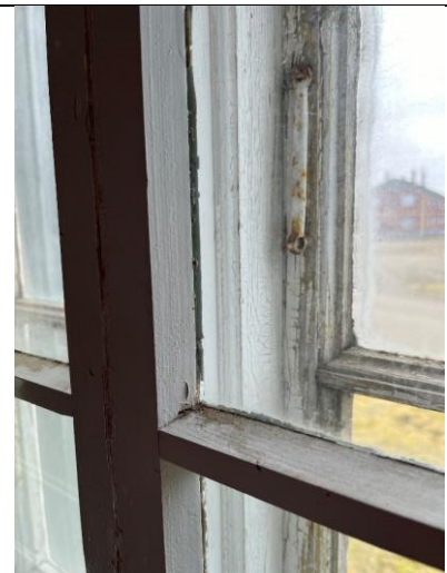
Vinduet mot øst i kjøkkenet har rammer og sprosser med en sjelden karnissprofil, antatt opprinnelig fra gruveområdet.
