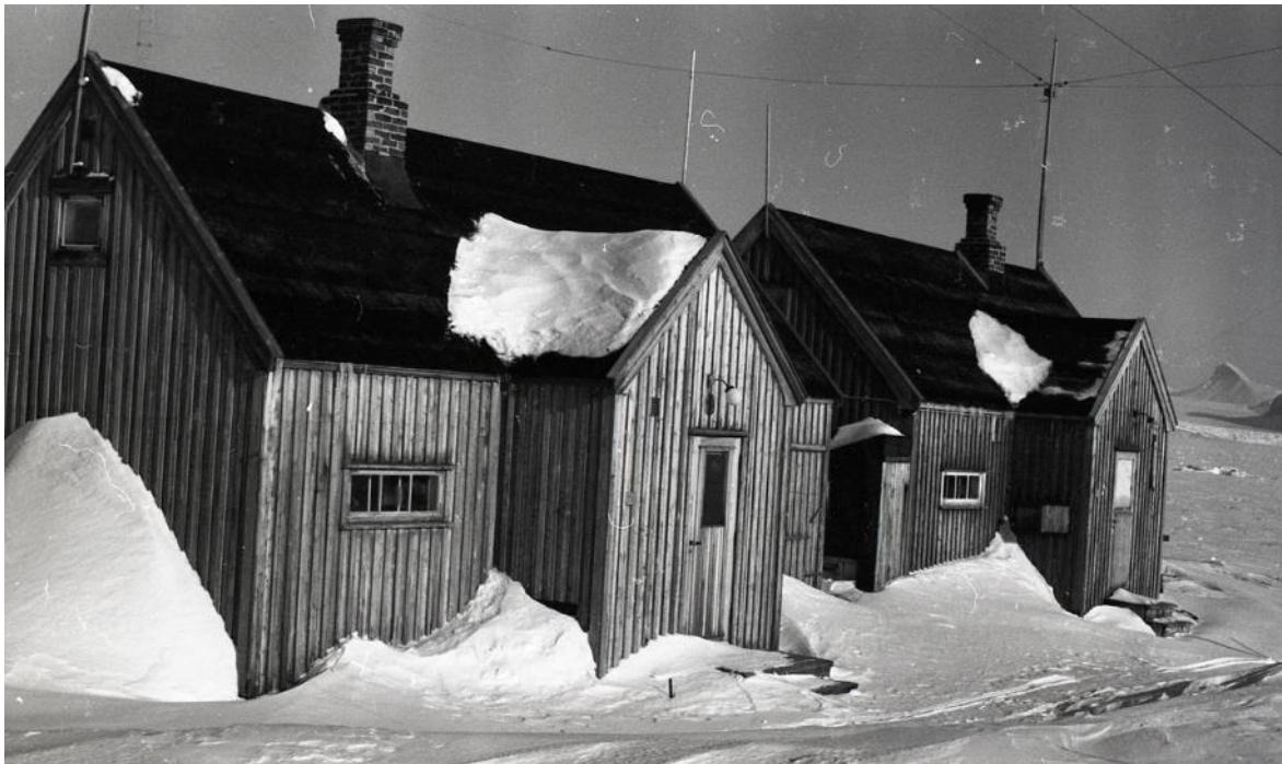
London 3 (t.v.) og 4 fotografert 1976–78. Malingen er svært nedslitt. Over døra er det en lampe med buet stang og hvit glasskuppel. Foto: Lilleba Knudsen, Svalbard museum, SVF 07574
