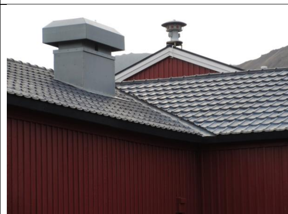
Taket på hovedbygningen og tverrfløyens nordre takflate er tekket med korrugerte stålplater som imiterer taktegl. Tekkingen er relativt ny og uhistorisk. To nyere ventilasjonspiper. I bakgrunnen ses hevet tak over salen anno 1962.
