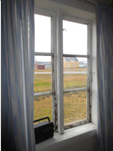
Opprinnelig torams vindu mot sør, med profilerte rammer, sprosser og midtpost.
