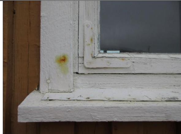
Detalj vindu mot sør, hjørnejern med rund ende. Merk beslaget som ligger på deler av vannbrettet.
