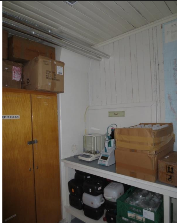
Interiør i laboratorium (stort rom mot nord), med pusset pipe og brannmur. Opprinnelig panel på vegg og himling.
