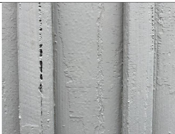
Detalj av opprinnelig lektepanel, med skrå avfaset kant på lekten t.h. og rester av nedskrapet maling.
