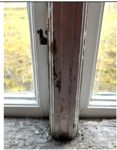
Detalj av vindu mot vest i stua, med profilert midtpost.
