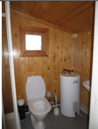
Toalett i tilbygg øst, modernisert med nye panelte vegger og isolerglassvindu i 1994.
