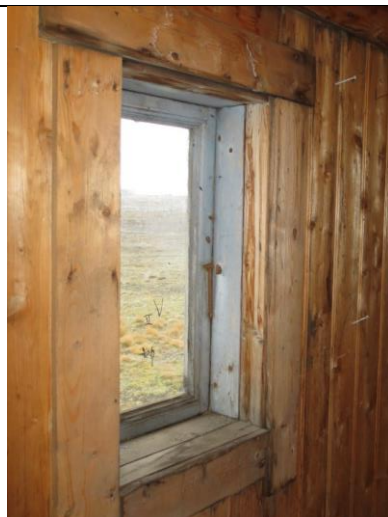
2023: Opprinnelig vindu øst i bod.
