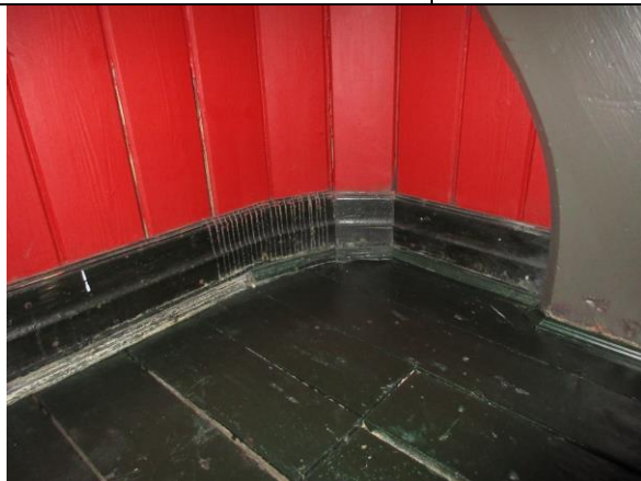
Opprinnelig gulvlist fra 1918 ved siden av trappa i gangen. En interessant detalj, der vi ser tett med sagspor i lista for å tilpasse den til krumningen.
