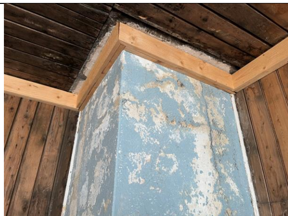
Opprinnelig pipestokk i rommet vist over. Pusset mur. Ulike typer pløyd panel på vegger og himling, opprinnelig perlestaffpanel på nordvegg mot butikk.
