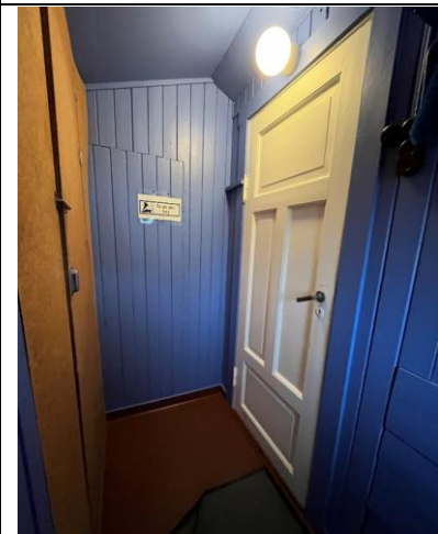
Gang, opprinnelig kjøkkendør med fire speil, se detaljer t.h.
