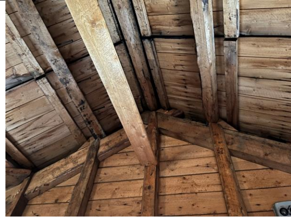
Takkonstruksjon og kraftige stendere i gavlvegg med liggende kledning. Utenpå er det stående lektepanel.
