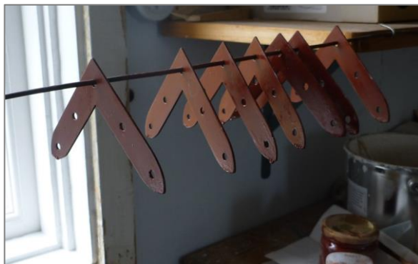
T.v.: Rustbehandling av beslag, jernmønje fra Molo AS. Ny rust oppsto raskt. Foto: Kings Bays arkiv. T.h.: Fargeundersøkelse under vindu nord i boligdel fra 1929. Her ses fargelagene 1. lys grårosa, 2. lys grågul og 3. lys blå. Den opprinnelige rødfargen på bygningen fra 1918, mangler her. Kilde: Treider 2012
