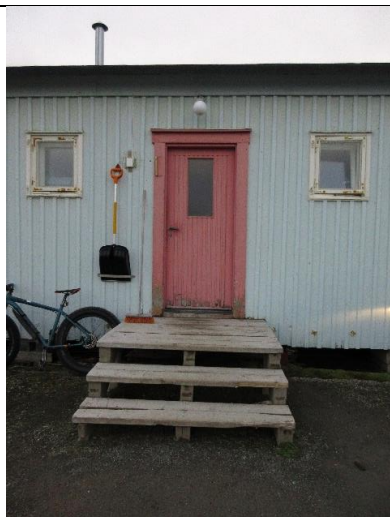
Inngangsparti mot nord med to vinduer anno 1945.
