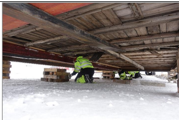
Forberedelse til refundamentering 2019. Trepakninger fra 1987 ble erstattet av stålramme og stålplater. Høyre bilde viser hytta sikret med jekkestropper og satt på stålrammen, før peling. Foto: Kings Bay AS
