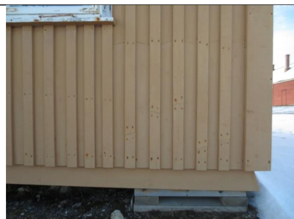
Etter refundamentering i 2008 er bygningen hevet mer opp fra terrenget og satt på nye trepakninger. Ett dekkbord er supplert i underkant av kledningen.
