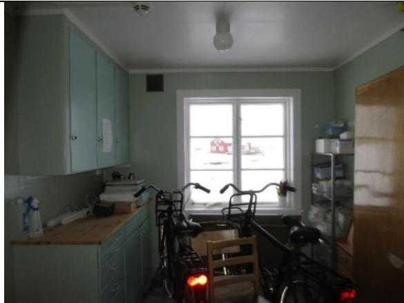
Også kjøkkenet ble fornyet med malte huntonittplater utenpå de gamle i 2013. Skap fra 1950-tallet ble bevart/remontert.
