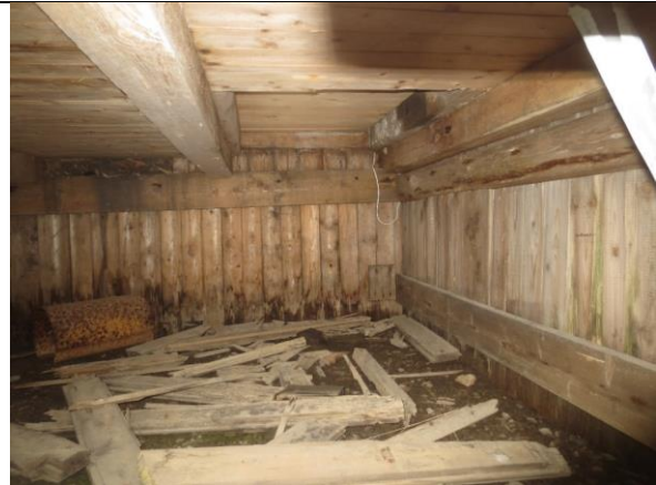
Innkikk under bislaget, sett inn mot hovedhusets vestvegg. Skjørt på hovedhuset av pløyd faspanel.
