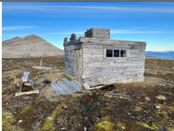
Varmestua fra sørøst. Luftesjakta stikker opp i bakgrunnen. Flere rustne spader ligger henslengt i området rundt hytta.
