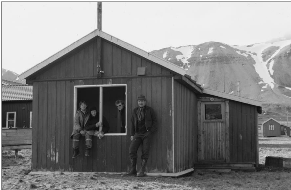
Hytta ved oppstart av restaureringsarbeidene i 1987, med intakt tilbygg mot vest og inngangsdør fra 2. driftsperiode. Opprinnelig vindu antas bevart, her tatt ut for restaurering. På eldre foto før restaureringen ser vi et vindu med seks ruter i hver ramme, lik dagens. Foto: P.K. Reymert, Svalbard museum, SVF 23585
