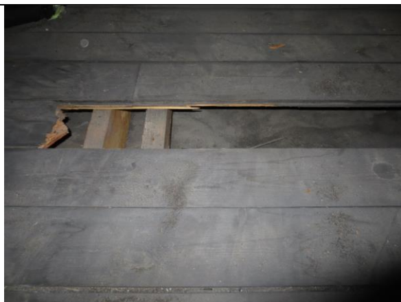
Bordgulvet på loftet er bygget noe opp, med luftlag/papp under. Det er usikkert om dette er opprinnelig løsning.
