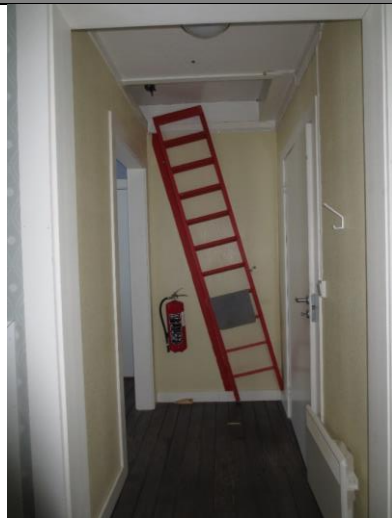
Gang med stige til loftet, stigen er hengslet og festet til veggen.
