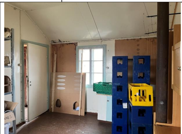
Interiør i midtrommet/kjøkkenet, sett mot øst. En mindre kjøkkenbenk med utslagsvask (med utenpåliggende vannrør) er skjult bak kassene.
