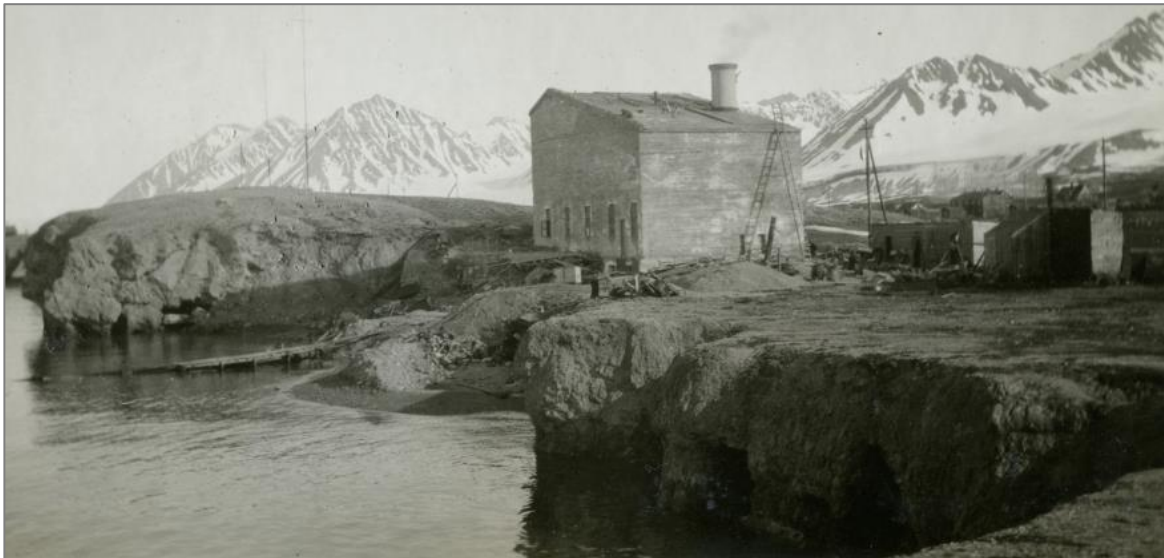
Kraftstasjonen under bygging i juli 1928. Foto: Ukjent. Svalbard museum, SVF 00484 (beskåret)
