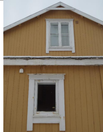
Gavlvegg øst. Enkel topphengslet vindusramme i det nyere bislaget.
