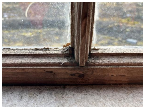
Opprinnelig vindu med slak karnissprofil, tilsvarende finnes på flere hus fra de første årene, som 54 Sætra.
