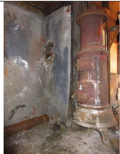
Støpejernsovn og brannmur ved nordveggen, i overgangen mellom husene. Demontert røykrør.
