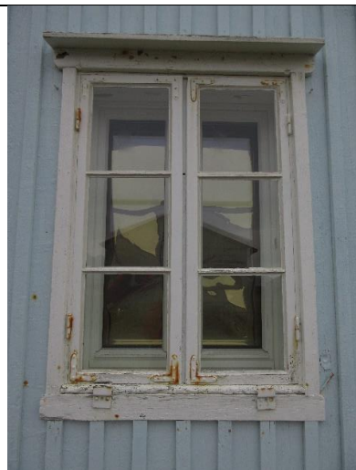
Typisk vindu fra 1949 i tilbygget Ny Mexico. Dette har tre ruter i høyden og andre detaljer enn første byggetrinn, se bilder t.h.
