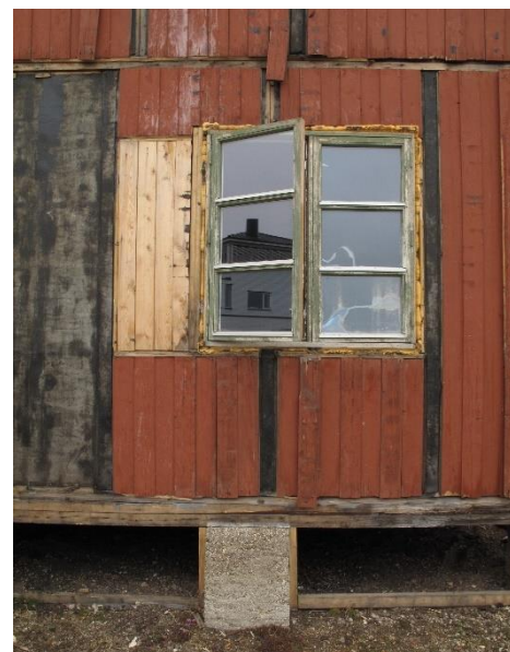
Vindu i ny posisjon, rest av opprinnelig karm i vegg. Pappen ble fornyet over lemskjøtene. Foto: Siri Hoem 2010
