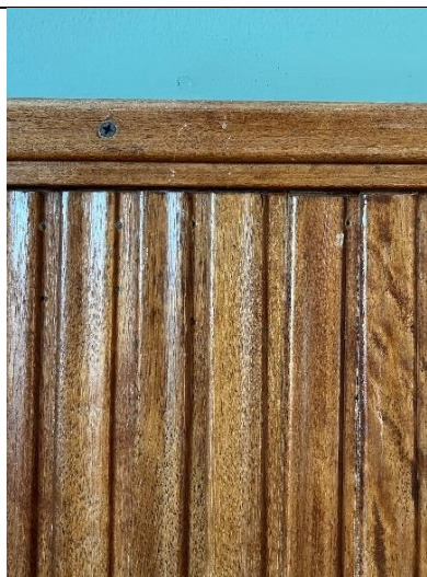
Brystningspanel i 1950-tallsstil, buete riller og lakkert overflate.
