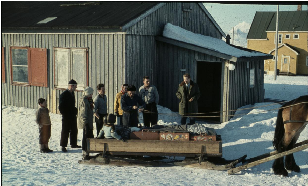
Bygningen har opprinnelig lektepenele og vinduer med lemmer (trefiberplate i treframme). Bygningen har i hovedsak smale ettrams vinduer med to store ruter, men i østenden er det et større torams vindu på hver langvegg (bak dobbel lem), som i dag. Merk lemmen i loftsgavl mot øst, muligens et lite vindu. Gråmalt kledning og røde vinduer er opprinnelig fargebruk, jf. Jon Brønnes fargeplan. Foto: 1956–59, Hans H. Hagens fotosamling, Kings Bays arkiv
