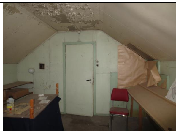
Mot vest, innside av fyllingsdør mot bislag er platebeslått.
