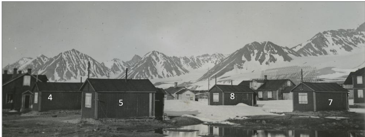
Seksmannsbrakkene i 1935. Fra venstre opprinnelig nr. 4 (senere flyttet/revet), nr. 5 Arbeiderbrakkka, nr. 8 (flyttet) og nr. 7 Syssebu. Nr. 6 Veteranhytta ligger t.h. for bildet. Alle hyttene sto sannsynligvis på trepeler med isolerende jordvoll omkring. Lemmene tyder på at brakkene sto tomme; på denne tida var det driftsstans i gruva. På hytte nr. 5 har røykrøret en uventet plassering, hvis hytta hadde ett åpent rom. Foto: ukjent, Svalbard museum SVF 00530
