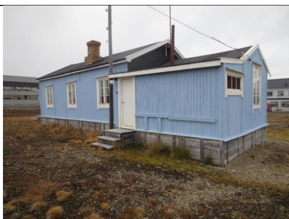
Fra sørøst, boligdelen til venstre og den gamle telegrafan med egen inngang i bislag/tilbygg mot sør.
