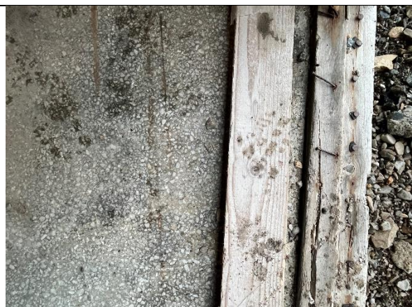
Detalj av terrazzogulv fra 1957, fra inngang/port mot sør i den lave fløyen.
