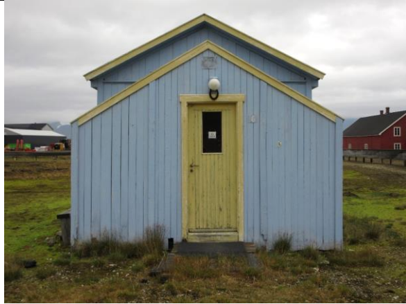
Fasade sør. Opprinnelig bislag fra 1918 fikk tilbygg på hver side ca. 1950.
