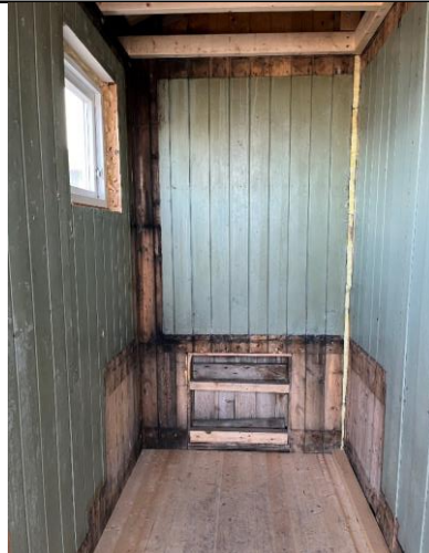
2024: Bislag nord etter avdekking, se bildet under.
