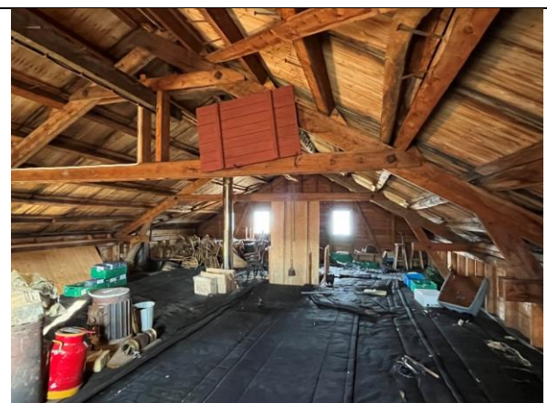
Loftet sett mot øst. En rødmalt vinduslem henger oppunder taket. Piperøret går fritt gjennom rommet.
