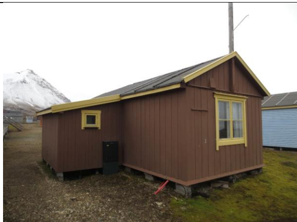
Hytta fra nordøst. Tilbygget med pulttak fra 2. driftsperiode ble tatt ned og gjenoppbygget i 1993-94. Masta på gavlen er en opprinnelig løsning for strømledning med luftspenn.
