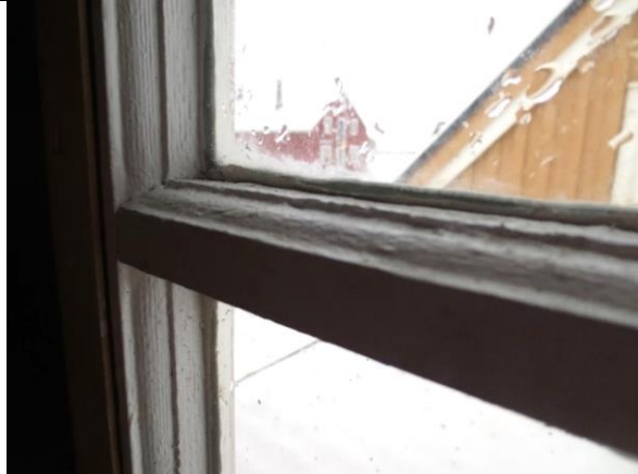
Opprinnelig vindu mot vest, med staffprofil på sprosser og ramme.
