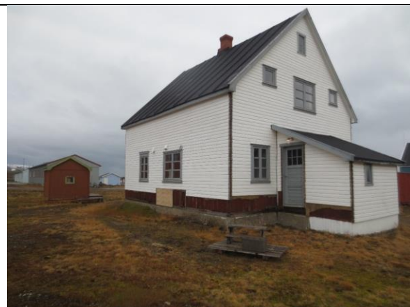
2023: Fra sørøst, før huset ble flyttet av fundamentet. Vindusplasseringen er her i prinsippet som opprinnelig, men formatene ble justert i 1959. Bislag øst fikk tidlig et tilbygg øst for støpt ringmur (før 1938).
