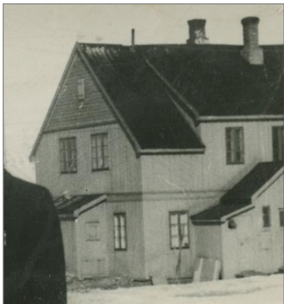
I 1950 hadde huset opprinnelig liggende kledning i øvre gavl og et lite loftsvindu med lem. En pipe er revet og erstattet av et tynt rør. Opprinnelige luker i vegg bislag vest. Foto: Helge Ringen, Svalbard museum
