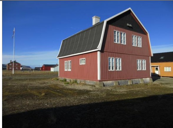
Fra sørøst. Opprinnelig vindusplassering mv. ble tilbakeført i 2011, omfattende bevaring/gjenbruk av opprinnelig kledning.
