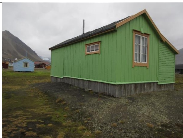
Fra nordøst. Vi ser tydelig den opprinnelige brakkas størrelse med saltak og høyere montert vannbrett under kledningen. Disse to veggene har bevart vekselpanel fra 1919.
