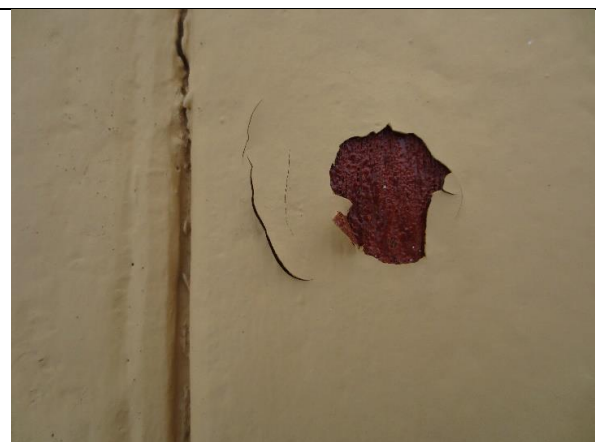
Opprinnelig kledning av pløyd staffpanel er bevart på fasadene. Bak den gule malingen ses en varm rødfarge.
