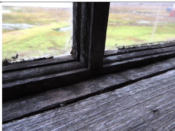
Detalj av vindu mot øst med staffprofil på ramme og sprosser.
