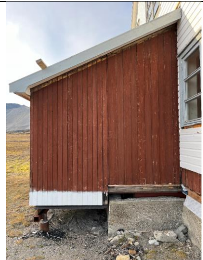
2024: Bislag øst, nordvegg etter refundamentering og avdekking av eldre kledning. Se neste side.
