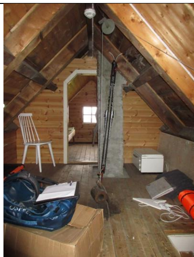
Mellomgangen på loftet er bevart med eksponert takkonstruksjon og eldre bordgulv.
