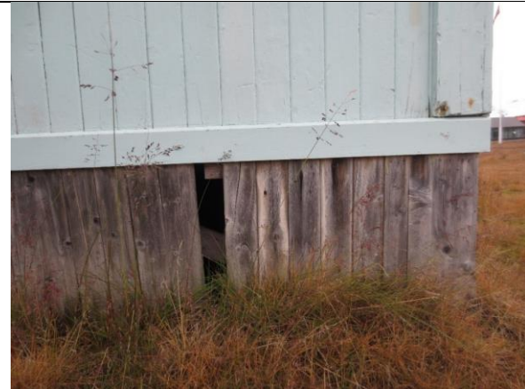
Malt kledning og umalt skjørt under bislaget.
