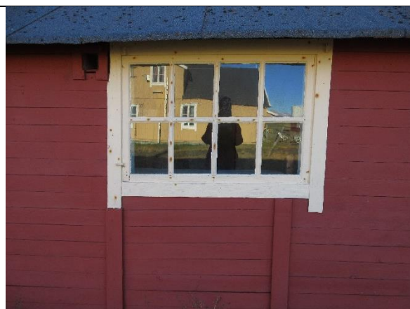
Vindu mot nord i boligdelen. Liggende kledning og to dekkbord over panelskjøter under vindu, som viser opprinnelig vindusbredde. Endret i 2. driftsperiode.
