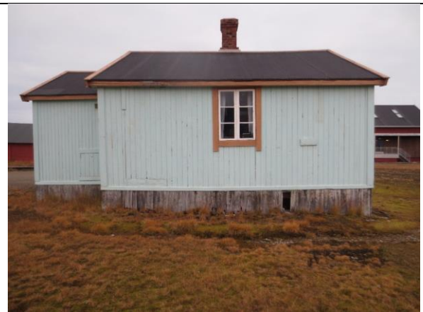
Fasade sør, med opprinnelig vindu. T.v. bislag. Skjøter i kledning i venstre del av hovedhuset har ukjent historikk.
