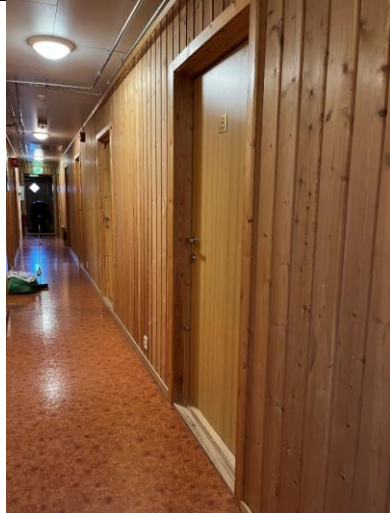
Korridor i nordfløyen. Strukturen er som i 1945, men overflatene er fornyet. Pløyd skyggepanel, antatt fra 1998.
