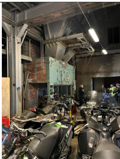
Kraftstasjonen fra 1957 har kraftige stålkonstruksjoner med søyler og dragere.
