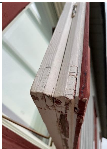
De opprinnelige koblede rammene er sammenføyd med sliss og tapp i hjørnene.
