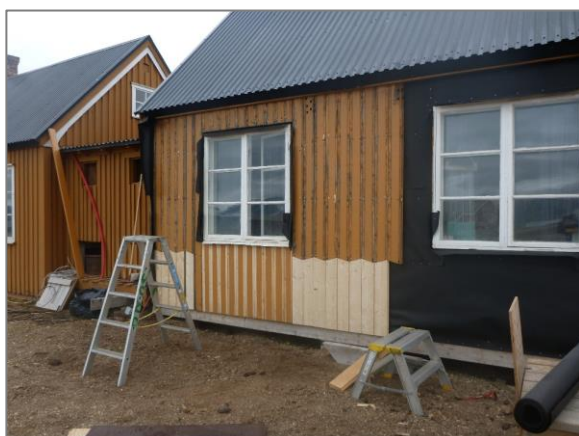
Under istandsetting 2012, med ny vindpapp og utbedret kledning. Foto: Y. Wennevold, Kings Bay
