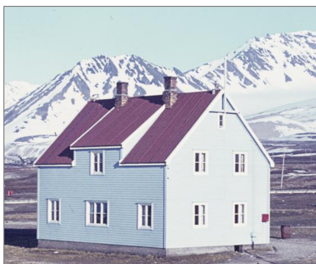
Etter modernisering: ny liggende kledning malt lys isblå, vindusrammer med to ruter, rød takpapp. Kilde: Svalbard museum, SVN-F17591 (utsnitt)
