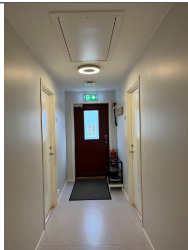
Mot inngangsdør vest i korridor. Luke til loft i himling.
