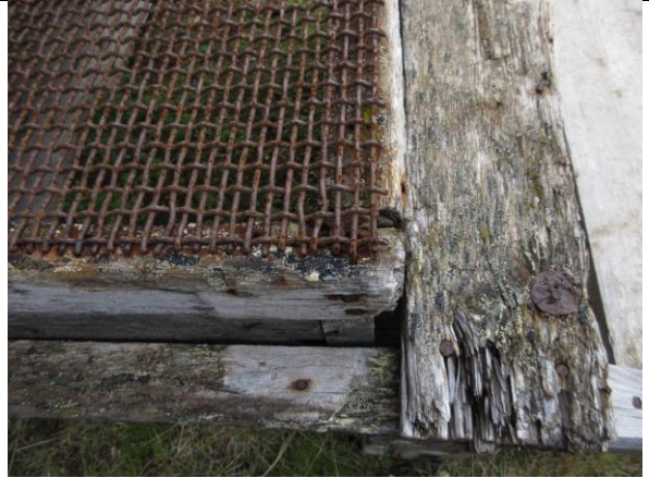
Detalj av repos med skoskraperist. Denne lokale varianten av flettet ståltråd må bevares, som et sjeldent minne fra 2. driftsperiode.
