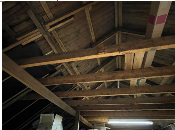
Takkonstruksjon over nordre del. Nedre del av takflata er kledd med nyere sort papp.
