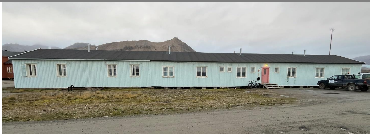
Fasade mot nord. Tilbygget del fra 1949, kalt Ny Mexico, utgjør venstre del (med fire høyere vinduer). Begge byggetrinn er bevart med opprinnelig kledning og vinduer, kun mindre endringer er utført i fasaden.
