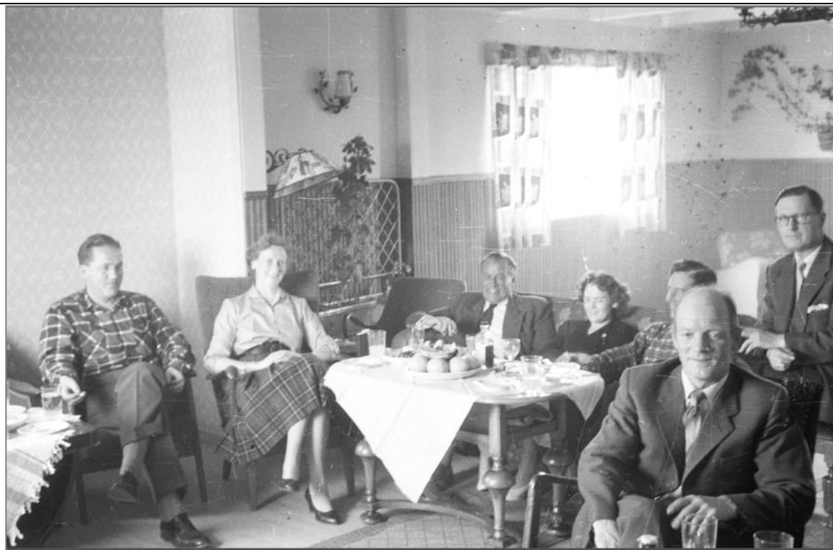
Salongen på hotellet 1960–62, med tidstypisk rillepanel på brystningen og tapet på veggene. Brystningen er fortsatt bevart, liksom det eksponerte bjelkelaget i himlingen og lampetten på vegg (ny plassering). Foto: Elna Stiens samling, Svalbard museum SVF 22415
