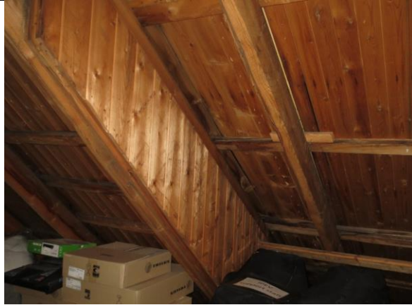
Sideveggene i takoppløftene har opprinnelig faspanel inn mot loftsrommet.
