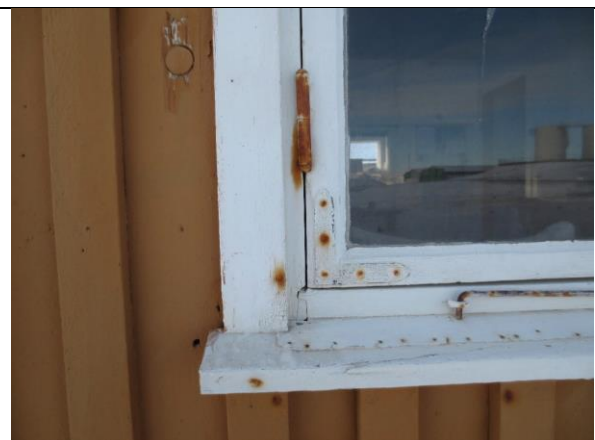
Hjørnejern med spisse ender og hengsler er av en type som var vanlig fra 1930-åra og senere, jf. bildet t.v. Satt inn her i 1950-åra.
