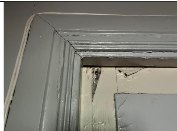
Opprinnelig døråpning fra kjøkken mot bislag har rikt profilerte geriker, antatt fra 1918. Senere utskiftet dørblad er litt mindre, med påføring i karm.
