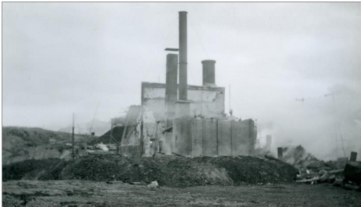
Under brannen i august 1948. På bildet ser vi nedre del av en betongvegg, som enten er en rest fra den første kraftstasjonen fra 1928, eller ble støpt i 1945 (?). Foto: Arne Brøgger. Svalbard museum, SVF 00658
