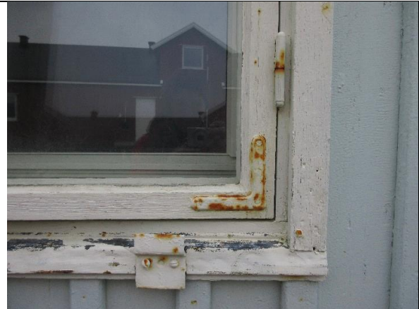
Formpressete hjørnejern av svensk type anno 1945. Tidstypiske hengsler med en liten markering av tuppen. På vannbrettet er et beslag for tidligere vinduslem.
