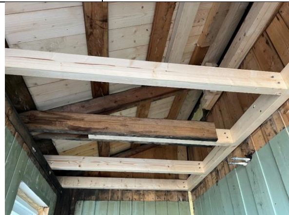
2024: Tak over bislag nord, med reparasjoner og ny taktro.
