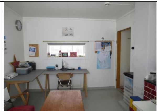
Stua sett mot sør. Gamle huntonittplater og tapet ligger bak.
