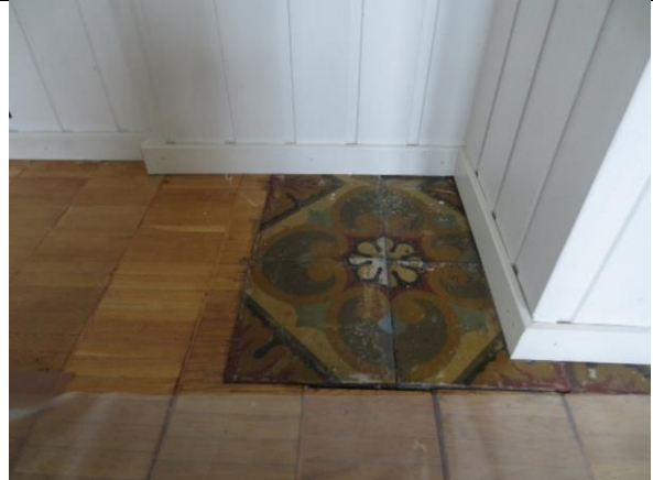
2023: Detalj av gulv mot pipestokk i oppholdsrom vest i 1. etasje, med rester av keramisk flis og parkett.
