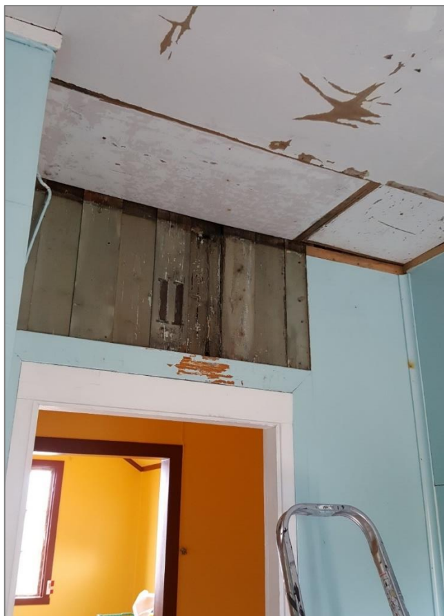
Under istandsettingen i 2018–19 avdekkes vekselpanel på opprinnelig yttervegg mot sør anno 1919. Veggene er malt grågrønn med skilt nr. 11, opprinnelig fasade i 1919. Skiltet er av samme type som bevart nr. 4 på dagens nr. 3 Green Harbour, gamle foto bekrefter at tilsvarende skilt (hus. nr. 18) var i bruk de første årene i leiren. Foto: Arild Lyssand, Kings Bay AS
