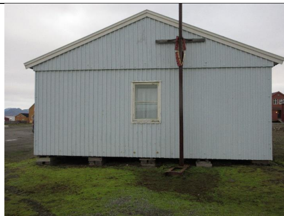
Kortvegg mot vest, opprinnelig brakke fra 1945. Bevart opprinnelig lektepanel og ettfags vindu mot korridor.
