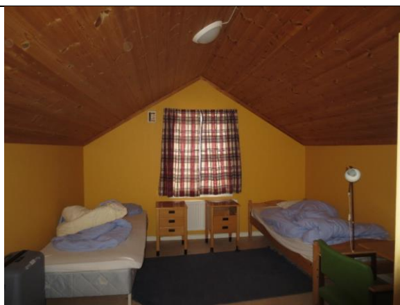
Typisk interiør i soverom på loftet. Nyere materialbruk, platekledde vegger og umalt skyggepanel i himling.
