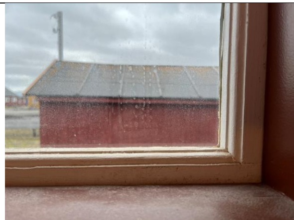
Detalj av stuevindu mot øst, jf. foto t.v. Staffprofil på ramme.
