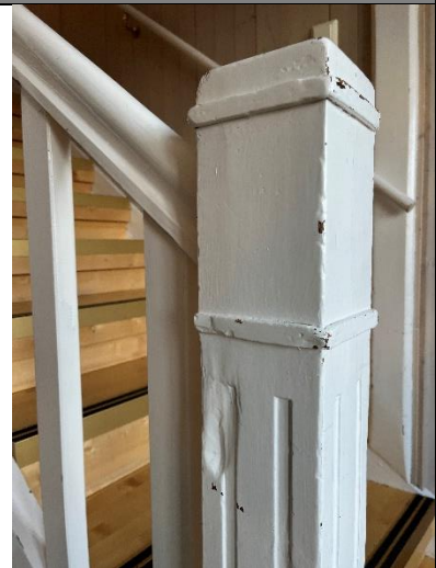
Trappa fra 1919 har preg av jugendstil, med utfreste riller på siden av firkantet meglar.
