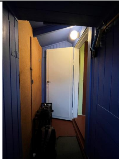
Gangen sett mot nord. T.h. kjøkkendør med ensidig påslått huntonittplate.
