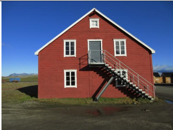
Fasade sør. Fem opprinnelige vinduer, blendet dør 1. etasje. Opprinnelig port til loftet, ny rømningstrapp.
