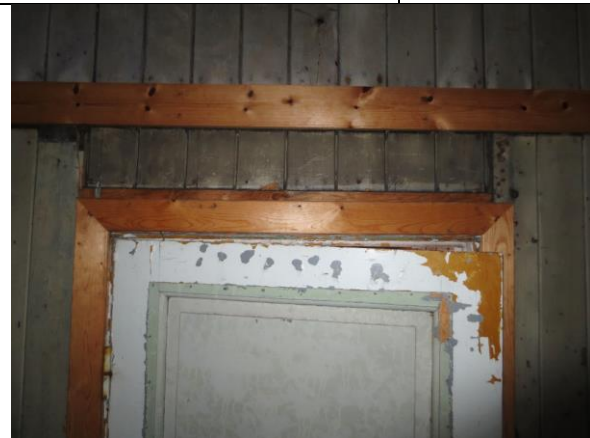
Fra hovedrommet over dør til bislag. Over døra skimtes en opprinnelige og litt smalere karm. Åtte mørkere panelbord ses over opprinnelig dørbredde.
