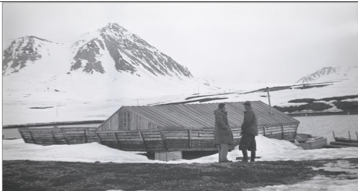
Foto 1949 viser at den ene kullprammen har fått overbygg. Sleve prammen har betydelig nedbøyning, jf. dagens setninger. Den andre prammen ligger stadig på stedet. Tilbygg mot øst og søndre naust er ennå ikke oppført. Her ser vi opprinnelig vindu i østre gavlvegg: to rammer med tre ruter i høyden. Foto: ukjent, Svalbard museum, SVF 21119
