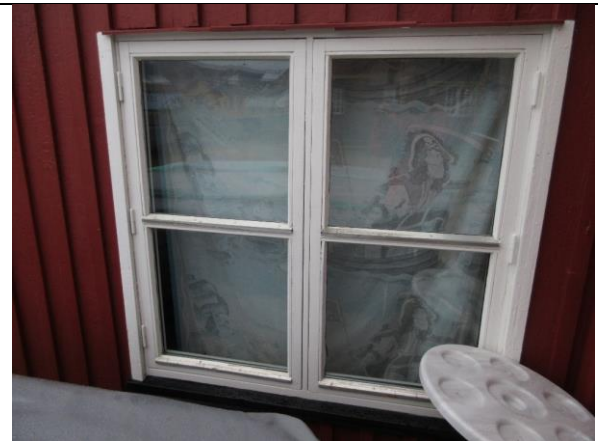
Ett bevart isolerglassvindu fra 1998 i kortvegg sør.
