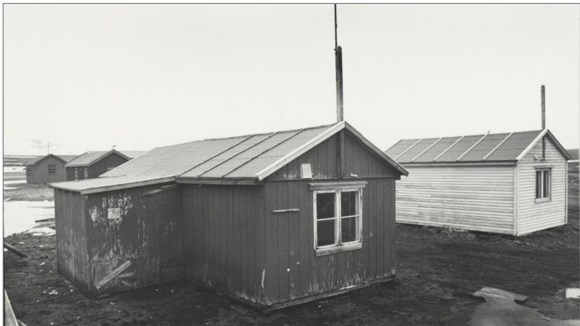
Udatert bilde med det gamle tilbygget/bislaget mot øst, før dette ble fornyet i 1993. Tilbyggets tak har synlige sperreender, og det er luke for dotømming i nedre del av veggen. Kilde: Svalbardposten, Nasjonalbiblioteket.no
