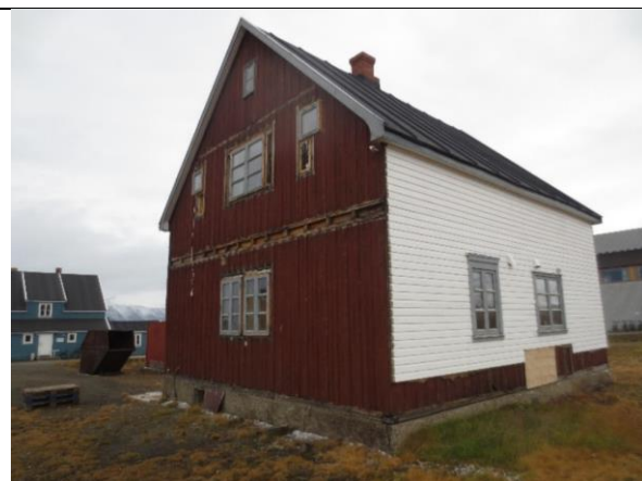
Fra sørvest, vi ser de to lagene med kledning fra henholdsvis 1919 (rød vekselpanel) og 1959 (hvit liggende panel).
