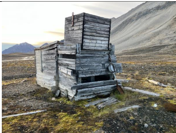
Luftesjakt og varmetue fra nordvest.
