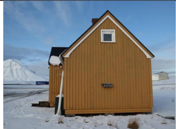
Fasade øst. Nyere vindustype i gavl. Vindskiene har en liten svai i nedre del, en typisk detalj fra etterkrigstida i Ny-Ålesund.
