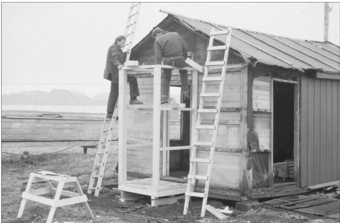
Under restaurering i 1987. Nytt bislag under oppføring, med noe avvikende/mindre dimensjon sammenlignet med 1918-versjonen. Eldre åpning mot øst er fjernet. Vi ser den opprinnelig lemkonstruksjonen, med elementer i full vegghøyde, ytre ramme, to losholter og tre felt fylt med liggende bord. Foto: Per Kyrre Reymert, Svalbard museum SVF 23593
