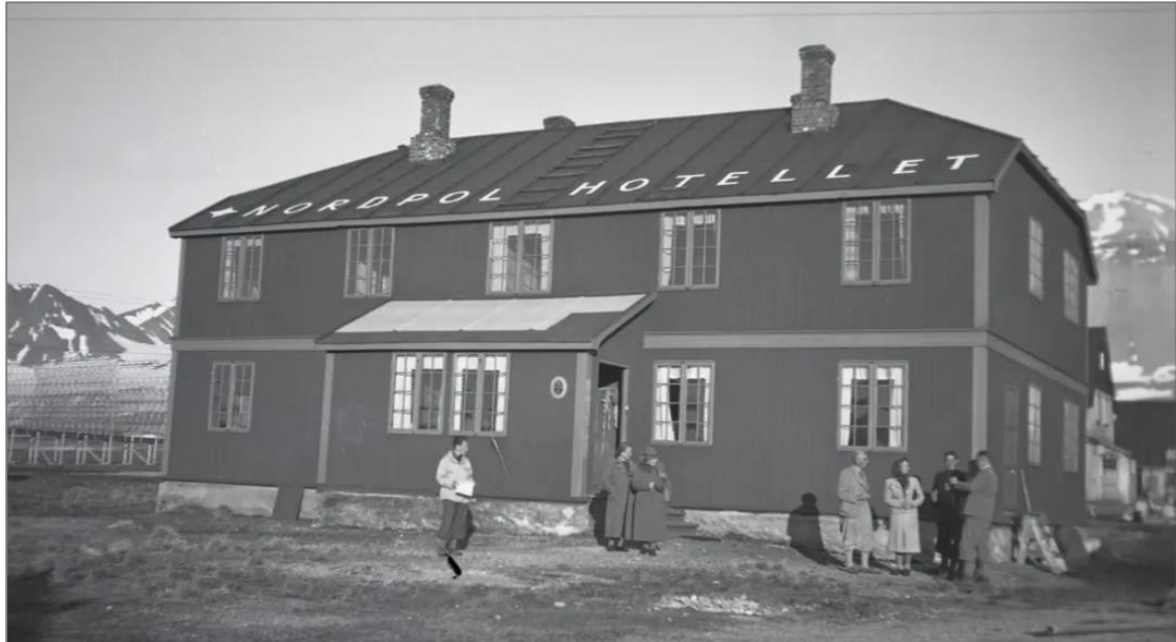
Hotellet i 1949, eksteriøret er uendret siden byggeåret 1919, unntatt skiltet, som ble malt på taket på slutten av 1930-tallet (tilnærmet samme utseende). Pappen ble fornyet og taket reparert etter krigsskadene. Inngangspartiet minner om dagens, men med dør mot vest (nå mot øst). Foto: Svalbard museum SVF 21133
