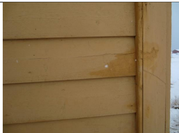
Detalj av liggende, sulagt kledning, med vertikale bord i hjørnekassene.
