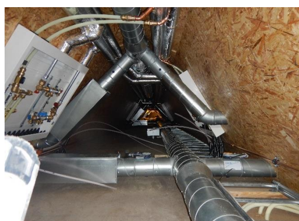
T.v. Under bygging av ny korridorvegg med isolasjon. T.h. loftet, innvendig isolert og påslått trefiberplater, råloftet er fylt opp med tekniske installasjoner og kanalføringer. Foto: Kings Bay AS 2017
