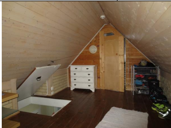
Midtsonen i loftet, med luke til stige. Nyere innredning. Dør inn til vestre rom. Opprinnelig tregulv av pløyde bord.
