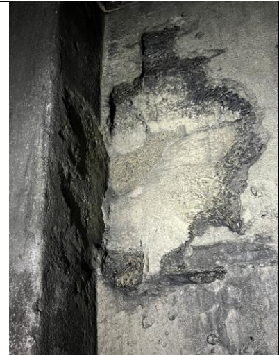
Innside av betongvegg fra 1949, isolert med tresonittplate og puss.
