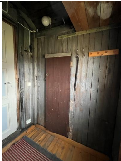
Østvegg i bislag, opprinnelig faspanel med sekundær døråpning inn til bod.
