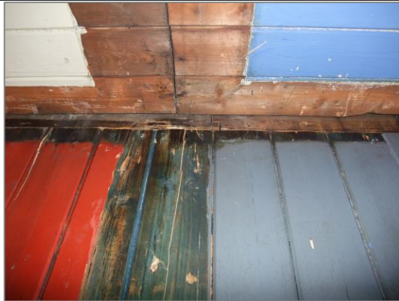
Spør etter opprinnelige skillevegger og listverk avdekkes i 1. etasje. Opprinnelig blålig impregnering/grunning på faspanel vegg.
