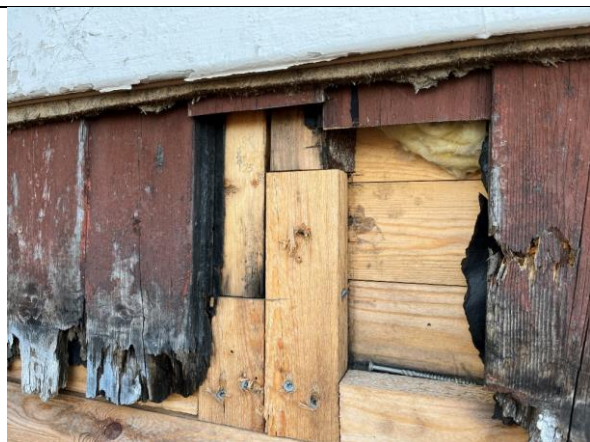
2024: Reparasjon av råteskader i nedre del av vegg. Avdekkete prefabrikkerte lemmer, der nedre del av råtne stendere er skjøtt.
