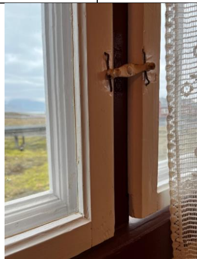
Detalj av vindu mot nord. Ytre ramme er profilert med staff/hulkil, typisk for perioden omkring 1919 i Ny-Ålesund.
