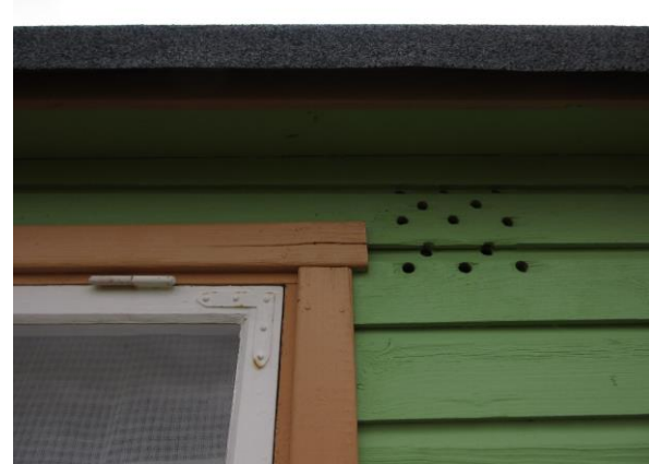
Soveromsvindu mot vest (nordre rom), tidstypiske beslag. Borete hull for ventil i kledningen, typisk løsning som finnes på flere hus i leiren. Liggende dobbelfalset kledning og vindu fra 2. driftsperiode.
