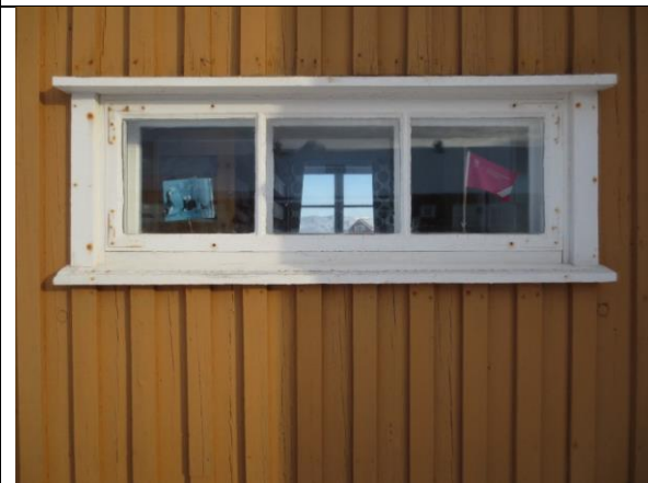
Typisk vindu mot sør, originalt fra 1950-tallet.
