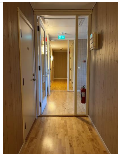
Midtgangen i 2. etasje har fått nye kledninger og dører.
