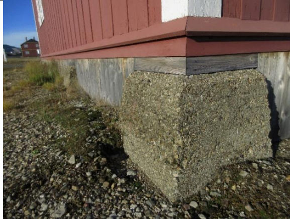
Opprinnelige betongfundamenter fra 1918. Spor etter liggende forskalingsbord og noe forvitret sementoverflate med avdekket tilslag.
