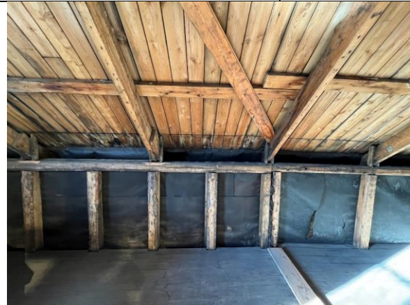
Kneveggen mot vest. Enkelte skråavstivende bord i takflata.
