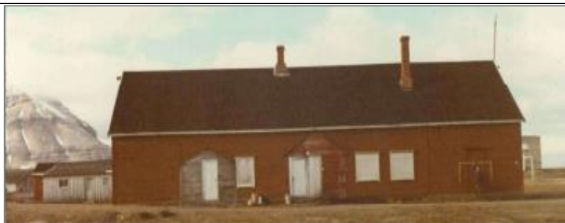
Fasade øst 1973. Spor etter riving av to bislag/tilbygg fra 1917–18, det venstre antas å være opprinnelig, mens det høyre kom kort etterpå (foran rødmalt fasade og skilt over dør), ref. Hangeraa's kart 1919. (T.h. mann med gul vinkel/målestokk.)
