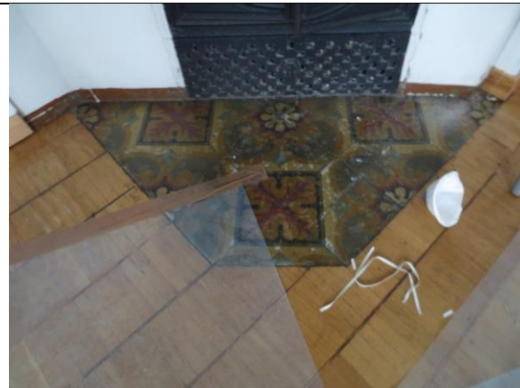
2023: Detalj av gulv foran ovn i stua, med rester av keramisk flis. Parketten er trolig fra 2. driftsperiode.
