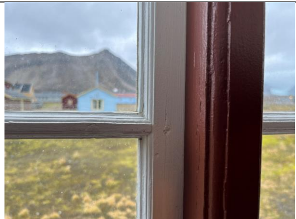
Detalj av kjøkkenvindu mot sør, staffprofil på midtpost og staff/hulkil på ramme og sprosser. Detaljene tyder på at vinduet er opprinnelig (1919–21).
