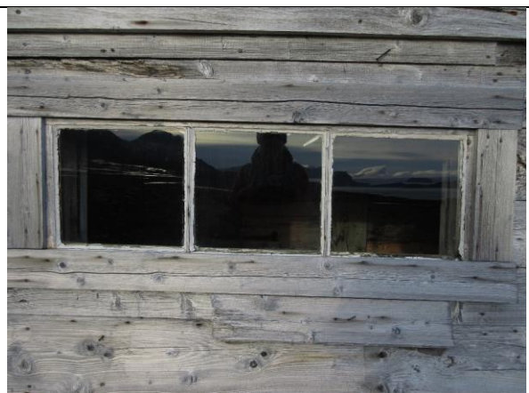
Opprinnelig vindu med tre glassruter i kittfals.
