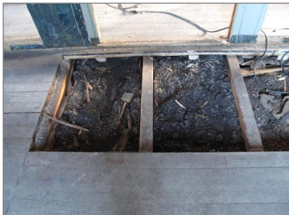
Opprinnelig isolasjon med kullsubb i stubbloftet i dekket mellom 1. og 2. etasje. Foto: Siri Hoem 2010
