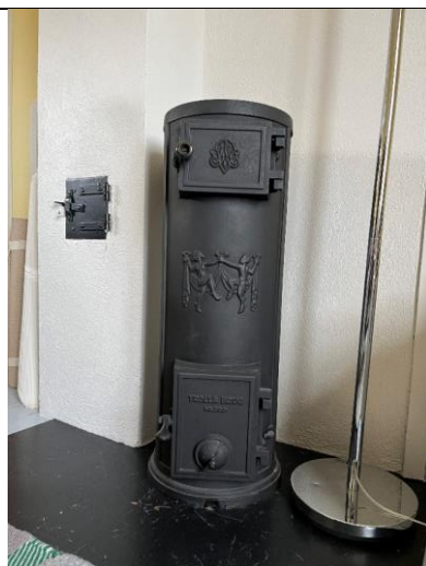
Opprinnelig pipe og jernovn i stue.
