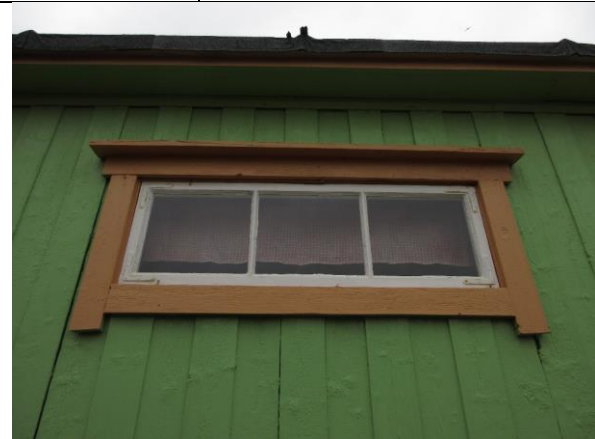
Vindu mot øst i stue, gjenbruk av liggende ramme med avrundete hjørnejern. Vinduet er av nyere dato.
