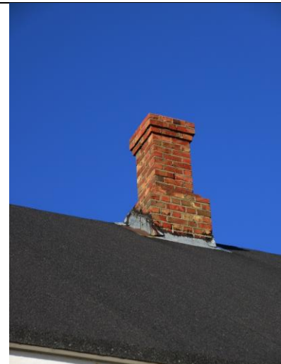
Tilsvarende lavere pipe ved mønet midt i bygningen. Det er ikke kjent om pipene er ommurt i senere tid.
