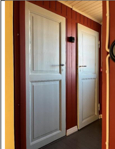
To dører til boder i bislag vest. Bevarte fyllingsdører med eldre hengsler og dørhåndtak.
