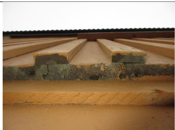
På nordveggen ligger kledningen noe forskjøvet ut i vegglivet, slik at underliggende kledning/reisverk av 2" pløyd plank blir synlig.
