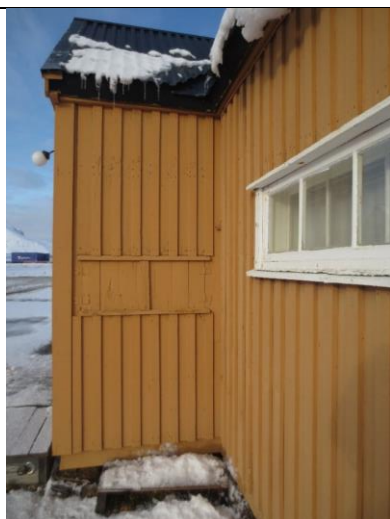
Bislagets fasade øst med opprinnelige luke til kullbinge.
