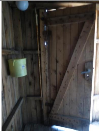
Innside dør i bislag vest, enkel labankdør fra 1950-åra. Umalt interiør.
