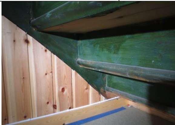
2023: Underside av hovedtrapp. Grønn grunning/beis og typisk svungen avslutning av baksida trinn. Nyere skyggepanel vegg, denne er senere fjernet.
