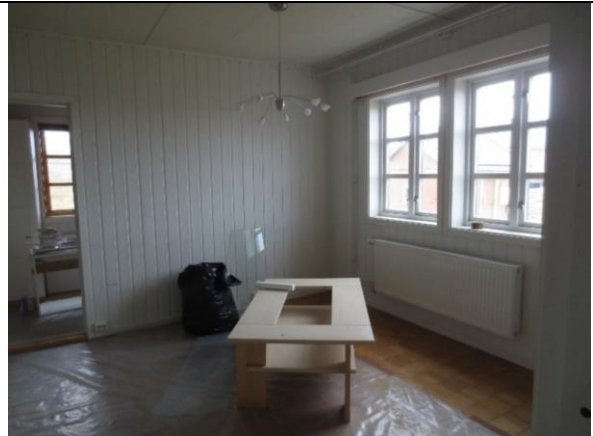
2023: Oppholdsrom 1. etasje, med parstilte vinduer mot vest.
