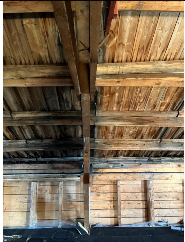
Midt under et sperrebind, med todelt hanebjelke. Liggende rupanel på kneveggen.
