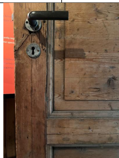
Detalj av døra vist t.v. Dørhåndtaket er typisk for 2. driftsperiode, men dørbildet er trolig eldre, eventuelt gjenbruk.
