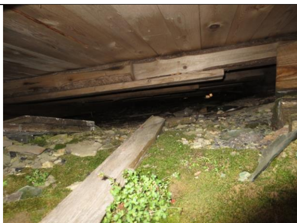
Under gulvet i vestre bygningsvolum, et parti med god lufting.
