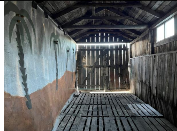
Interiør i tilbygget naust mot sør, sett mot glissen port i vest. Lerretet med palmemotiver er fra fester tidlig på 2000-tallet.
