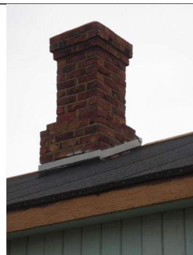
Fint murt pipe med pøsefuger (dratt med bueformet jern). Antatt opprinnelig utførelse typisk for 1920-åra, men sjelden i leiren.
