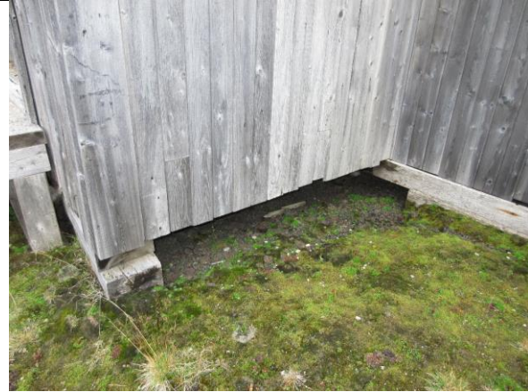
Klossfundamenter under søndre bislag. Faspanel på vegg.
