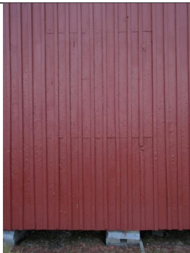
Blendet vindu i vestvegg mot salen, der panelskjøten er synlig.
