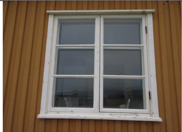
Typisk vindu mot nord, med en fast og en sidehengslet ramme.
