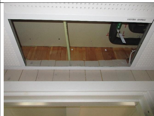
Gløtt gjennom nedfôrete himlingsplater over korridor 2. etasje. Umalt skyggepanel på vegg, muligens fra 1960-tallet (ikke dokumentert).
