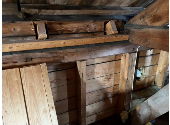
I kneveggen mot nord er sperrene fra tilbygget oppført i 1992 anlagt på raftstokken.
