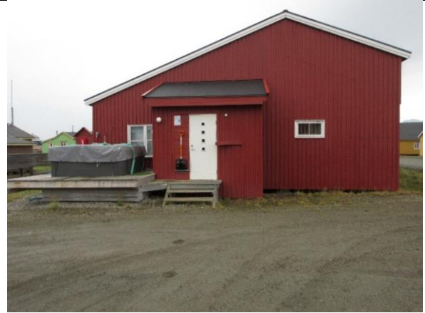
Fasade sør, med nyere bislag. Tilbygg mot vest og påbygg i 1962 kan tydelig leses i fasaden. Spor i kledningen etter opprinnelig saltak ses på stedet.
