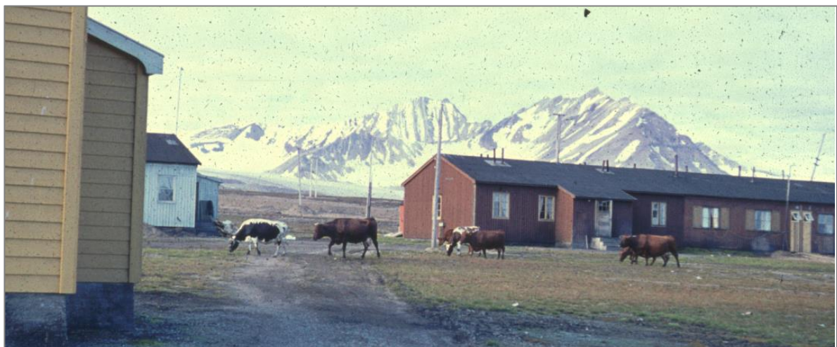
Mexico 1956–59, med rødbrune fasader, gulmalte vinduer og gråsort takpapp. Ny Mexico til venstre. Det er et fargeskille mellom byggetrinnene, og tilbygget har høyere vinduer uten lemmer. To små baderomsvinduer er nylig etablert, med umalt kledning under. Kilde: Hans H. Hagens fotosamling, Kings Bays arkiv (beskåret)
