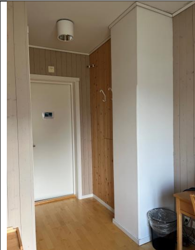
I enkelte rom går opprinnelig pipestokk gjennom rommet, pusset og malt.
