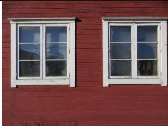
To vinduer mot øst, tilnærmet kopi av de opprinnelige.
