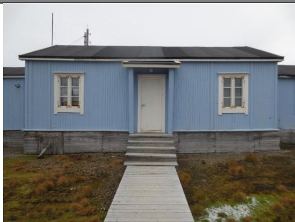
Fasade nord, opprinnelig oppført som utvidelse av radistasjonen i 1929.
