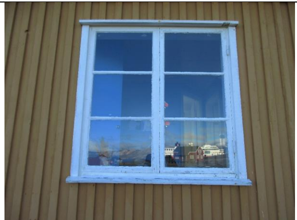
Typisk vindu mot nord, antatt opprinnelig 1950-talls med hjørnejern. Ett fast og ett sidehengslet felt.
