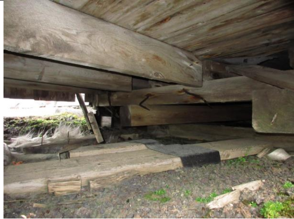
Under gulv i bislag, sett mot hovedhuset.
