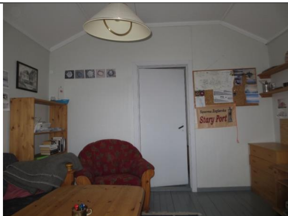
Oppholdsrom mot sør, lettvegg satt opp som del av ombyggingen i 2. driftsperiode. Opprinnelig «funkisdør» med lakkert finérplate (nå malt), håndtak av stål og bakelitt.
