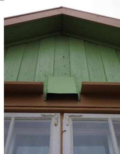
Typisk ventil med blikkoverdekning i gavl nord.
