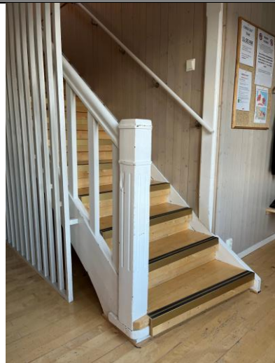
Opprinnelig trapp fra 1919. Ny parkett på trinn og ny spilevegg.
