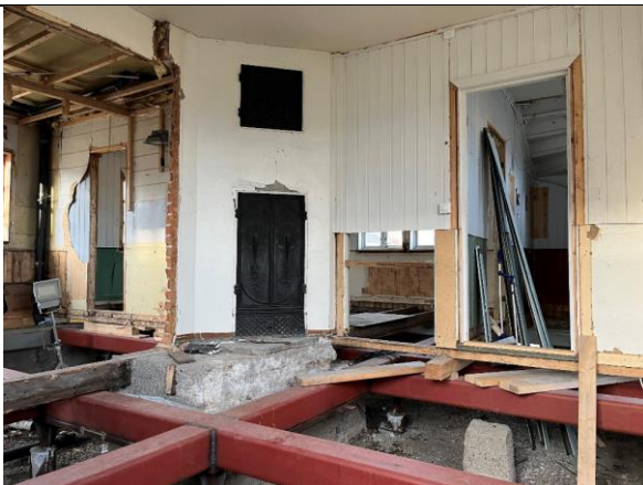
2024: Stua etter refundamentering, ny bæring av stålbjelker og stålpeleer. Opprinnelig støpt fundament under pipe og ovn er bevart. Opprinnelig gulv er saget vekk.
