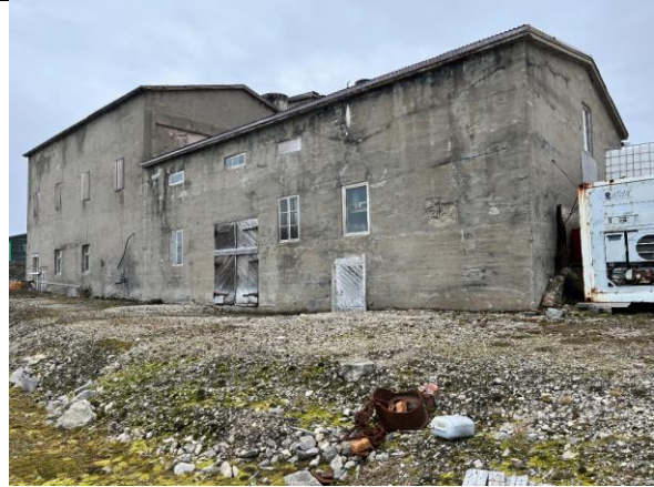
Fasade nord mot sjøen, begge bygninger er bevart omtrent som oppført i 1949, med tynn puss på fasadene.
