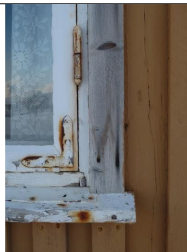
Vindusbeslag nord med spisse hjørnejern.
