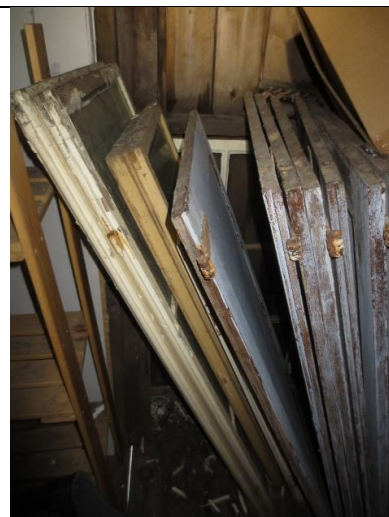
Inne i boden er det lagret et par opprinnelige vindusrammer (hver med tre ruter) og flere vinduslemmer.
