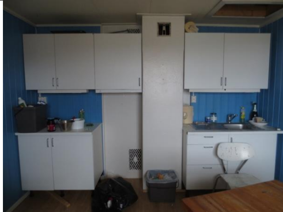
2023: Kjøkken i 2. etasje. Alle overflater og kledninger er fornyet i senere tid. Bevart pipestokk, der vi skimter ventiler både oppe og nede. De har samme ringmønster som på bildet forrige side.
