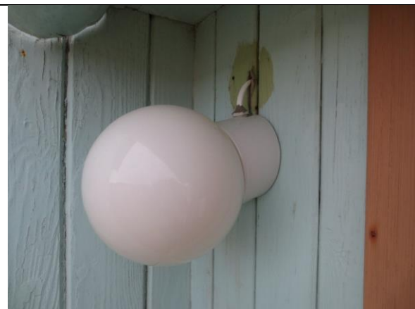
Nyere lampe ved inngangsdør bislag, med spor etter eldre lampefeste og eldre grønnmalt fasade, som også finnes under på hovedhusets vegger.
