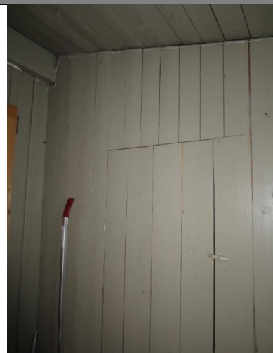
Lettvegg mot bod i bislag, labankdøra går i ett med bordveggen.
