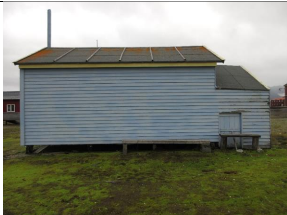
Fasade vest. I tilbygget bod er en luke for tømning av dobøtte.
