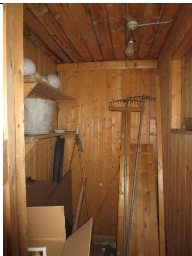
2023: Interiør opprinnelig bislag fra 1919, nordre rom. Innvendig panel er fornyet. Til høyre innside av luke til kullageret i ytterveggen fra 1919, se foto nedenfor.
