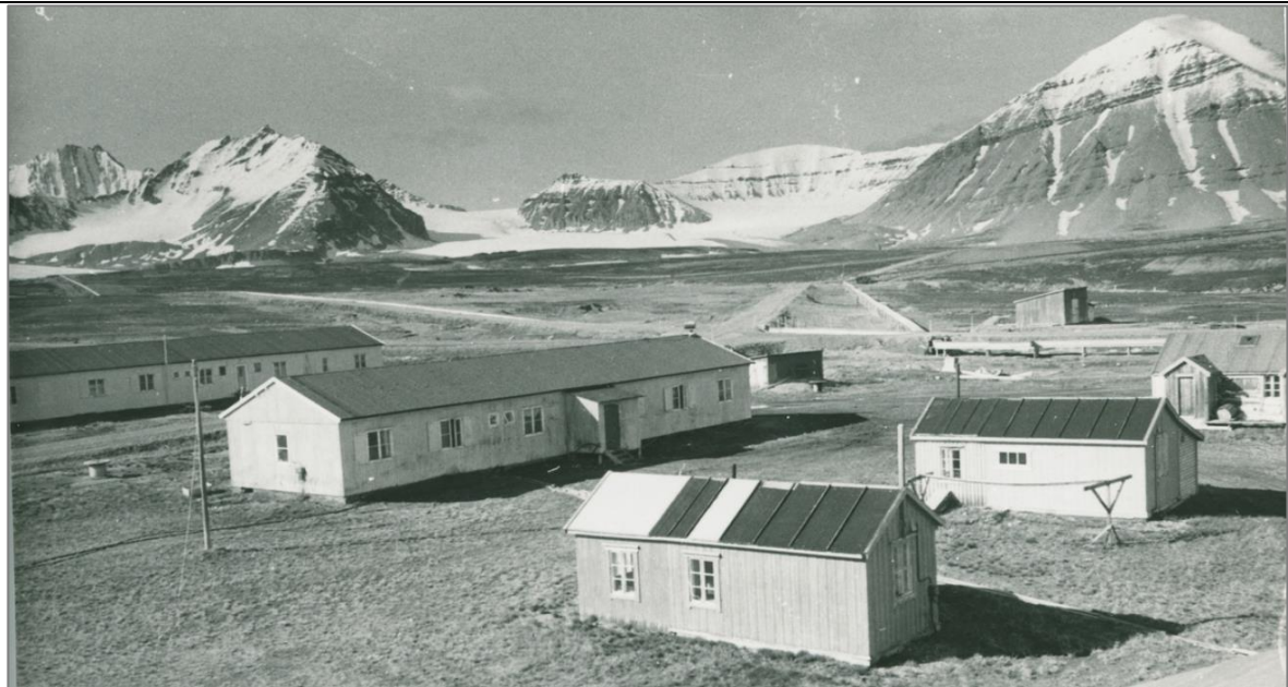
Trønderheimen midt i bildet, ca. 1960. De to små vinduene ble satt inn ca. 1958, da bad/WC ble installert. Bygningen er blitt malt i en lys farge. Kilde: NN, udatert, Svalbard museum
