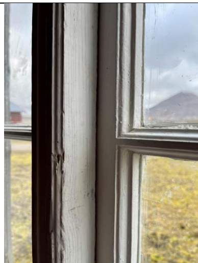
Detalj av vindu mot vest i stua, med karnissprofil.
