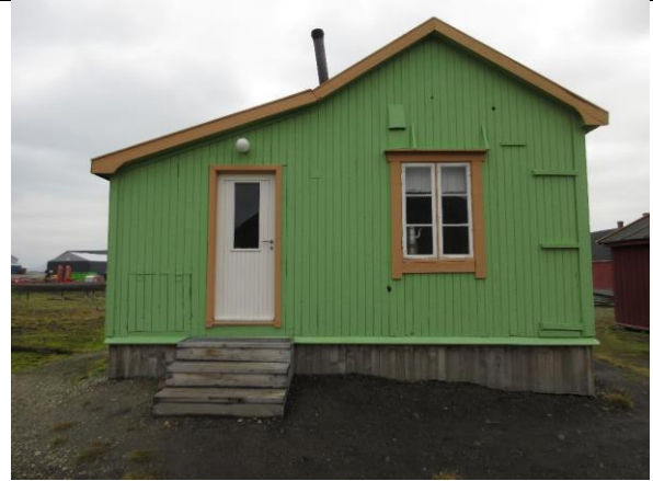
Fasade sør. Tilbygg oppført før 1921, bislag og kjøkken. I boden til venstre for døra er ei luke inn til tidligere kullbinge. På høyre side er et skistativ i form av lekter, der treski kan stikkes inn og stå i spenn.
