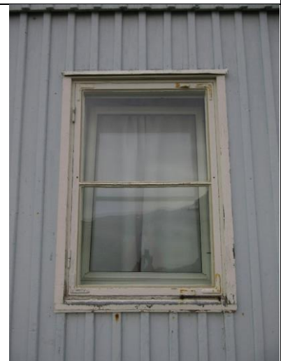
Opprinnelig vindu fra 1945 i gavlvegg vest. Ettrams vindu, ellers detaljer som øvrige vinduer i opprinnelig brakke.
