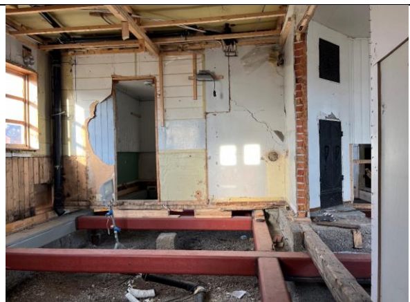
2024: Interiør i 1. etasje, rom mot sørøst, sett mot vestvegg med avdekket blåmalt faspanel. Stua med ovnen skimtes t.h.
