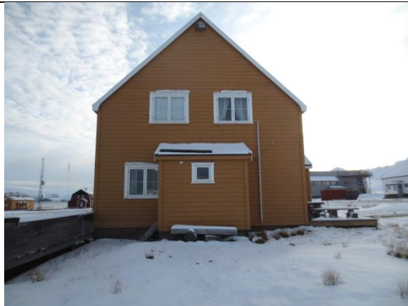
Fasade vest, intakt hovedform og bislag med pulttak. Her var det opprinnelig kullbenge.
