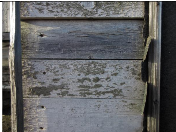
Kledningen på tilbygget mot øst er gjenbruk av forskalingsbord med rester av sement.
