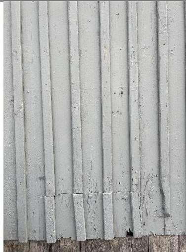
Panelfelt t.h. for dør i østveggen, der negativt spor etter dobenk er overmalt, men stadig skimtes.
