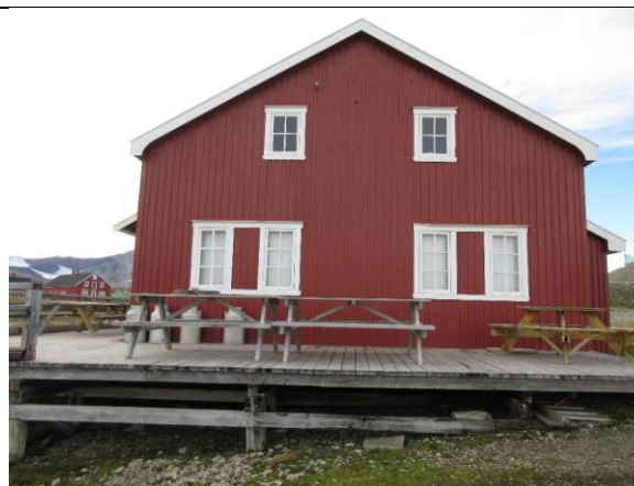
Fasade øst. Plattingen er her utvidet og fundamentert på trepeler, antatt i 2. driftsperiode. Opprinnelige vinduer er bevart i begge etasjer.
