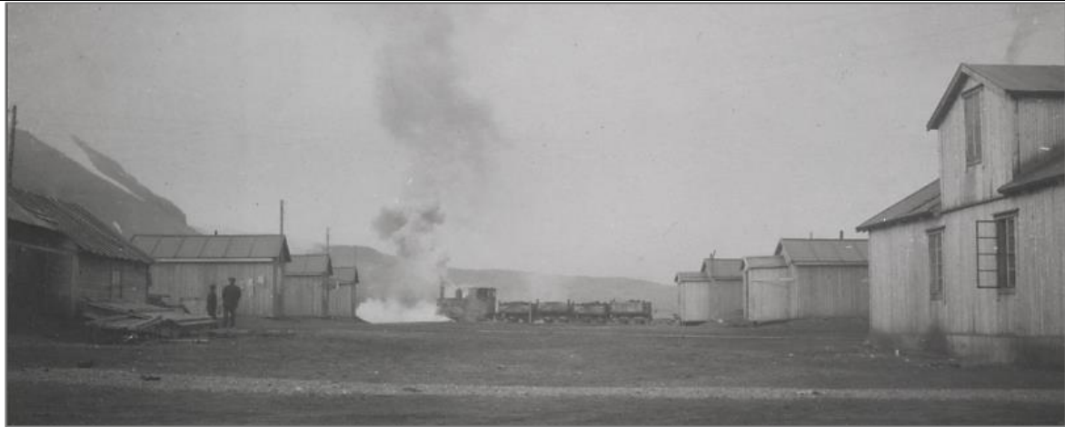
Leiren med kulltoget i 1. driftsperiode. Til høyre ses boligbrakke II, i dag nr. 2 Skolen, med opprinnelig ark på loftet og vinduer med fire brede ruter i hver ramme. Foto: Ukjent, Svalbard museum, SVF 24920.
