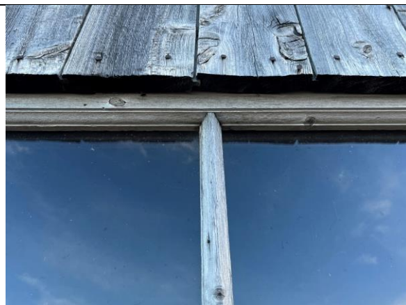
Søndre vindu i kullprammens hovedfasade, med en tilnærmet karnissprofil. Vinduet er montert med innsiden ut, nå er kittfals og hjørnejern på innsiden.
