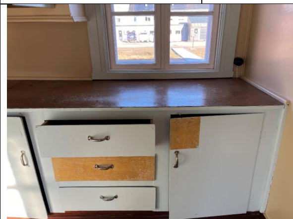
Mindre partier med overmalt ådring ble avdekket på to kjøkkenskap og en skuff under restaureringen.
