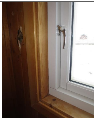
Nyere isolerglassvindu i koblet utførelse, her fra midtkorridoren. Ny karm er satt inn i den gamle. Vinduene ble skiftet i 2021.
