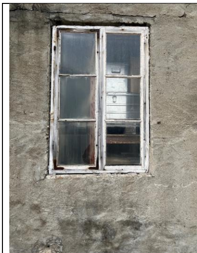
Eldre vindu mot nord, antatt fra 1949. Enkelte rammer har hjørnejern. Muligens gjenbruk.
