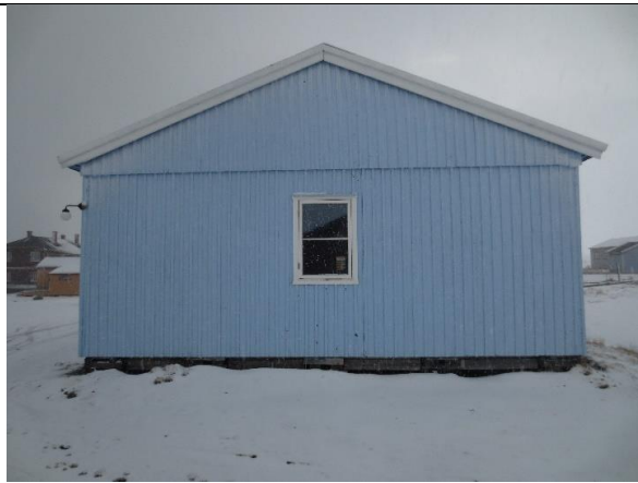
Gavlvegg mot vest, med et ettrams vindu inn til midtkorridoren.
