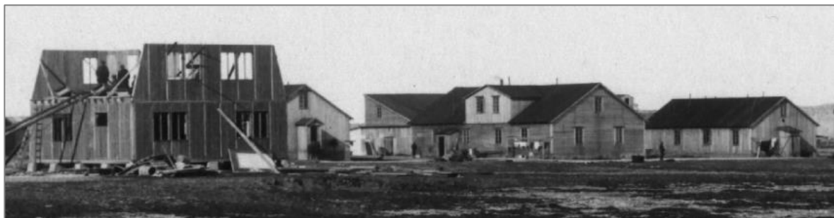
Under bygging av Amundsenvillaen sommeren 1918. Bak f.v. Brakke II (nå nr. 2 Skolen), med et lite bislag med saltak mot øst. Dernest Arbeidermessa og boligbrakke I. Foto: Norsk Polarinstittutt, np003100 (utsnitt)
