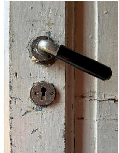
Døra er modifisert i 2. driftsperiode, med tidstypisk håndtak av stål og bakelitt.
