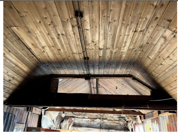
Himlingen i vestre bygning (malerboden) ligger under hanebjelkenivå. Sett mot øst og rester av revet yttervegg i lemrakka, ref. bildet t.v.
