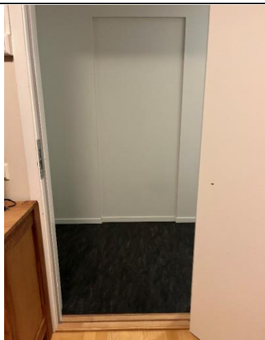
Opprinnelig blendet dør mot korridor, markert med inntrukket felt i vegglivet.
