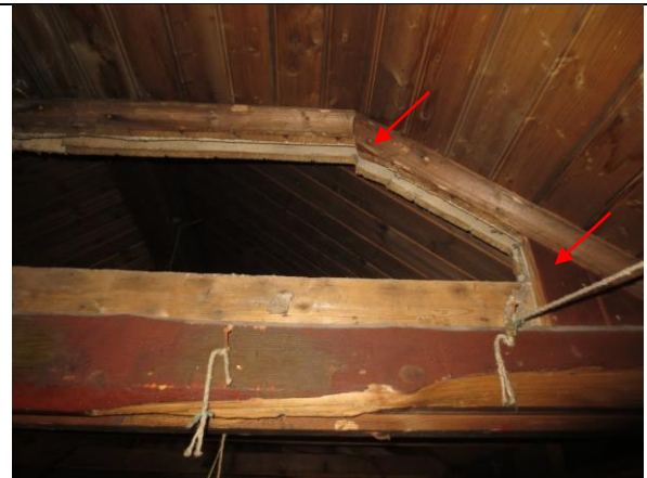
Rester av gavlvegg sett fra vest. Røde piler markerer rødmalt faspanel, opprinnelig fasade i østre hus (lemrakka) før sammenbygging.
