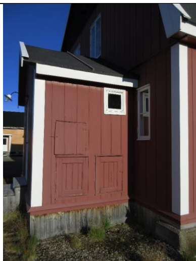
Bislaget mot vest har opprinnelige luker og et vindu i sørveggen.
