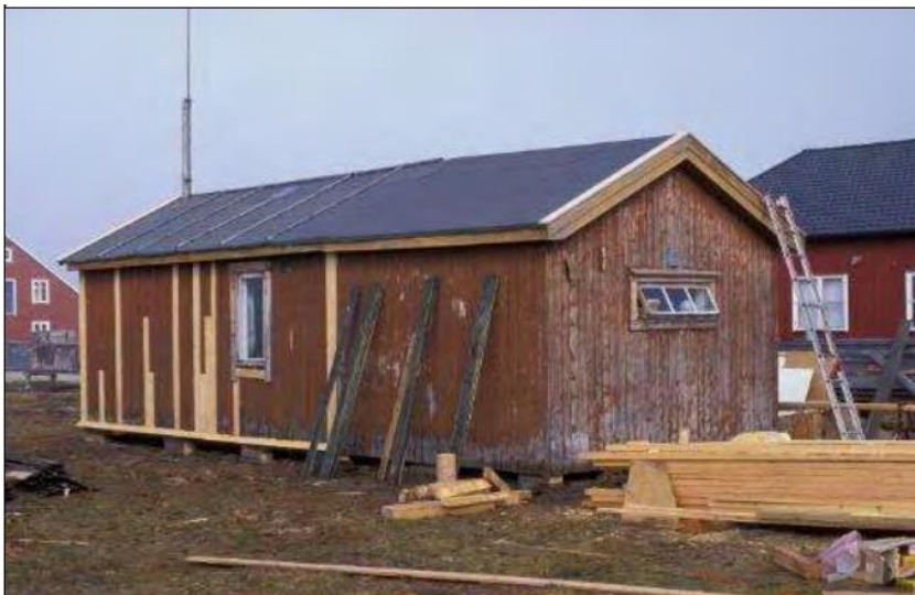
Bilde tatt av L. Roll SMS i 1993. Her er utbedringsarbeidene i gang, bygget er løftet opp og har fått nye fundamenter. Vannbrettet nederst på veggen er nytt og enkelte panelbord er skiftet. Denne delen av bygget ble nennsomt reparert og fremstår relativt urørt og autentisk i dag.
