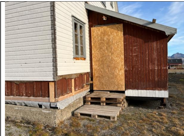
2024: Bislag øst, opprinnelig dør er tatt til verksted for restaurering.
