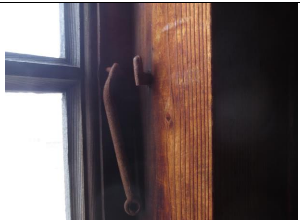
Detalj av loftsvindu. Rammer profilert med hulkil og staff, konkave sider på srossene og opprinnelig stormhaspe. Samme detaljering finnes på flere hus fra samme byggeperiode.
