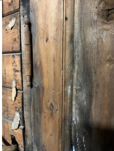
Porten mot nord (vist t.v.) har opprinnelig hengsel med konisk tupp med kule, jugenstilspreg.
