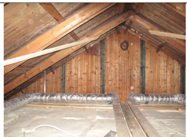
Foto fra råloftet, som ble etterisolert over etasjeskillet med cellulosefiber i 2010. Kun panelbordene som dekker over lemskjøtene i gavlveggen, har blålig impregnering/grunning. Foto: Siri Hoem 2010
