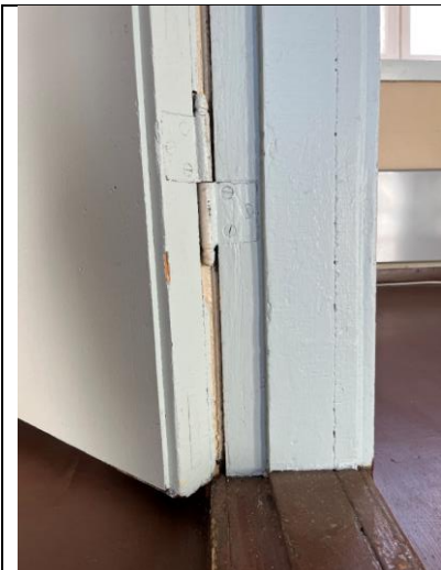
Fyllingsdør med tre fyllinger og eikenøtthengsler mellom kjøkken og bislag vest, fra 1929. Mot kjøkkenet har døra fått påslått huntonittplate, antatt i 1946.
