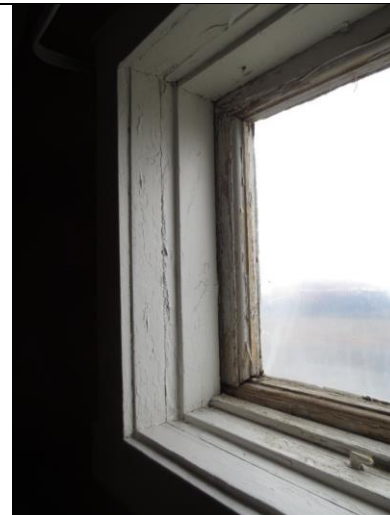
Detalj av liggende vindusramme mot øst. Staffprofil, innsatt i 2. driftsperiode. Anslag for mulig varevindu.
