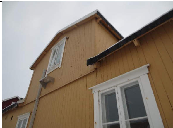
Ark mot nord etter at observasjonsplattformen fra 1966 er fjernet. Både hovedvolum og ark har knappe takutstikk med synlige sperreender/åser.
