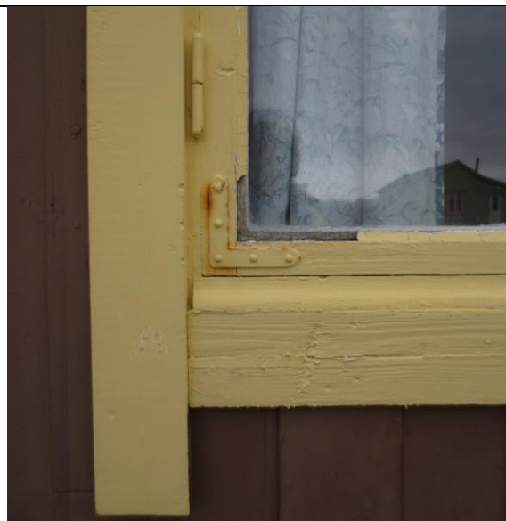
Detalj av vindu mot nord med tidstypiske beslag. Inndelingen i fire store ruter tilsier at vinduet ble skiftet ut i 2. driftsperiode. Nye sidegerikter.
