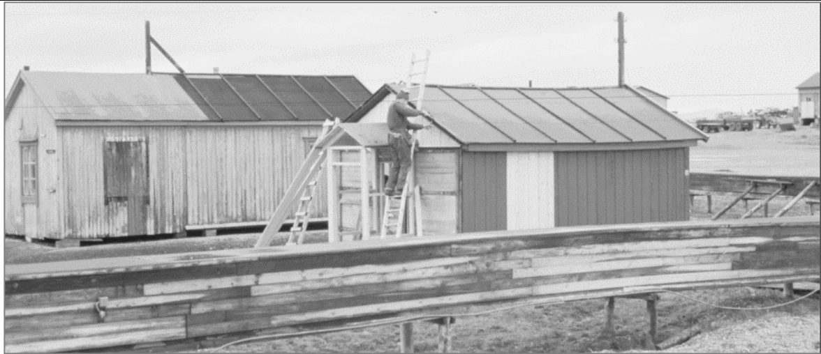
Ny vekselpanel monteres på gavlveggen. Feltet mot øst er tettet med ny panel. Til venstre er dagens 4 Museumshytta, tidligere nr. 10, som ble flyttet hit for museumsformål i 1987. Kilde: Svalbard museum
