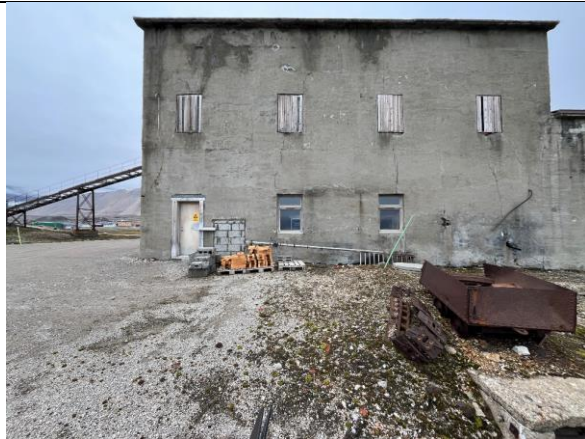
Fasade nord i kraftstasjon fra 1949. To nyere isolerglassvinduer og dør i 1. etasje, antatt satt inn i 1989–90 ved innredning av «Nansenlabben».
