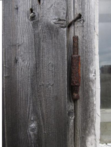
Detalj av vinduet i midtpartiet mot øst, hengsel i karm med konisk tupp/kule i jugendstil, typisk ca. 1917–19.
