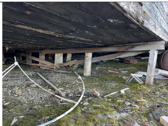
Fundament midt under kullprammen, der det er bygget en ramme av svill/stolper/dragar.
