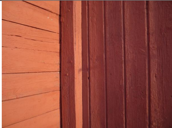
To typer kledning på bygningsvolumene, indre hjørne mot sør. Den gamle lemrakka til høyre.
