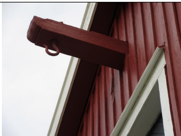
Over porten til loft i gavl mot sørvest er en opprinnelig bjelke for løfteanordning av varer inn til lagerloftet.
