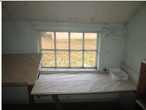
Vinduet mot nord i boligdel. Dette er fast og kan ikke åpnes. Vinduet fikk denne utførelsen, med økt bredde, ved ominnredning av boligdelen i 2. driftsperiode.
