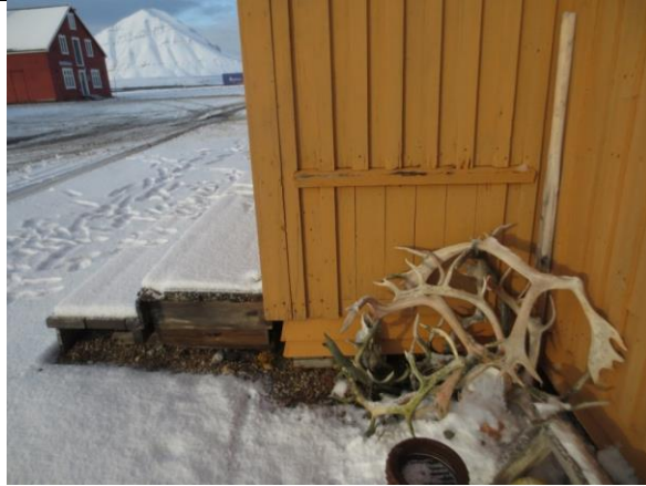
I bislagets østvegg er en tettet luke, opprinnelig luke til kullbod og tømning av dobøtte.
