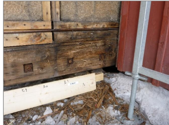
Isolasjon med trefiberplater på kjøkkenfløyen. Antatt opprinnelig løsning fra 1945, med prefabrikkerte elementer inndelt med losholter og fylt med trefiberplater.
