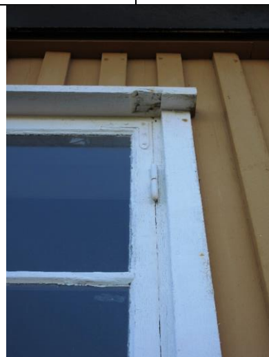
Detalj av vindu mot nord. Utsparing i vannbrett over vindu for å kunne løfte av sidehengslet ramme.
