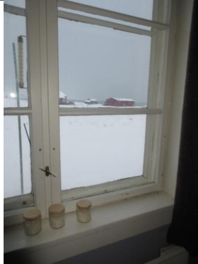
1950-talls vindu med varevindu mot nord.
