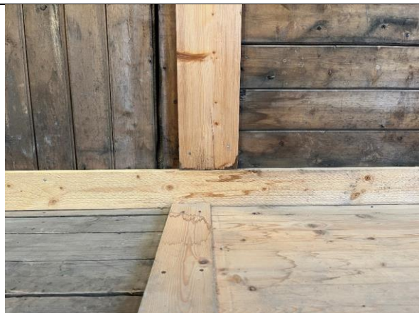
Utsnitt av gulv og vegg i 1. etasje i museumsdelen, overgang mellom to byggetrinn. Stående staffpanel på vegg i eldste del, liggende faspanel på tilbygget fra 1919 t.h. Senere fornyet gulv.
