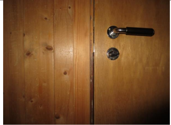
Detalj av finérdør med bakelitthåndtak og vekselpanel med buet kant i gangen (bislaget), på vegg mot øst/teknisk rom. Panel og dørdetaljer er typisk etterkrigstid.
