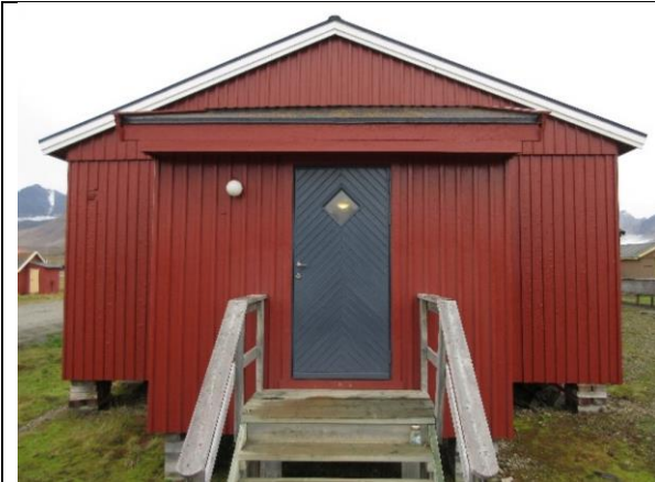
Fasade nord. Bislaget er trolig fra 1998, noe høyere og bredere enn opprinnelig bislag. Taket er tekket med papp.
