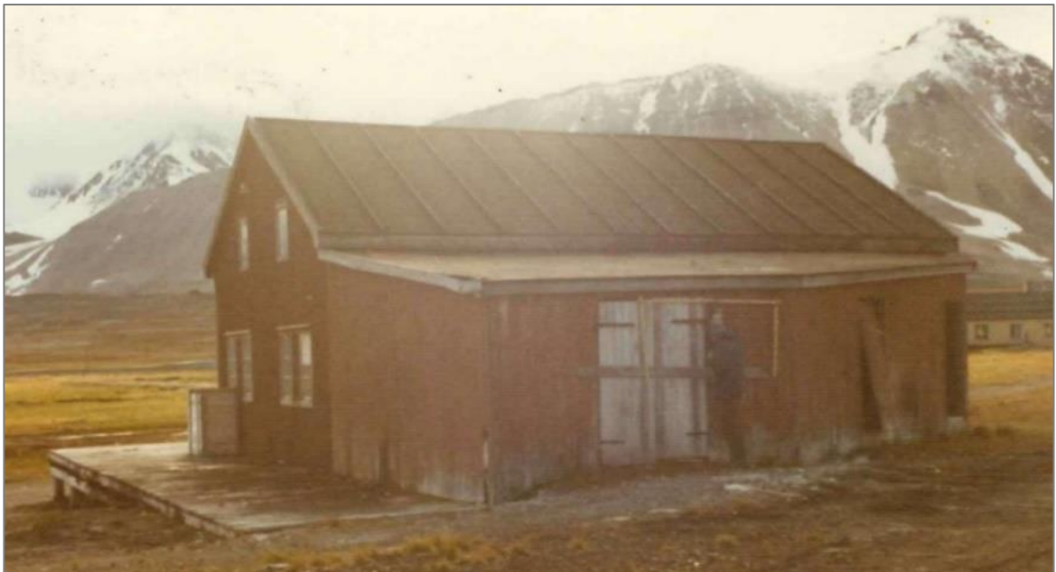
To bilder fra 1973. Plattingen ligger fortsatt i opprinnelig nivå, med bjelken rett på de støpte pilarene. Både skyveporten og porten til loftet er rødmalt. Tilbygget mot nord ble oppført ca. 1935. Treplattingen er utvidet mot øst, med trepeler under. Kilde: Reinertsen m.fl. 1973, Kings Bays arkiv
