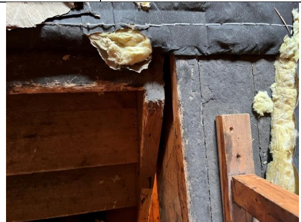
På loftsgulvet er det lagt ut isolasjonsmatten. Opprinnelig bordgulv er synlig ved trappa, med en trærelignende overflatebehandling.
