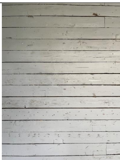
Opprinnelig kjøkkengulv, malt. Det er spikersømmer etter eldre gulvbelegg.
