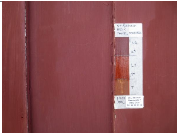
Opprinnelig vekselpanel fra 1918 er bevart på store deler av hovedhuset. Jon Brønnes fargertrapp fra 2023 viser kun rødfarger i få lag.
