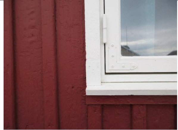
De nye vinduene er utformet med forbilde i opprinnelige vinduer i svenskebrakkene fra 1945. Hengsler og hjørnejern avviker fra originalen.
