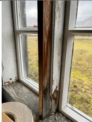
Vinduet mot nord har bevart én ramme med en sjelden karnissprofil. Profilert midtpost er skjult.
