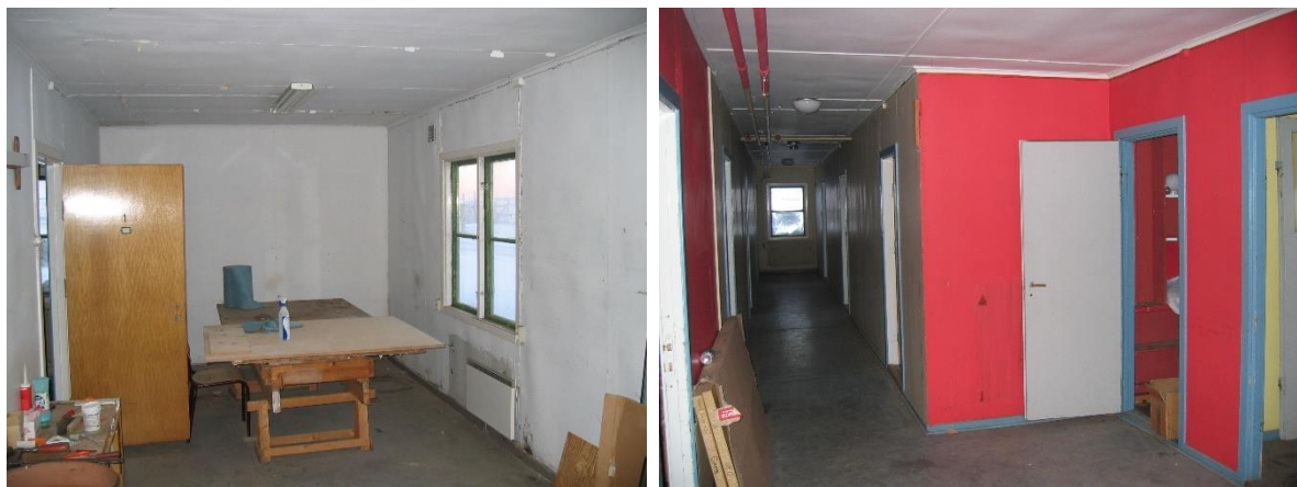
Typisk interiør i boligrom og korridor, før siste modernisering. Opprinnelige fiérdører var bevart, og alle flater kledd med malte plater. Foto: Kings Bay AS 2003
