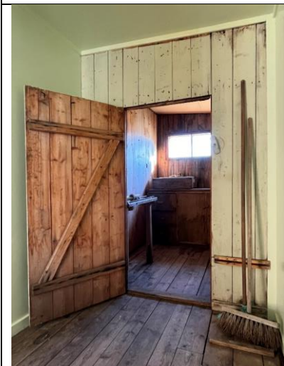
Inne i tilbygg sør fra 1946, samme rom som vist over t.h. Opprinnelig labankdør i lettvegg til bod mot øst.
