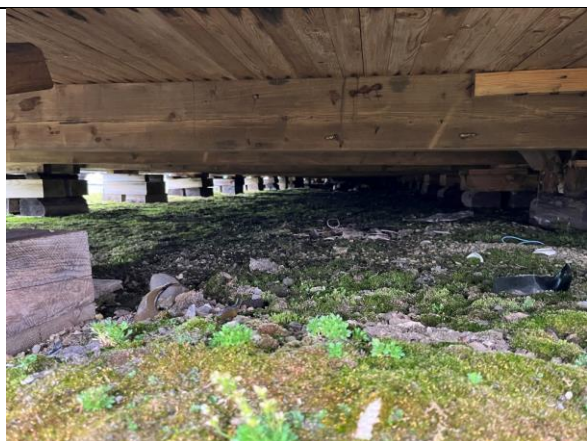
Det er god lufting under gulvbjelkelaget, her opprinnelig del med fundamenter av krysslagt boks. Isolering av dekket er gjort på oversida av bordgulvet.
