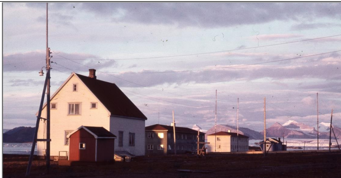
1958–60. Hvitt hus med ny kledning og vinduer. Dukkestua har opprinnelig rødmalt kledning. Den tilsynelatende rosa belistningen skyldes solnedgangslýset, et annet foto tatt samtidig bekrefter gråblå belistning, jf. fysisk funn i fargeundersøkelse 2023. Foto: Kjell Olav Hansen, Svalbard museum (beskåret)
