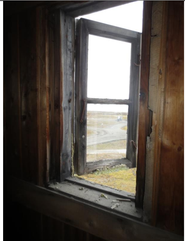
Opprinnelig vindu i vestre gavl.
