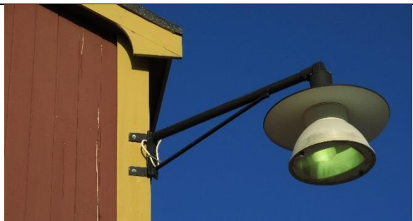
En stor lykt oppe på hjørne nordøst gir lys til gata og plassen utenfor hotellet. Montert i nyere tid.
