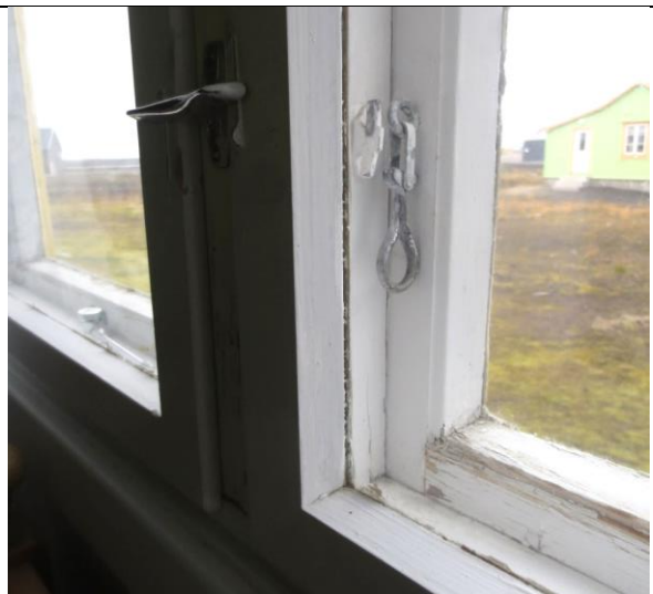
Detalj av vindu mot nord, ytre ramme ble fornyet i 2. driftsperiode. Noe nyere varevindu.
