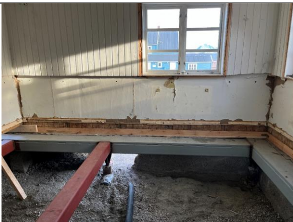
2024: Stue nordvegg. Refundamentert på stålpeleer og stålbjelker.
