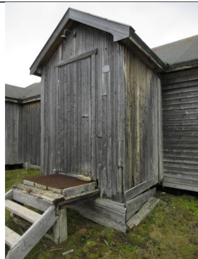
Nordre bislag. Opprinnelig repos med rist av flettet ståltråd fra 2. driftsperiode. Dør og trapp fra 1992.
