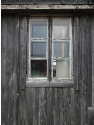
Vindu mot øst, med avdekket opprinnelig faspanel på vegg. Alderdommelig rammetype med innvendig karnissprofil.
