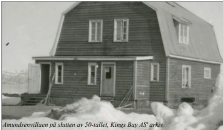
Villaen sent på 1950-tallet etter ombygging til to familieboliger, med ny liggende kledning, takopplett mot sør og to separate inngangsdører i tilbygget mot vest. Kilde: Kings Bays arkiv
