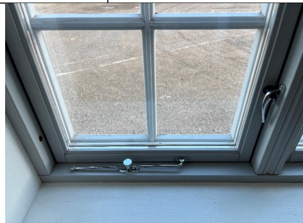
Typisk koblet vindu fra 1998, med isolerglass i indre ramme.
