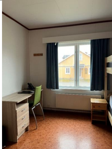
Typisk interiør i utleiehybel. Nyere malte plater på vegg og himling, vinylbelegg på gulv.
