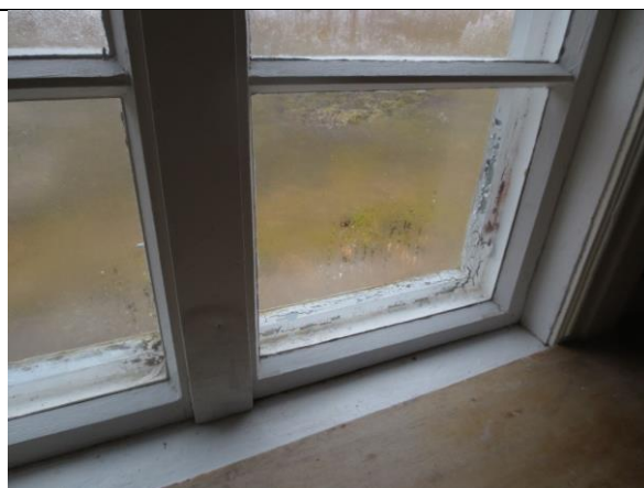
Vindu øst i den eldste delen, trolig fra 1918. En bred list er spikret midt foran rammene, slik at de innvendige varevinduene blir faste. Mye kondens på ytre glass (varierer med værforholdene).
