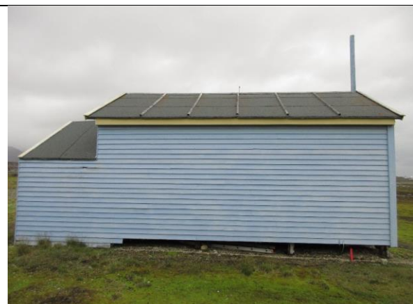
Fasade øst, med sammenhengende liggende kledning på hovedhus og tilbygg. Kledningen går ned til terreng på tilbygget og skjuler fundamentet.
