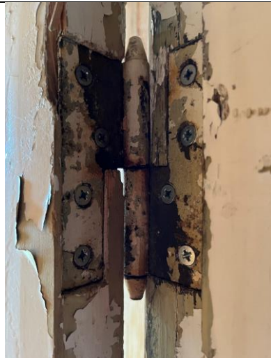
Hengsel i dør har konisk tupp, antatt bevart fra byggeåret, nyere stjerneskruer.
