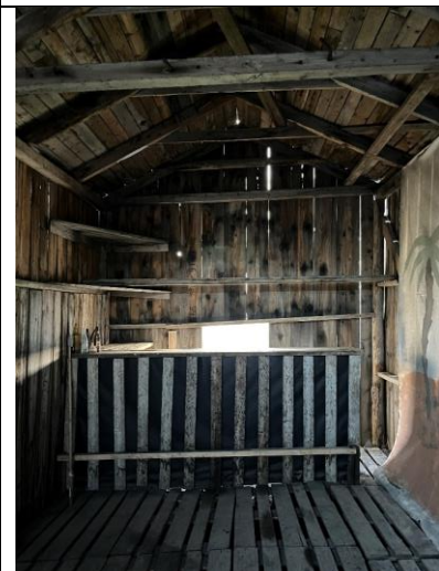
Interiør i søndre naust sett mot en senere bygget bardisk. I bakgrunnen åpen dør mot øst.
