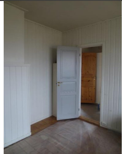
2023: Interiør i 1. etasje, med gammel parkett på gulvet og ellers nyere kledding.
