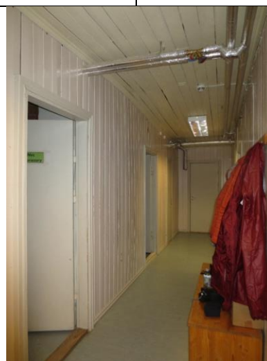
Østre del av midtkorridor i 1. etasje. I enden dør til tilbygg i øst, nå teknisk rom.
