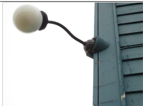
Lampe montert på hjørnene av bygningen. Denne typen er brukt på flere bygninger i Ny-Ålesund, nyere datering.
