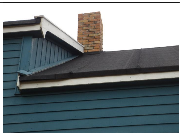
Opprinnelig stående vekselpanel fra 1919 er bevart/synlig på siden av begge takoppløftene. Pipene antas murt på nytt over tak.
