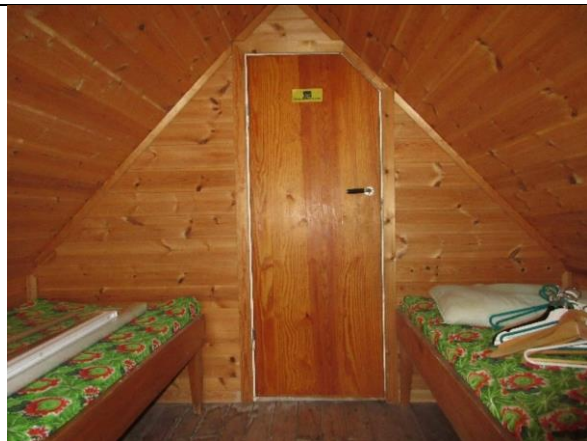
Soverommet mot øst er kledd med skyggepanel fra en senere modernisering.
