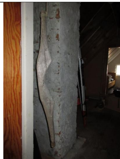
Pipestokk på loft med rester av kalkholdig puss. Foran henger et bøttrøtt brukt til bæring av bøtter.
