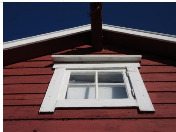
Opprinnelig sidehengslet vindu fra 1919 i gavl, bevart med eikenøtthengsler. Opprinnelig type geriker. Over vinduet er en stokk som tidligere ble brukt til heising av varer til loftet.
