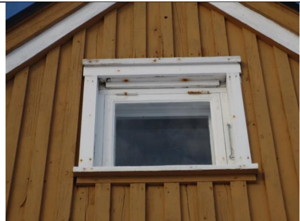
Nyere vindu i loftsgavl mot øst. Karm og listverk bærer preg av noe ombygging. Kledningen på østveggen ble merket, demontert og satt tilbake etter etterisolering i 2013.
