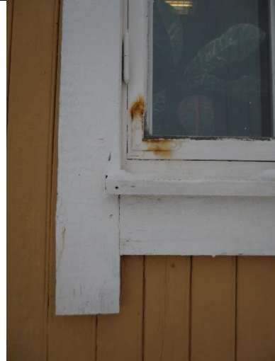
Detalj av vindu med spisse hjørnejern og enkle gerikter.
