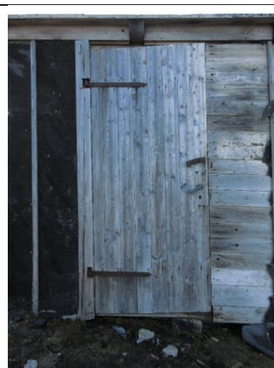
Opprinnelig dør fasade nord i tilbygget øst for kullprammen.
