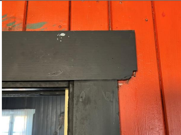
Detalj av rekonstruert gerikt over skyvedør. Negativt spor i malingen kan tyde på at det opprinnelig var en konkav form på hjørnet av øvre bord (utført konveks).
