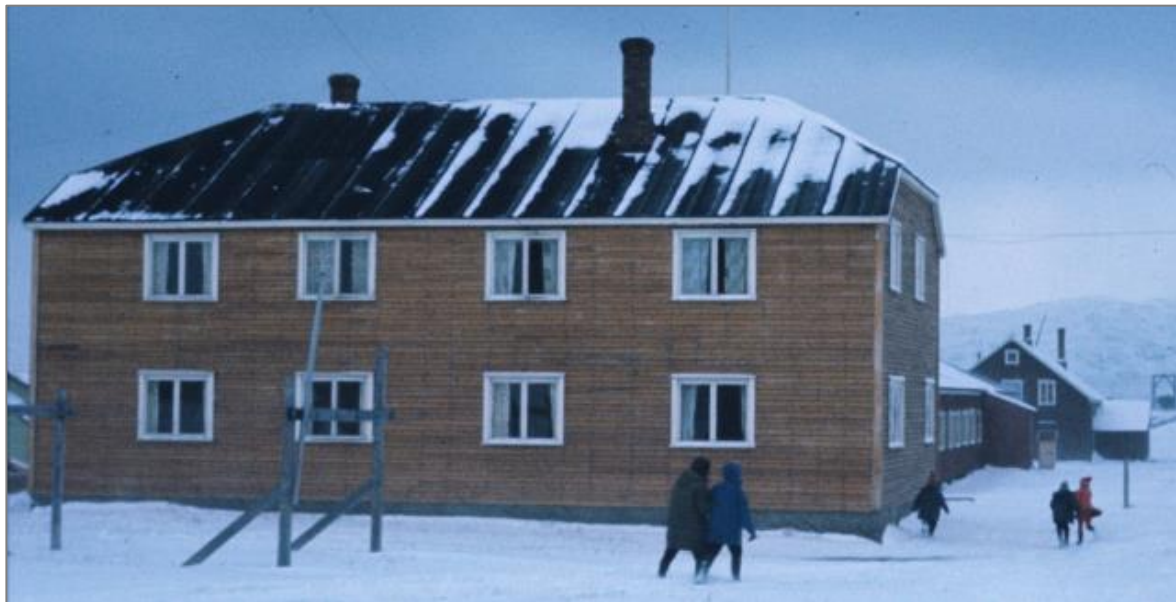
Hotellet i oktober 1960, med nye vindustyper og liggende kledning, som lenge sto umalt. To av fire piper er stadig bevart over tak. Foto: Erling J. Nødtvedt, Svalbard museum SVF 09876
