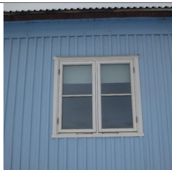
Typisk vindu mot soverom, kopi av opprinnelig inndeling. Koblet vindu med enkelt glass i ytre ramme og innvendig isolerglass.
