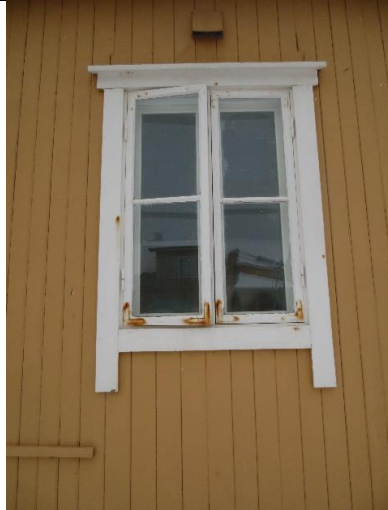
Typisk vindu fra moderniseringen i 1958, bevart med opprinnelige detaljer, beslag og gerikter.
