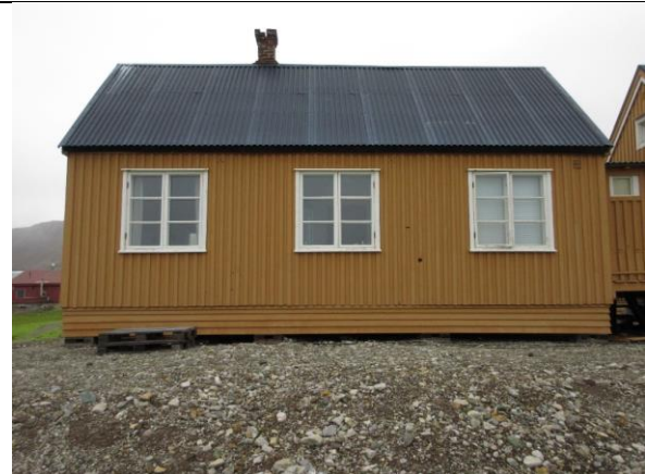
Fasade nord, med tre opprinnelige vinduer.
