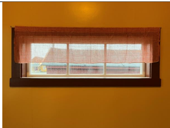
Nyere vindusramme med tre ruter mot øst i stue.
