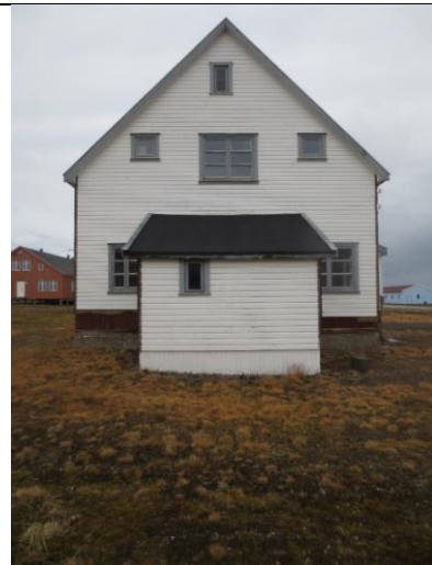
2023: Fasade øst. Loftsvindu fra 1919 er bevart, lite vindu i bislag er fra få år senere, med samme detaljering. Ellers er fasaden preget av endringene i 1959.
