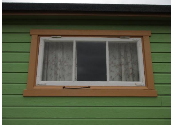
Soveromsvindu mot vest (midtre tilbygde rom), topphengslet ramme med hjørnejern som har spisse ender. Begge vinduer i soverom mot vest er av samme type.
