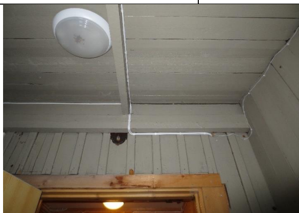
Interiør i bislag, over døra inn til hovedbygningen. Lektepanel på yttervegg og enkel sperrekonstruksjon for pulttak i bislag.
