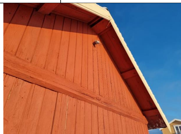
Gavl øst, åser/strøplank i takutstikk. Lemmene i 1. etasje er slisset inn i toppsvilla. Opprinnelig pløyd faspanel på østre hus. Foto: Erki Markson
