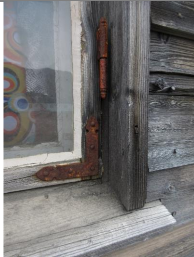
Detalj av vinduet t.v., fint utformede hjørnejern og eikenøtthengsler.
