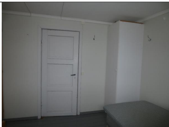
Søndre soverom oppført i 2. driftsperiode, eldre fyllingsdør med usikker datering. Veggene er senere kledd med glassfiberstrie.
