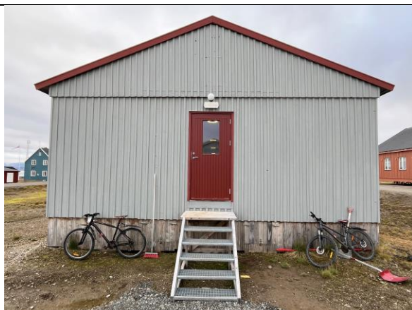
Fasade vest. Like over panelskjøten skimtes spor (skjøt i kledning) etter et eldre tilbygg/bislag. Ny dør 2017.
