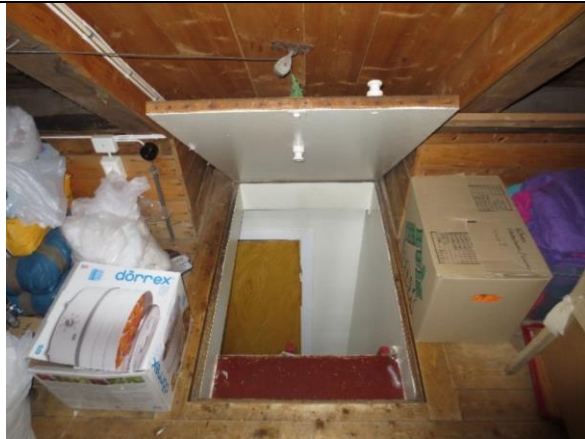
Luke i loftsgulv, med vaier og vekt som holder den åpen. Bratt trestige til 1. etasje.
