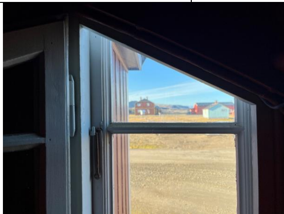
Opprinnelig vindu i bislag vest, vegg mot vest under trappa. Ramma har tidstypiske hengsler og er profilert med staff og hulkil anno 1918.
