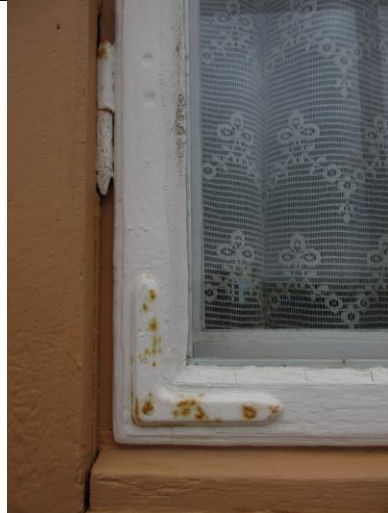
Vindu mot nord, formpresst hjørnejern og hengsel med konisk tupp, typiske detaljer anno 1919 i Ny-Ålesund.
