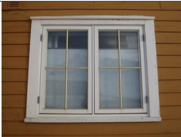
Typisk vindu, med fire høye ruter i hver ramme. Koblet utførelse fra 2006. Sprosseinndelingen er standardisert på alle vinduene og stemmer ikke helt med inndelingen vinduene hadde i 1957.
