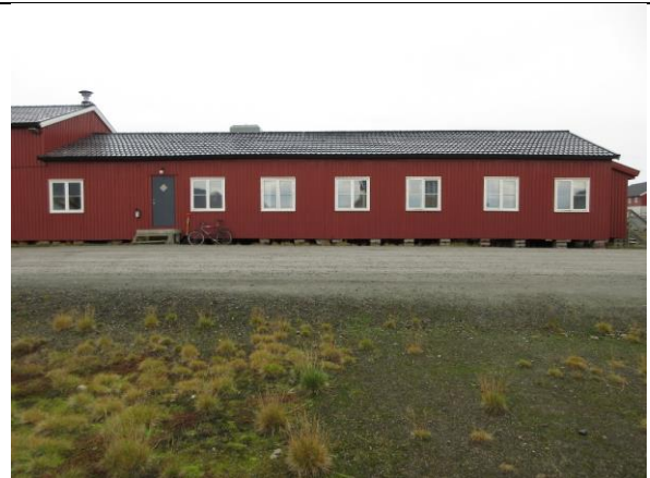
Nordfløyens fasade øst. Opprinnelig volum fra 1945 er intakt, med hovedinngang og vinduer til hybler. Ett vindu t.v. for døra er blendet.
