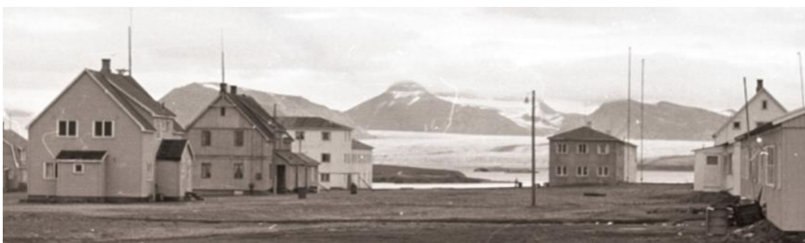
Status 1960: Fra venstre nr. 20 Gult hus med ny liggende kledning, nr. 23 Blått hus med opprinnelig stående kledning, og bak til høyre nr. 21 Hvitt hus med ny liggende kledning. Året etter sto Blått hus for tur til å bli modernisert. Foto: Carl A. Wendt (utsnitt), Svalbard museum.
