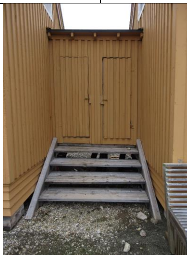
Mellombygget med to labankdører inn til hver av doene. Nyere tretrapp.
