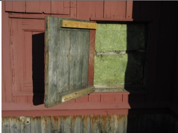
Åpningene bak lukene er etterisolert med mineralull.
