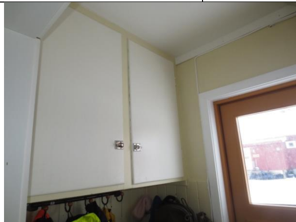
Typisk 1950-talls skap i bislaget, med malte platedører og opprinnelige dørlukkere.
