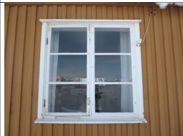
Typisk tofags vindu mot nord. Disse tre vinduene er satt inn ved gjenoppføringen i leiren tidlig på 1950-tallet.
