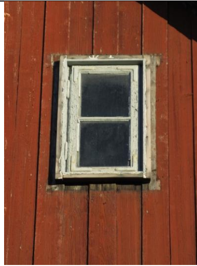
2024: Opprinnelig vindu fra 1919 i loftsgavl mot vest. Formpressete hjørnejern med rund ende, hengsler med konisk spiss.
