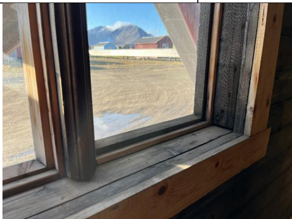
Opprinnelig vindu mot sør i 1. etasje, med fint profilert midtpost. Nyere belistning på innsiden.
