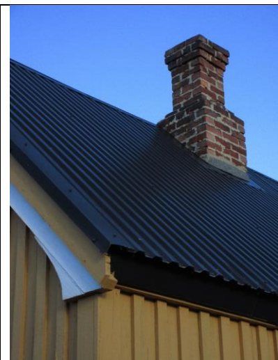
Opprinnelig pipe av blankmur. Nyere korrugerte stålplater fra 1990.
