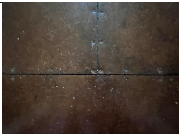
Gulvene i kjøkken og stue er kledd med fastspikrete huntonittplater fra 2. driftsperiode. Disse er ikke malt og gir et svært tidsriktig preg.
