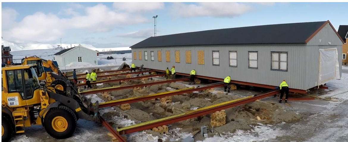
Refundamenteringsarbeidene er i gang. Bygningen ble satt på stålramme og midlertidig skjøvet vekk for å kunne utføre peling av nye stålfundamenter. Foto: Kings Bay AS 2017
