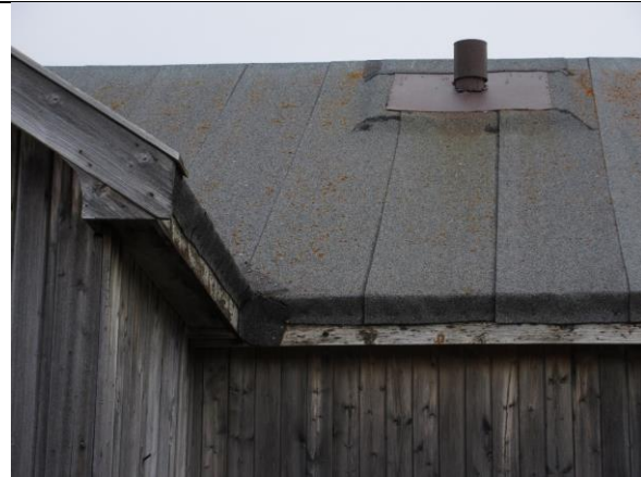
Takpappen er fornyet etter 1992. Piperør og beslag er bevart over kjøkkenet.
