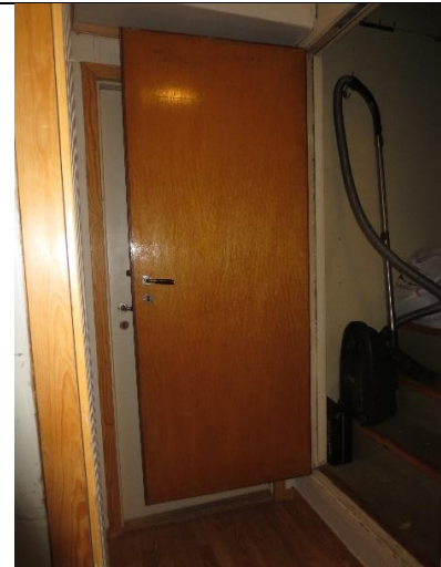
1950-tallsdører i gang 2. etasje, åpen finérdør til loftstrapp.
