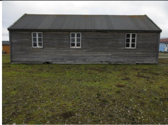
Fasade vest. Liggende kledning ble slått utenpå opprinnelig stående faspanel etter flytting til leiren i 1958.
