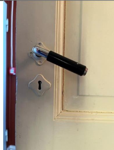
Detalj av boddør vist t.v. Opprinnelige beslag fra 1918, bakelitthåndtaket må være montert i 2. driftsperiode.
