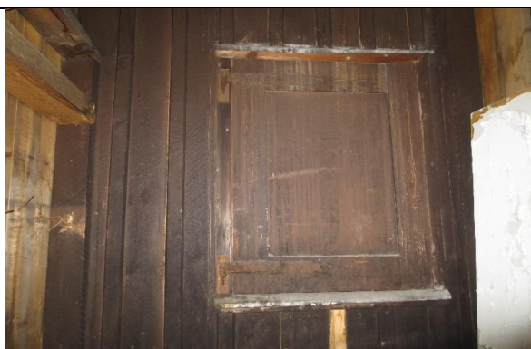
Inne i boden er et opprinnelig vindu. Lektepanel og vinduslem er påført opprinnelig mørk brun overflatebehandling, muligens en tjærebeis, som preget fasaden fram til ca. 1960.
