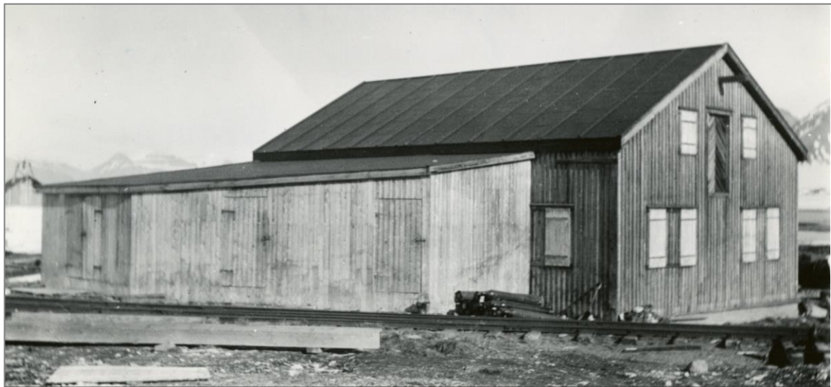
Mellageret i 1935, med tilbygget saltskur for fiskeristasjonen. En linje nederst på kledningen i vestveggen på hovedbygningen kan tyde på at de ytre lektene var montert med noe for korte lengder, som i dag, muligens fordi de ble montert over en eldre plattning. Foto: Arne Brøgger, Norsk Polarinstitutt, NP080000 (beskåret)
