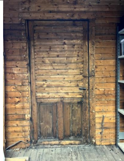
Innside av opprinnelig port fra 1919 i nordre gavlvegg. Ramtrekonstruksjon med seks felt (se eksteriør), liggende kledning på deler av innsiden.
