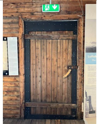
Gammel port i gavl mot sør, tidligere for lasting av varer, nå rømningsvei til utvendig ståltrapp.
