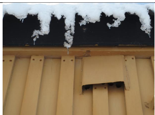
Detalj av ventil med malt beslag/deksel ved siden av vindu mot sør, inn mot opprinnelig soverom i vestre del av huset. Bak beslaget skimtes borehull, slik også andre ventiler er utformet i 1950-åra.
