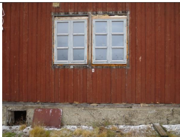
Utsnitt fasade vest, med to nyere vinduer satt inn i ny karm innenfor den opprinnelige, se bildet t.v.
