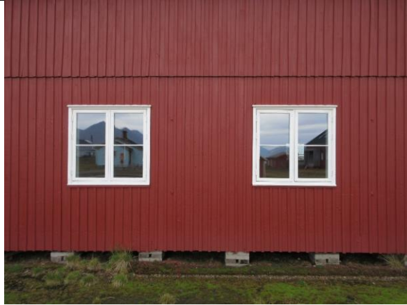
Del av fasade øst, der panelskjøten viser påbygget fra 1962 i salen. Lave boksfundamenter i denne delen. Typiske vinduer som ble fornyet i 2012.
