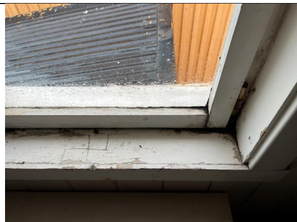
Varevindu i østre gavl. Ytre vindusramme mangler. Et hakekors er risset i malingen i karmen, uviss opprinnelse (neppe historisk verdi).
