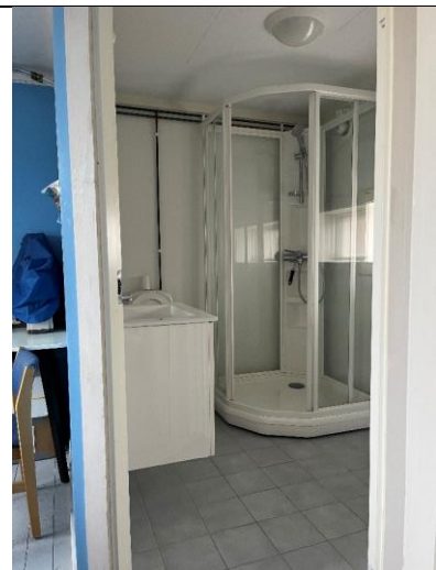
Interiør i nytt bad, innsatt som en boks i rom øst.
