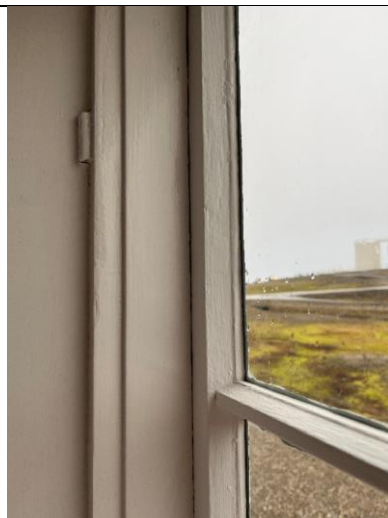
Detalj av vindu mot nord. Varevinduer er demontert.
