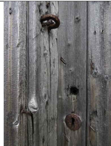
Detalj av opprinnelig/eldre dør i søndre bislag, med eldre låsbeslag. Jernring i vegg. Døra har lenge vært uten bruk.
