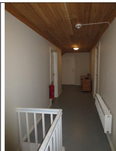
Midtkorridor i 2. etasje/loft, sett mot øst. Rekkverk rundt trappa i forgrunnen.
