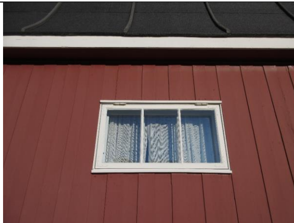
Kopi av liggende vindu mot sør. Dette var skjult bak nyere kledning inntil siste restaurering.
