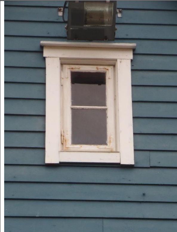
Opprinnelig loftsvindu fra 1919 er bevart i hver gavl. Liggende kledning og gerikter er fornyet i 1961 og er lektet ut, slik at vindussmyget blir dypere.
