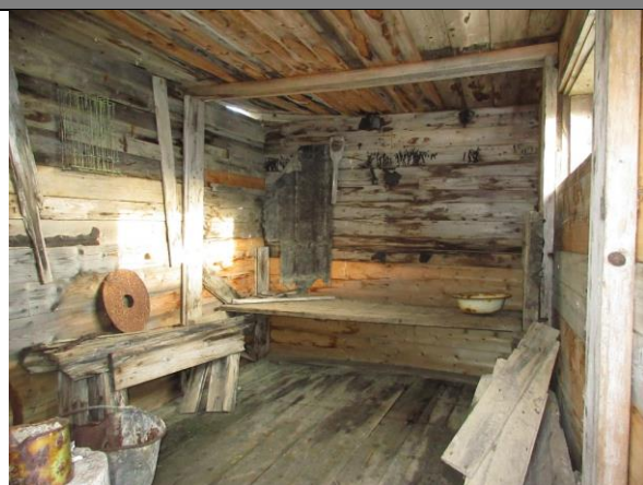
Interiør sett mot nord. Papprest på nordveggen.
