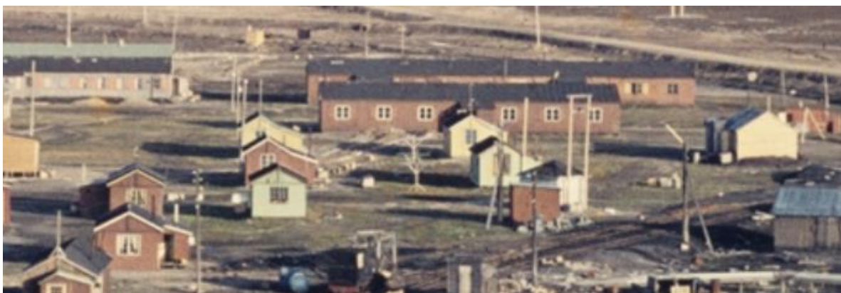
Trønderheimen midt i bildet rett bak hyttebyen, med rødbrun fasade og opprinnelig vindusplassering med bislag med pulttak midt på nordveggen. Foto: Erling J. Nødtvedt 1960, Svalbard museum
