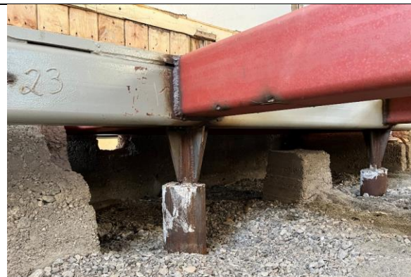
Nye fundamenter av stål. I bakgrunnen ses opprinnelig støpt fundament/pilar midt under huset.
