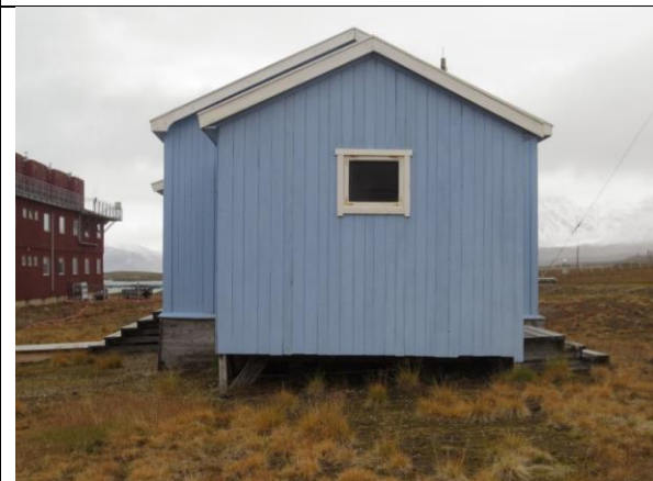
Fasade vest: ny vegg i tilbygg fra 1954, som utvidelse av bislag i boligdelen. Knappe takutstikk med ulike vindskier. Boligdelen har karakteristisk svai nederst, som på andre hus etter krigen.
