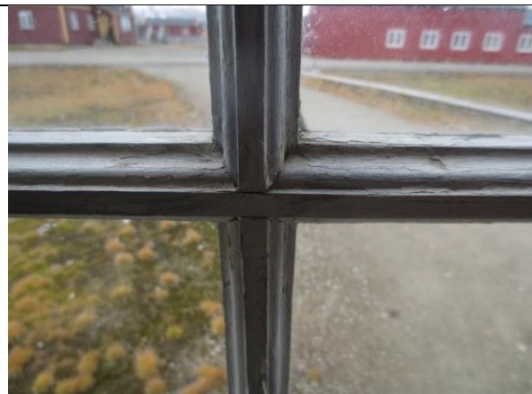
Detalj av vindu i bislaget, karnisslignende profil på srossene. Tilsvarende finnes på noen få hus fra tidlig 1. driftsperiode (i gruveområdet), som nr. 54 Sætra.
