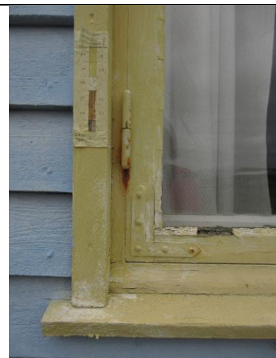
Hengsler og hjørnejern typisk for 1950-tallet. Fargetrapp på karm, Jon Brønne 2023.
