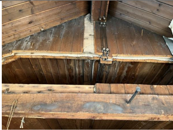
Rester av opprinnelig vestvegg i lemrakka, i sammenbyggingen mellom husene. Åpent røst i lemrakka.
