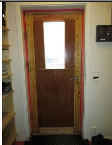
Inngangsdør med huntonittplate og typisk preg av etterkrigstid.
