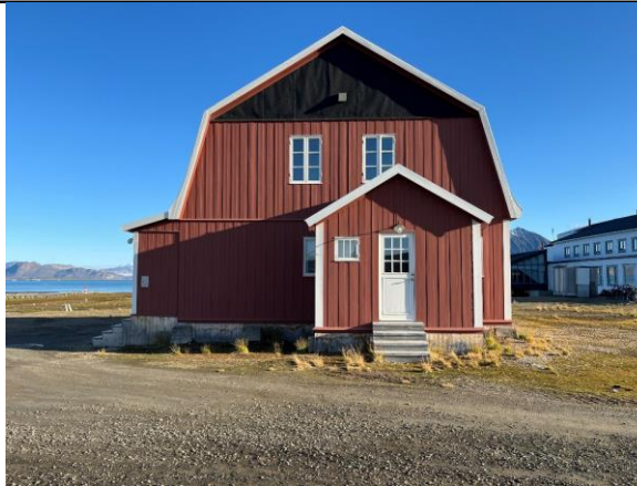
Fasade vest. Opprinnelig bislag var bevart (innebygget) i et større tilbygg, ny inngangsdør ble gjenskaft.
