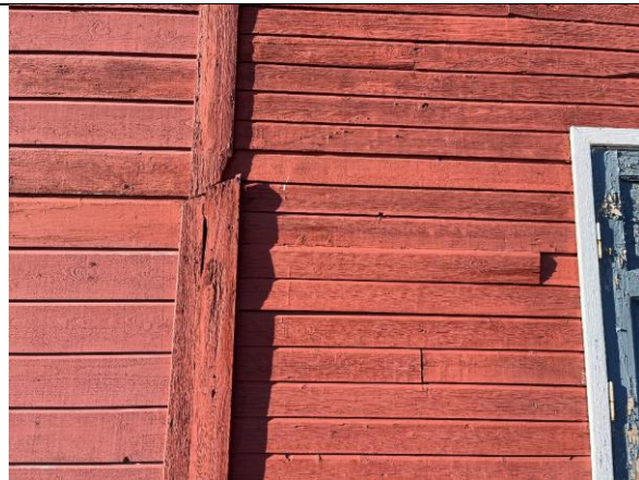
Detalj av vegg ved dør øst, jf. bildene over. Skrå skjøt i stender og spor i panel/maling antyder takformen på opprinnelig bislag med saltak fra 1917–18.
