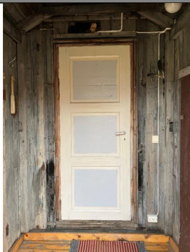
Nyere fyllingsdør fra bislag til kjøkken. Opprinnelig dør var noe større, utføring mot karm.
