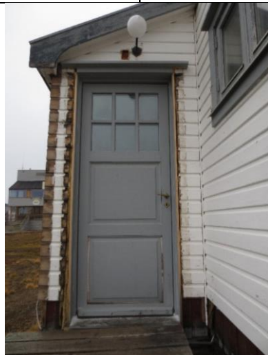
2023: Nyere dør i hovedinngang mot nord. Døra er utført som en forenklet kopi av originalen. Døra ble skiftet ut i 2024–25.
