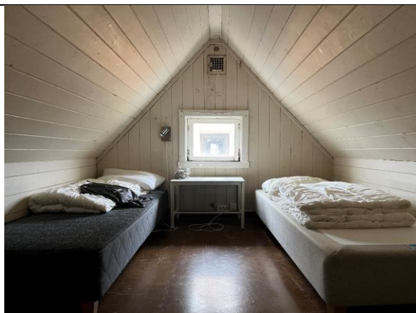
Soverom mot øst på loftet. Vegger og himling med malt pløyd faspanel.
