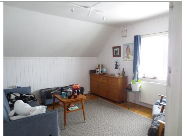
Typisk interiør i 2. etasje, malt skyggepanel på vegg og malte plater i himlingen.
