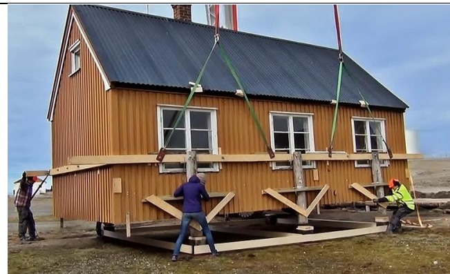
Under arbeid i 2013. Til høyre foto fra håndverkers dagbok, ny drenering, fundament av trepakninger og mye utskifting av råteskadd trevirke i sviller/bjelker i det bærende rammeverket under huset. Foto: Kings Bay AS
