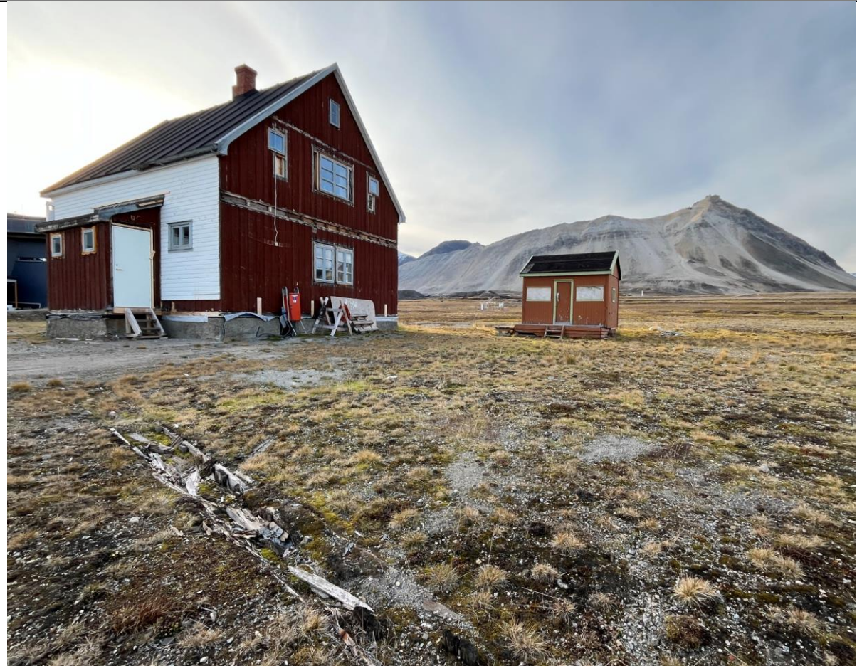
2024: Fra nordvest, hovedinngang i opprinnelig bislag mot nord. Dukkestua fra 1951 til høyre. I forgrunnen ligger rester av en vannrenne av treverk i bakken. Denne er fredet og har høy verneverdi. Huset er refundamentert og satt tilbake på nye stålpeleer, med bevart opprinnelig støpt ringmur fra 1919.
