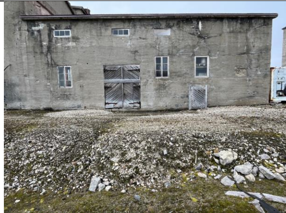
Fasade nord i vestfløy fra 1949.
