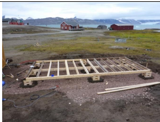
Under arbeid i 2013. Til høyre foto fra håndverkers dagbok, ny drenering, fundament av trepakninger og mye utskifting av råteskadd trevirke i sviller/bjelker i det bærende rammeverket under huset. Foto: Kings Bay AS
