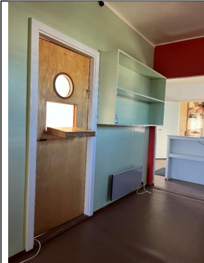
Ekspedisjonen fra 1958, lakkert dør/skranke mot sør. Ny linoleum på gulv. Platekledningen ble istandsatt og malt i 2013.
