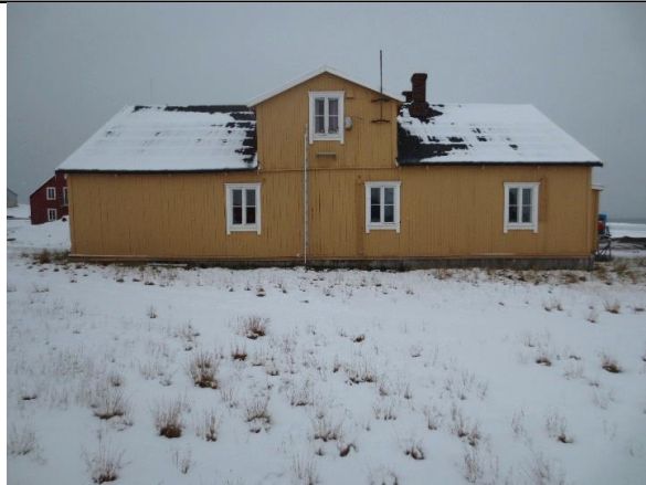
Fasade sør. Bygningens volum og vindusplassering er som opprinnelig, men vindustypene er fornyet i 2. driftsperiode.
