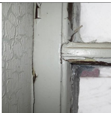
Detalj av vindu fra ca. 1958 i damegarderoben, enkel profilering på ramme og sprosser.
