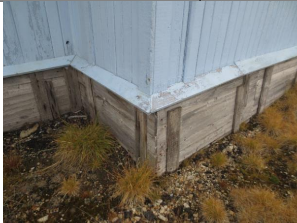
Både telegrafen og boligdelen står på punktfundamenter, som er skjult med et skjørt. Dette består dels av lemmer, som i 1946, jf. foto. Skrå vannbrett er montert utenpå kledningens nedre del.
