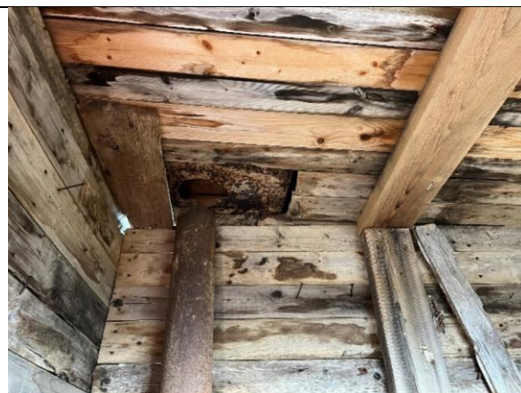
Røykrøret med enkelt beslag i himlingen over ovnen. Innvendig ses fortsatt de nye bordene fra 2004.
