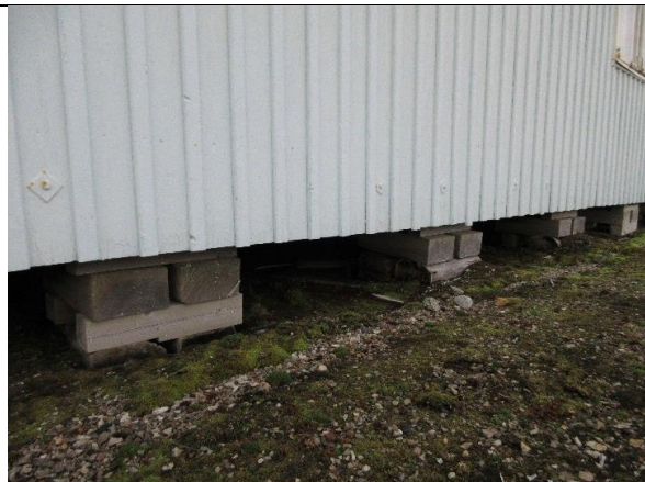
Den opprinnelige brakka fra 1945 er fundamentert på pakninger av krysslagt boks.
