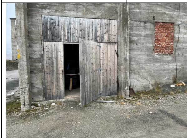
Inngang fasade nord til kraftstasjon 1957. Feltet over portene var tidligere åpent (glass), ref. eldre foto.
