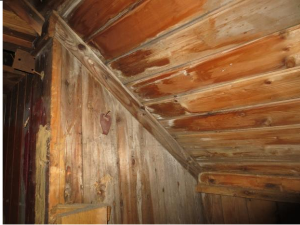
Detalj av vegg og skrå himling i overgang mellom bygningsvolumene ved sørveggen. Veggstumpen fyller ut overgangen mellom husenes ulike bredder. Alderdommelig taklist med hulkil langs skråtak.
