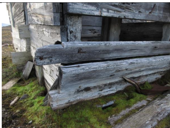
Plank og bord på luftetårnet løsner, antatt lokal råte i gamle spikerhull.
