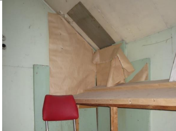
Detalj hjørne nordvest, med rester etter ovnsplass: plateslått vegg og blikkplate foran tidligere røykrør i tak.
