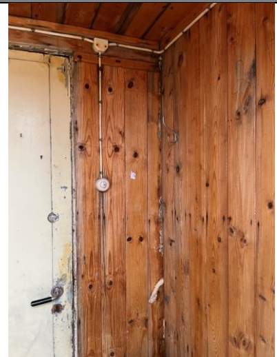
Interiør i bislag med dør til forgang. Umalt faspanel.
