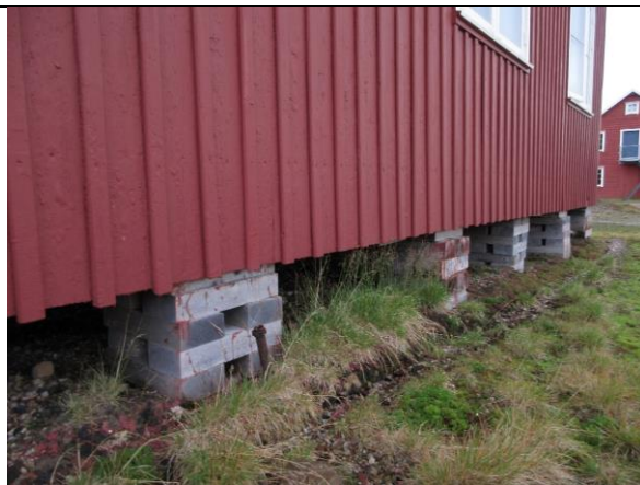
Fundamenter av trepakninger, høyden varierer i forhold til terrengnivået. Malingssøyl på bakken etter oppmaling i 2023.
