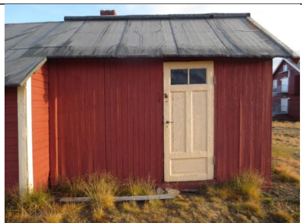
Fasade sør, østre hus. Langvegg med fire lembredder, ei gammel fyllingsdør er tilpasset en lembredde. Opprinnelig inngang til snekkerverkstedet i første driftsfase.
