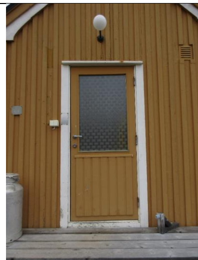
Inngangsdøra er utført som en omtrentlig kopi av 1950-tallsdøra, med isolerglass anno 1984.
