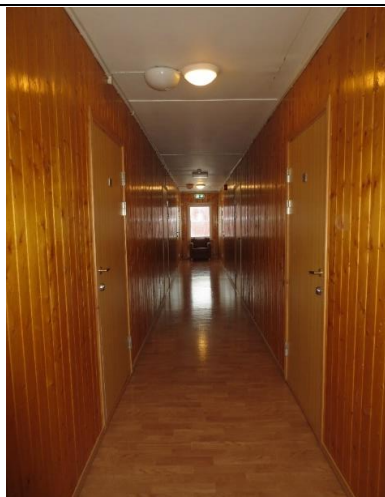
Midtkorridor med opprinnelig faspanel på veggene, ellers nye overflater og dører.
