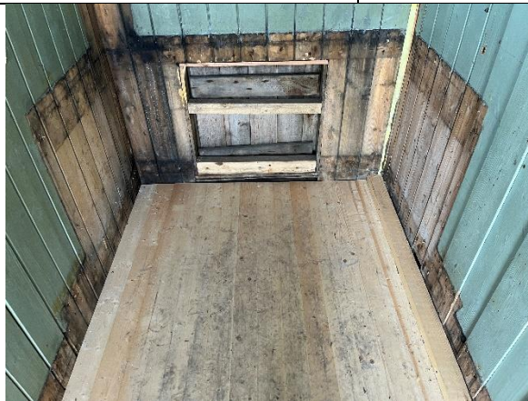
2024: Spor etter opprinnelig dobenk i bislag, bygget før veggene ble malt. Luke i yttervegg. Foran benken ses spor etter et trinn/skammel.
