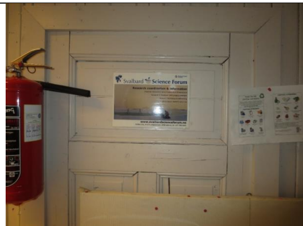
Avstengt dør i nordvegg mot midtkorridor, under trapp. Opprinnelig fyllingsdør anno 1917, nyere listverk.
