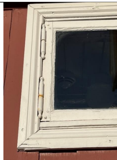
Opprinnelig ettrams vindu til bod, hengsler med kule i enden antas å være fra 1918. Bevarte eldre geriker, usikker datering.
