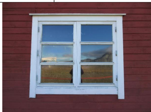
Ett av to isolerglassvinduer fra 1988 i vestveggen, satt inn i forbindelse med ny bruk som museum.
