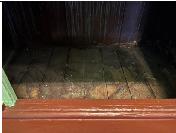
Opprinnelig bordgulv med slitt maling under kjøkkenbenk langs sørveggen, gulvet utenfor skapene er fôret opp.
