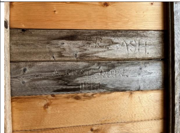
Inskripsjoner er bevart på gamle veggbord i østveggen, like innenfor døra. Antatt skåret av senere besøkende, neppe gruvearbeidere: «S.R. CASH» «A. CHALLINOR»
