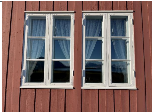
Typiske vinduer, utført som tilnærmet kopier av de opprinnelige, detaljer i innfesting og listverk er som opprinnelig.
