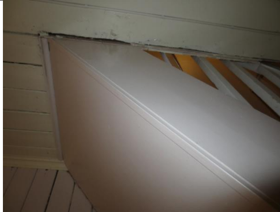
Detalj av underside trapp. Trappeløpet er sekundært tilpasset og skåret ut i himlingen. Mellom veggen og trappa er det rester av eldre trefiberplater, som senere er fjernet. Platekledning og trapp er senere endringer, antatt fra 1958.
