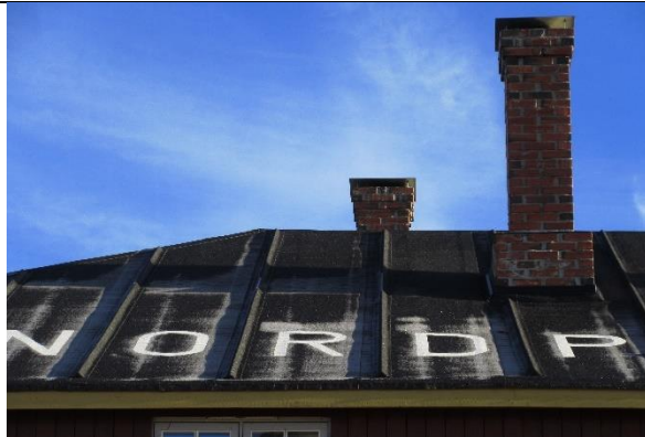
Takkkonstruksjon med opprinnelig halvvalnet form. Taktapp, trekantleker og malt skilt er fornyet i samsvar med opprinnelig løsning, likeså ble fire piper murt på nytt i 1998. (Hvitt snødryss/rim.)
