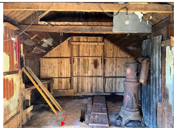
Malerboden sett mot vest og den sekundære skilleveggen mot boligdelen. Rød pil i skille mellom de to bygningsvolumene i gulvet. Her sto det tidligere en yttervegg som tilhørte lembrakka.
