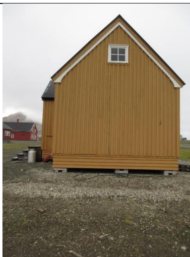
Fasade øst, med opprinnelig loftsvindu.
