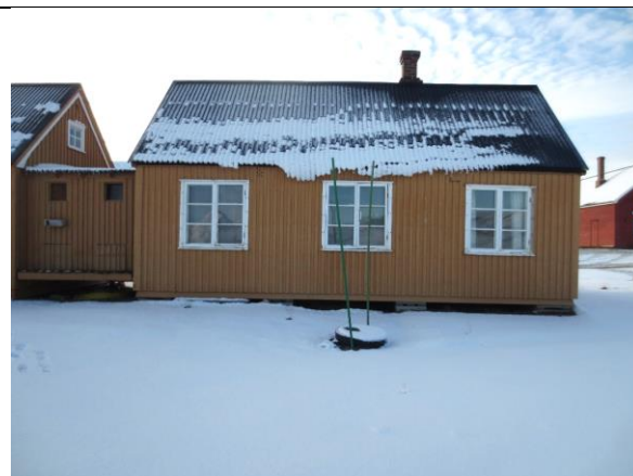
Fasade nord, opprinnelige vinduer fra gjenreisningen i leiren ca. 1950.
