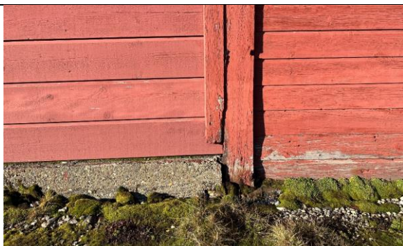
Utsnitt fasade øst. Støpt ringmur på tilbygg 1919.
