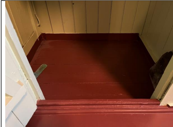
Inne i bod mot øst ses opprinnelig bordgulv. Gulvet i rommet for øvrig er fôret opp og belagt med malte huntonittplater.
