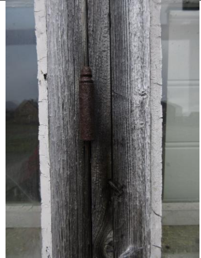
Den ene vindusramma mot øst har eikenøtthengsel. Flytting/gjenbruk av rammer er ikke dokumentert.
