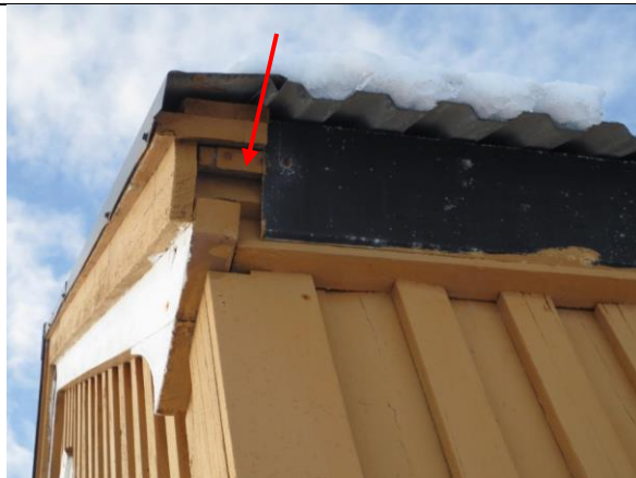
Detalj av takutstikk. Taket er fôret opp og har ny tekking med korrugerte stålplater. Opprinnelig taknivå med tradisjonell takpapp stiftet langs kanten av taktroa (gulmalt) er bevart under (rød pil).
