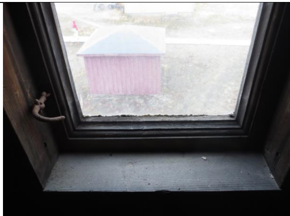
Detalj av opprinnelig vindu i loftsgavl. Rammen er profilert med staff og hulkil, opprinnelige hasper og beslag anno 1919.
