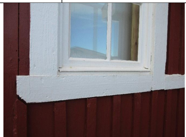
Detalj av fornyet vindu mot nord, etter riving av tilbygg (etter 1973/1992). Noe mindre rammer med innlisting, aluminiumsbeslag og avvikende detaljer.
