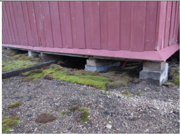
Enkel fundamentering på svillbiter, antatt etablert prinsipp ved justert plassering av hytta etter 1945. Senest utbedret 2023.
