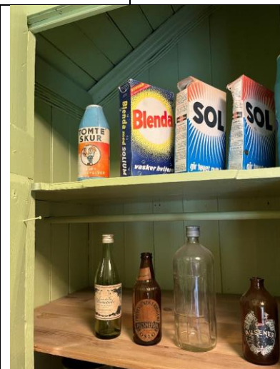
Inne i skapet ser vi bevart vekselpanel på opprinnelig brakke fra 1919. Denne veggen var husets fasade før tilbygg mot sør ble oppført (før 1921).
