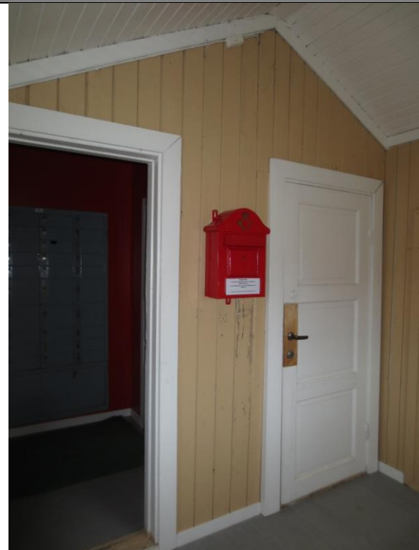
Interiør i bislag sett mot to inngangsdører til hovedhuset. Høyre fyllingsdør er avlåst og ikke i bruk, 1950-tallstype.
