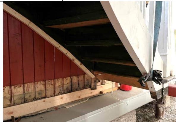
2024: Rødmalt faspanel er avdekket under trappa. Selve trappevingen er nå fundamentert på stålpele.
