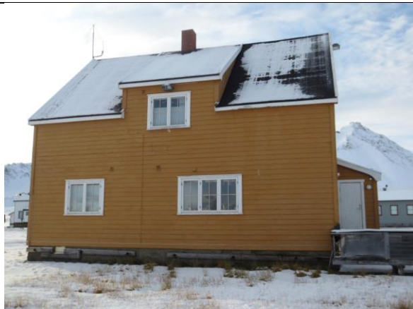
Fasade nord. Her har vindusplassering og takoppløft opprinnelig form. Kledning og vinduer er fornyet i 1957, vinduene er senere skiftet ut med historisk feil utførte kopier med sprosser.
