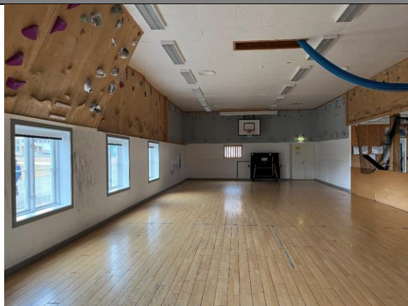
Gymsalen sett mot sør. Alle synlige overflater er fornyet etter 1962, senest rehabilitert i 2012.
