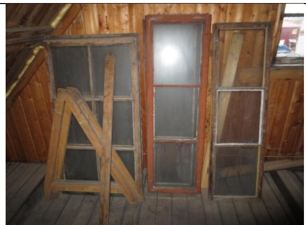
Noen gamle vinduer er lagret på loftet. De høye rammene med tre ruter har trolig stått i Blått hus anno 1919, de har samme type formpresete hjørnejern og hengsler som loftsvinduene. Vinduet med seks ruter har muligens stått i den tilbygde seksmannsbrakke fra 1918. Dette bør undersøkes nærmere..
