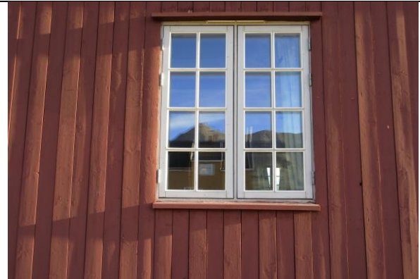
Typisk kopi av vindu og vekselpanel, laget i 1998 etter forbilde av opprinnelig utforming i 1919.
