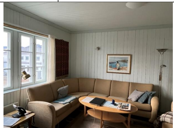
Interiør i stue, romløsningen er som opprinnelig. Ytterveggene ble etterisolert i 2010 og opprinnelig faspanel gjenbrukt så langt det var mulig.
