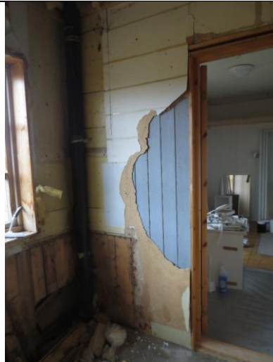
2023: Skillevegg 1. etasje, opprinnelig faspanel avdekkes bak nyere platekledning.
