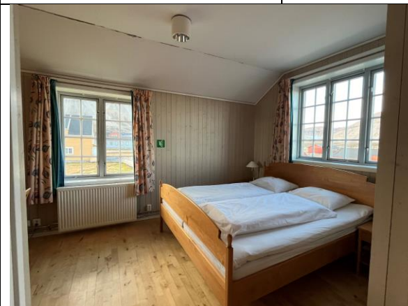
Hotellrom i 2. etasje, med opprinnelig brukket himling under hanebjelken. Alle flater er fornyet.
