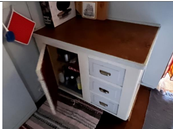
Den gamle kjøkkenbenken har huntonittplate på benken og innside dør. Tidstypisk interiør fra 2. driftsperiode.
