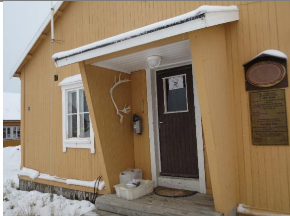
Hovedinngang vest, der dør og takoverdekning er fra moderniseringen i 1957–58. Nyere lampe under himling.
