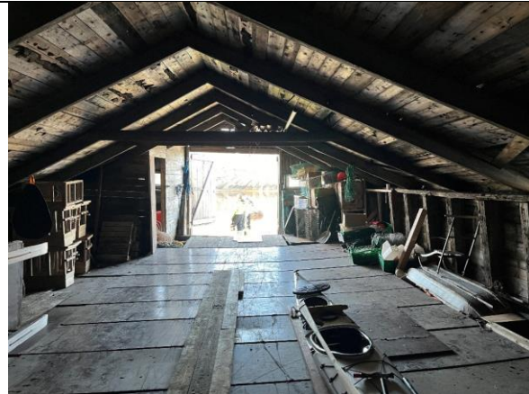
Interiør i kullpramnaustet, mot åpen port i vest.
