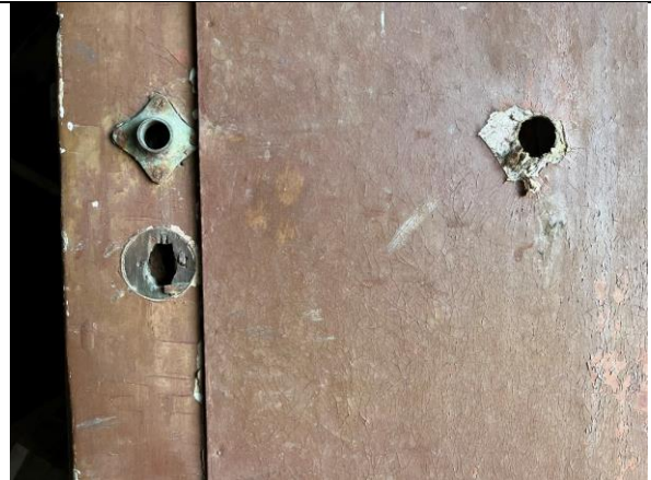
Detalj av døra vist over, typisk låsbeslag fra første byggefase i Ny-Ålesund (1917–19). Fyllingsdør kledd med huntonittplater, se foto neste side.
