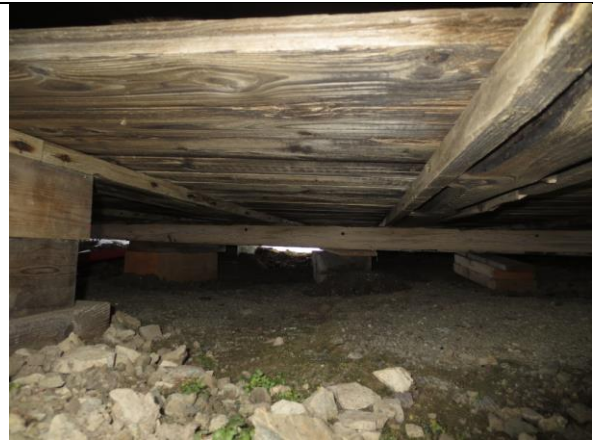
Fundamenter av boks/plank, bjelkelag med opprinnelig stubbloftsgulv. En lang bjelke ligger på langs midt under huset, som opprinnelig.
