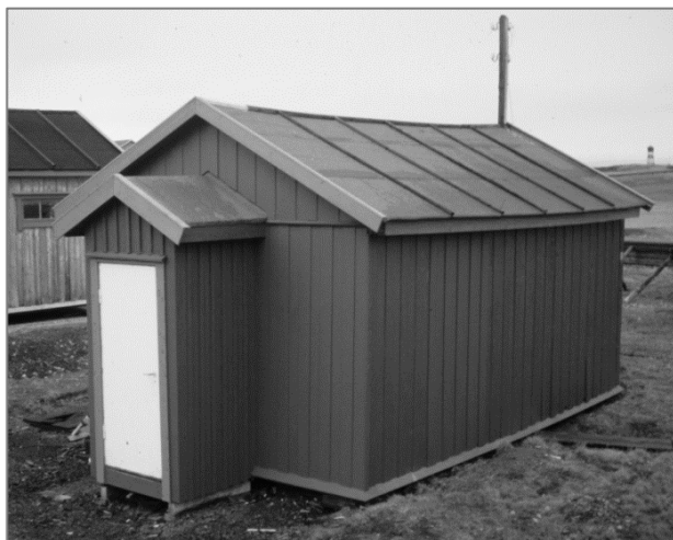
Nr. 5 Arbeiderbrakkka etter restaurering 1988, nytt bislag med midlertidig platedør. Foto: Dagrún Grønbech, Svalbard museum, SVF 23588
