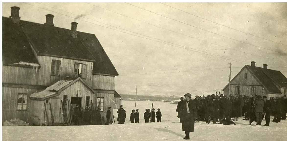
Foto 1925–26, Gult hus t.v. og Blått hus t.h. Huset har stående kledning, som er umalt, og vinduer med tre ruter i hver ramme. Det er et lite tilbygg med pulttak vest for bislaget. Foto: Hans Ragnvald Hjelle, Norsk Polarinstitut, np036968 (beskåret)
