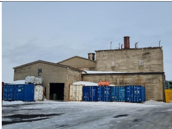
Anlegget sett fra vest, saltaksbygningene fra 1949 til venstre. I bakgrunnen ses den runde pipa som trolig er bevart fra 1928. Stålpipa over 1957-stasjonen. Foto: Ingrid Rekkavik 2023
