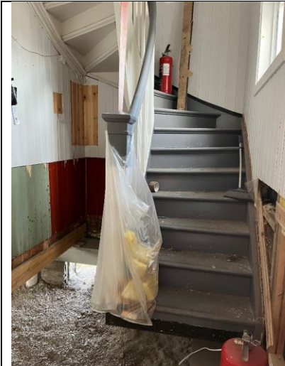
2024: Trapperommet etter refundamentering og noe avdekking av opprinnelig panel på vegg.
