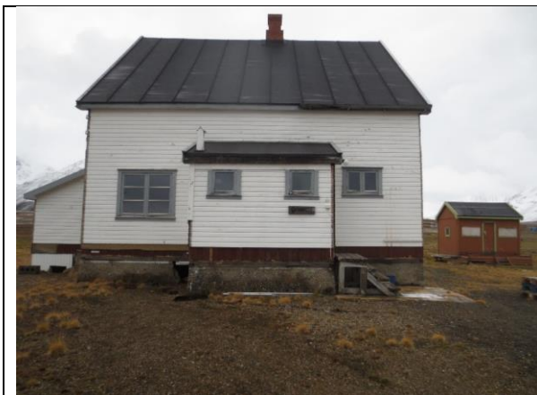
2023: Fasade nord. Det er to opprinnelige bislag med pulttak, mot nord og øst (til venstre). Takrenne over trapp/inngangsparti på hovedhuset.
