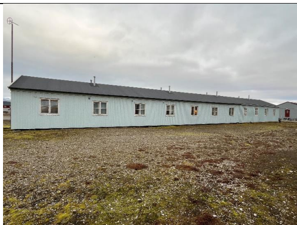
Fasade sør, den opprinnelige svenskebrakka utgjør de syv vinduene i vestre del.
