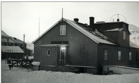
Observasjonsplattform fra 1966 over ark mot nord, med bøyte for «All-Sky kamera». Over tilbygg/bislag mot øst ses spor etter opprinnelig bislag, se foto fra 1973 neste side. Ei rørkasse går inn på hjørnet av nordveggen. Vi ser fortsatt spor etter disse endringene i dagens kledning. Bildet t.h. fra sørvest. De to pipene vest for arken er revet over tak. Begge foto: Jens Angard / Asgeir Brekke 1967, Kings Bays arkiv
