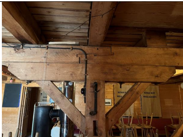
Typisk stolpe med kryssavstiving i 1. etasje, krysslågt bjelkelag. Bjelken har skrå hakeskjøt over søylen.
