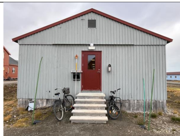
Fasade øst. Også her skimtes spor etter opprinnelig tilbygg/bislag, se detaljbilde neste side.
