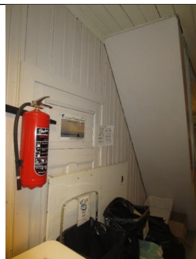
Del av midtkorridor i 1. etasje, med avstengt dør under trappa til loftet.
