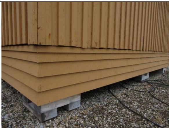
Da bygningen ble refundamentert og hevet ble det bygget et høyere skjørt av liggende bord foran fundamentene.
