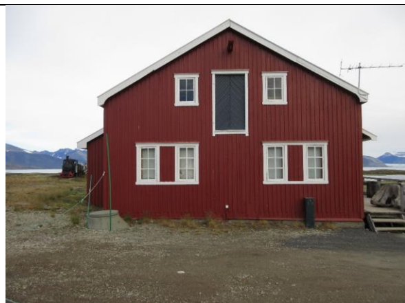
Fasade vest. Fasaden er tilnærmet som opprinnelig, med forbehold om ombygging av dører/vindusfelt i 1. etasje, se foto 1920. Tidligere vinduslemmer er fjernet på hele bygningen.
