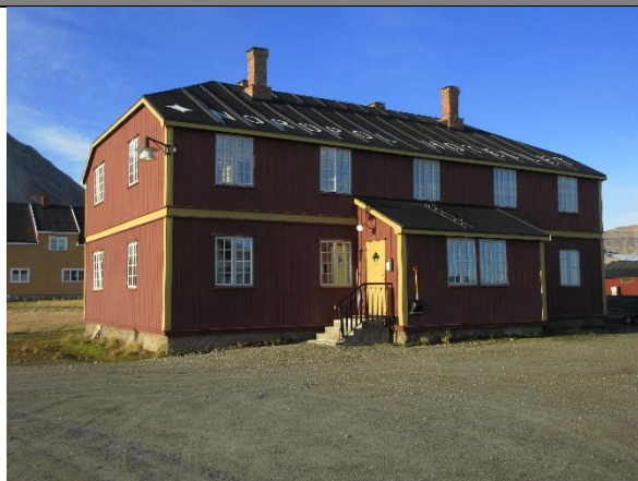
Fra nordvest. Hovedvolumet og bislag er bevart med opprinnelig grunnmur, med tilbakeført kledning og vinduer fra 1998/2013.
