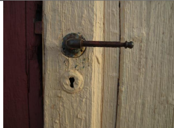
Eldre dørhåndtak, se foto interiør. Blå maling skimtes under på dørbladet, som dokumentert i 1999.
