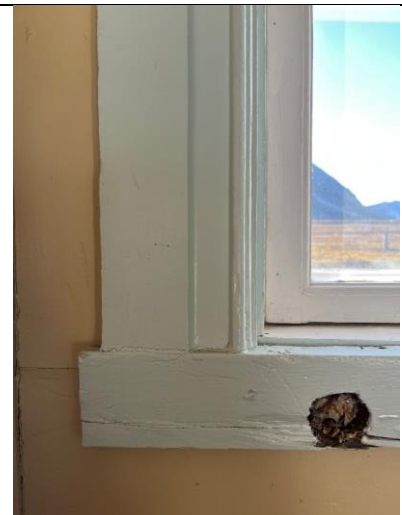
Fint profilerte gerikter på begge vinduer i kjøkkenet, antatt bevart fra 1929.
