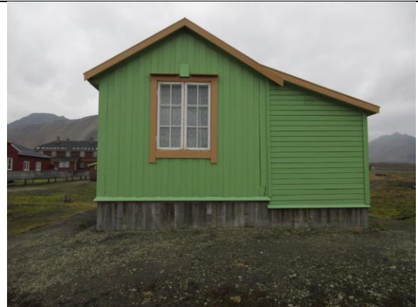
Fasade nord. Opprinnelig brakke anno 1919 med saltak og opprinnelig vekselpanel, vindu og ventil. Tilbygget soverom med pulttak til høyre. Vinduet er unikt som det eneste bevarte fra de fire opprinnelige brakkene anno 1919.
