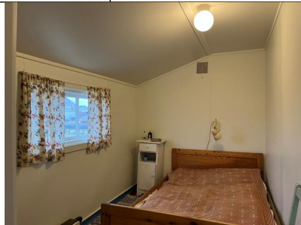
Nordre soverom, siste tilbygg mot vest oppført kort etter 1955. Alle flater er kledd med huntonittplater, typisk for 2. driftsperiode i Ny-Ålesund.
