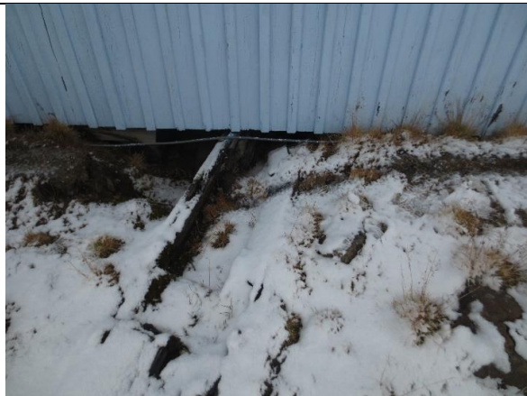
Rester av vannrenne av tre skrår inn mot bygningens sørvegg, tidligere brukt til utslagsvann fra kjøkken.
