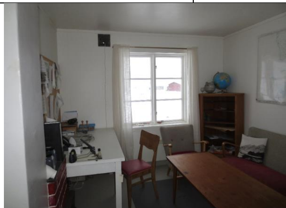
Stua sett mot nord. Nye huntonittplater fra 2013 på alle flater.
