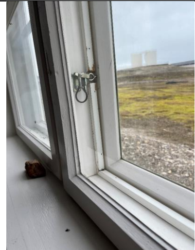
Typisk vindu mot nord. Eldre yttervindu og nyere varevindu.
