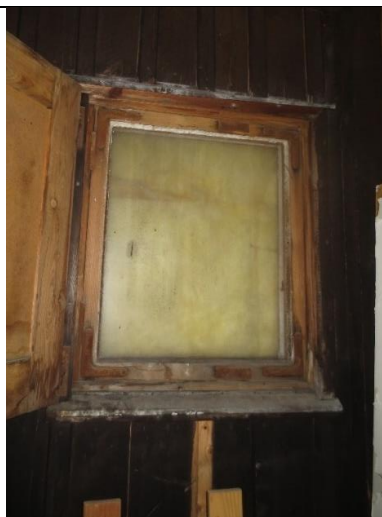
Opprinnelig vindu i bod, med åpen lem av huntonittplate i treramme. Formpressete hjørnejern.
