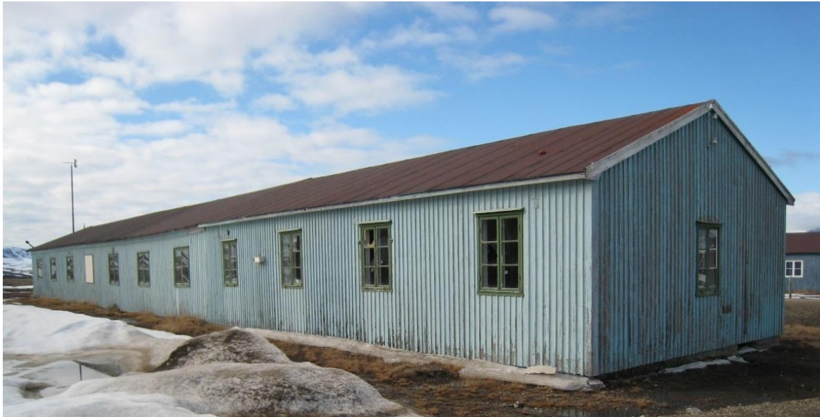
Slitt eksteriør i 2008, før istandsetting. Bygningen hadde rød takpapp og grønnmalte vinduer. Foto: Siri Hoem
