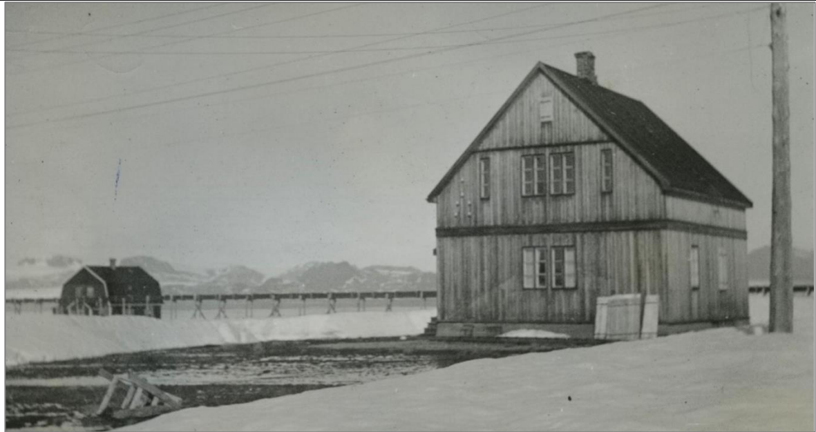
Hvitt hus fra sørvest slik det faktisk ble bygget i 1919 (udatert foto noe senere). Fasadene hadde umalt stående vekselpanel og opprinnelige vinduer med tre ruter i høyden. Loftsvinduet i gavl er skjult bak en lem. Kledningen ble etter hvert malt engelsk rød med grønne vinduer. Foto: NN, Svalbard museum (beskåret)
