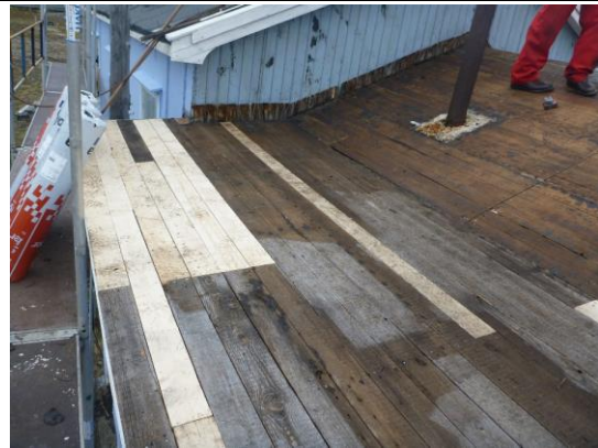
T.v.: Under restaurering 2013. Spor i malingen etter vannbrettet, montert et stykke opp på kledningen, som utført ved flytting 1946. Negative spor etter stedstypiske gerikter. T.h.: Utbedring av taktro over bislaget mot sør. Taket fra 1918 (med røykrør) har liggende taktro, (ikke lemmer). Foto: Kings Bays arkiv
