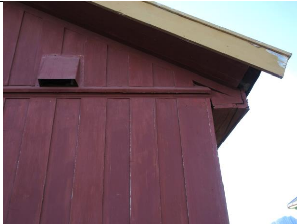
Detalj av opprinnelig kledning fasade nord. Gesimsbånd med karnissprofil fra 1918, samme detaljer som på nr. 14 Amundsenvillaen. Stedstypisk ventil med deksel.
