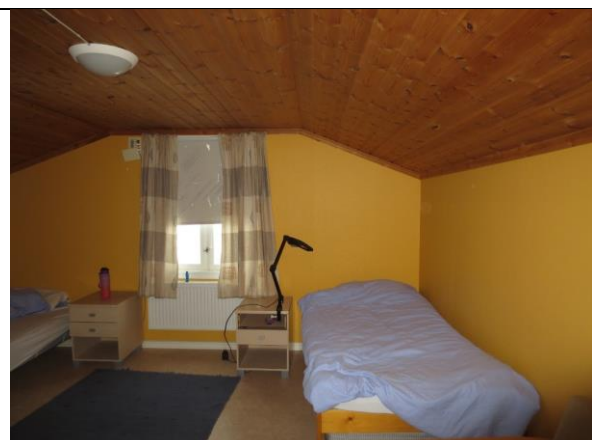
Himlingen i ark mot nord har flatt midtparti, som gjenspeiler ombyggingen med plattform over tak i 1966.
