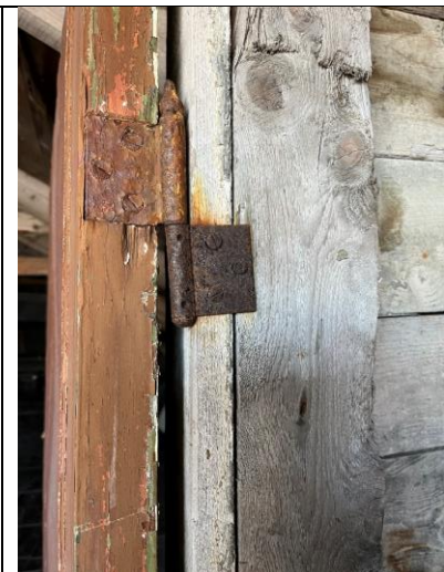
Detalj av hengsel på fyllingsdør, den på dørbladet har opprinnelig dråpehengsel, mange strøk maling.
