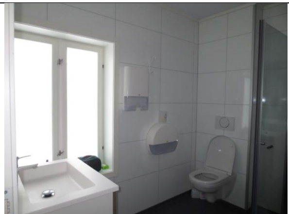
Badene ble totalrehabilitert i 2020, med nye fliser og våtromsinnredning.
