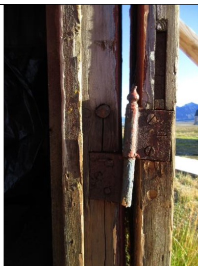
Dråpehengsel i sveitserstil, typisk tidlig 1900-tall. Hengsler i karm er uten dråpe, antatt smidd på stedet. Ramtredør med sliss/tapp.
