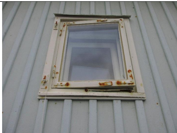
På hver side av inngangsdøra er det to små opprinnelige vinduer til boder. Hengsler og typiske svenske formpressete hjørnejern anno 1945, samt hengsler i karm etter tidligere vinduslem.
