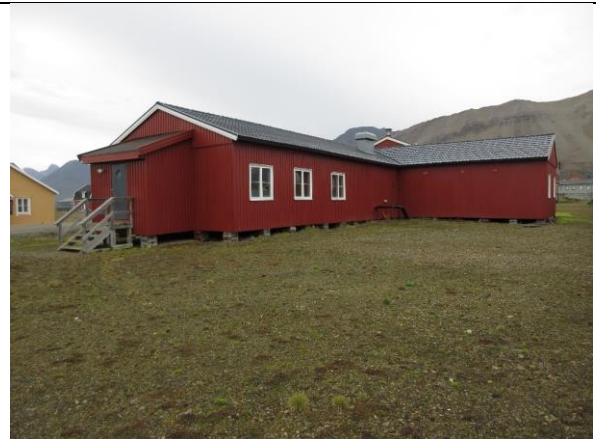
Fra nordvest. Nordfløyen med hybler og tverrfløyen har samme volum som i 1945. Fire opprinnelige vinduer i tverrfløyen er senere blendet, og bislaget ved kortveggen er fornyet og noe utvidet.
