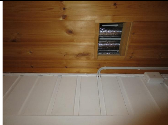
Detalj av nedfôret himling av skyggepanel, ventilasjonsrør over.
