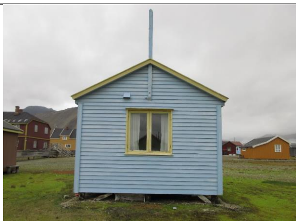
Fasade nord med hyttas eneste vindu. Dette er fornyet i 2. driftsperiode til en enkel torams type uten sprosser. I 1918 hadde opprinnelig vindu samme størrelse, men med seks ruter i hver ramme.
