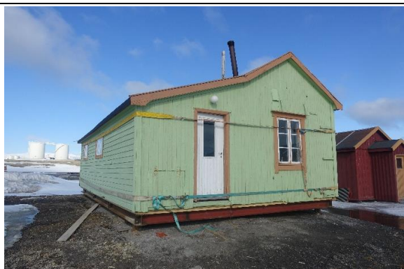
Forberedelse til refundamentering 2019. Trepakninger fra 1987 ble erstattet av stålramme og stålplater. Høyre bilde viser hytta sikret med jekkestropper og satt på stålrammen, før peling. Foto: Kings Bay AS
