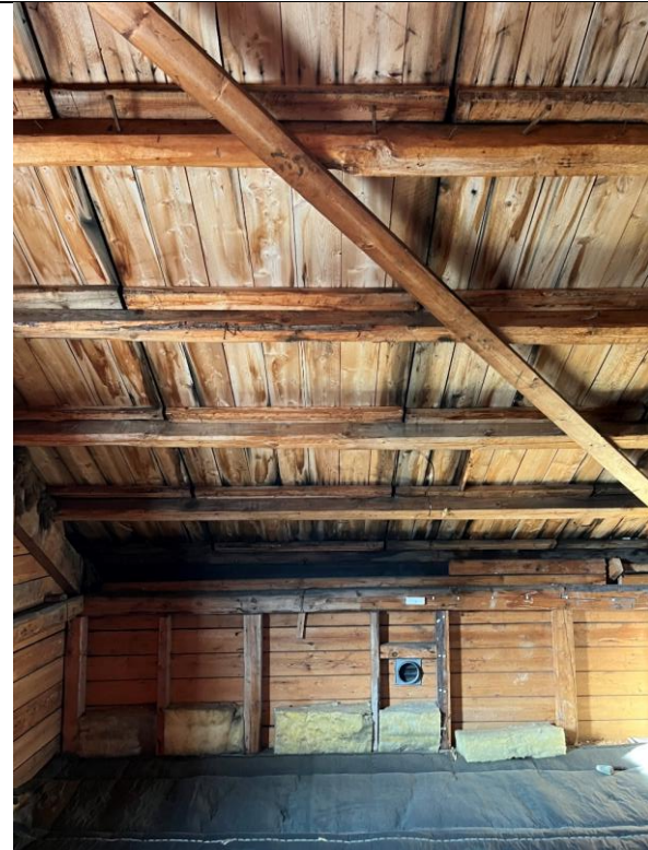
Takflatene består av 105 cm brede lemmer med stående bord. Tverrliggere/spikerslag i lemmene ligger an over takåsene.
