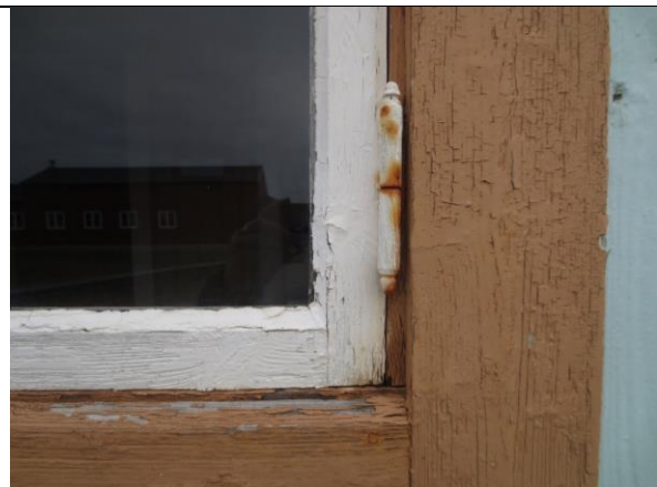
Detalj av vindu i bislag, opprinnelig ramme med eikenøtthengsel, typisk for årene omkring 1920.
