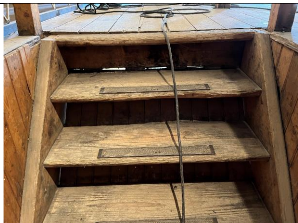
Øvre del av loftstrappa.
