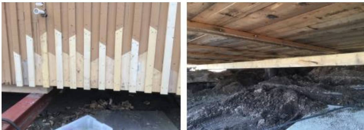
Under refundamentering og reparasjon av kledning i 2015. Kilde: Vabøs rapport 2015. Kings Bays arkiv.
