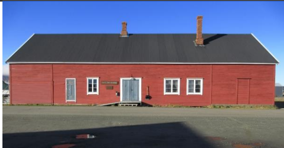
Fasade øst. To opprinnelige bislag er revet, og dør til butikken anno 1919 i nord (t.h.) er blendet.
