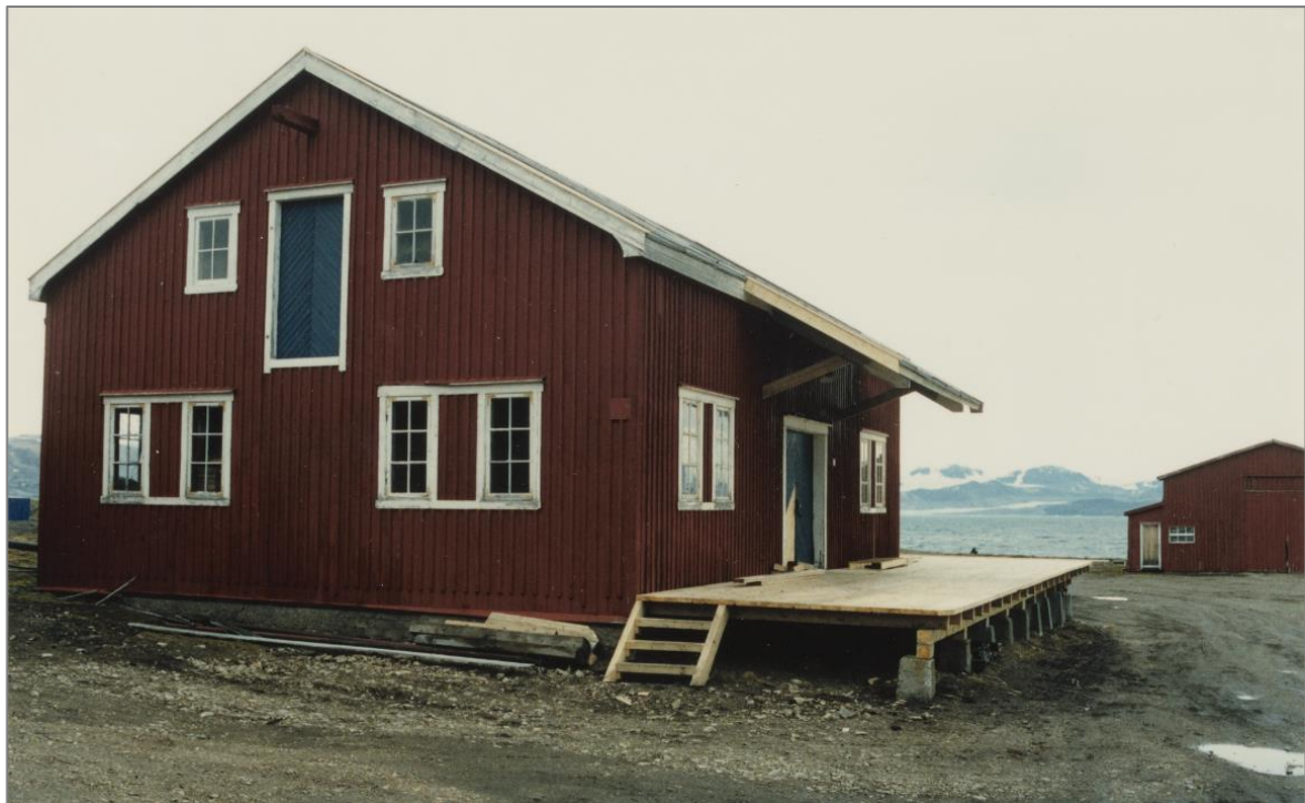
Under ombygging til kafé i 1992. Plattingen er istandsatt og hevet, med nytt plankegulv og trapp. Skjermtaket over inngangen fornyes, antatt kopi av opprinnelig konstruksjon. Noen panelbord i skyveporten er skiftet ut. Foto: P. Bakke 1992, Riksantikvarens fotoarkiv
