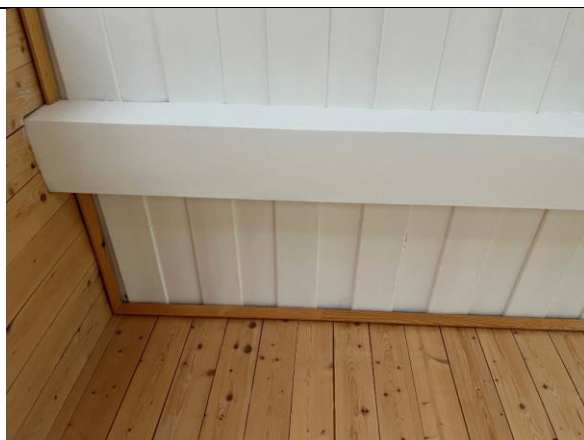
Oppholdsrom vest med malt vekselpanel i himling, samme avrundete kant som i gymsalen anno 1962.
