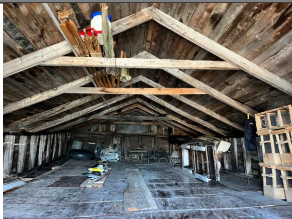
Interiør i kullpramnaustet. Finérplater er spikret på spantene/bjelkene på gulvet.
